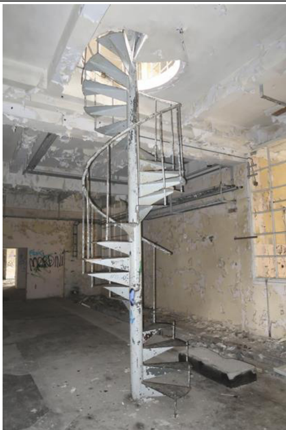
Fot. 157. Stalowe schody kręcone na I piętro zlokalizowane w osiach C-D/9-10 (część A budynku).
