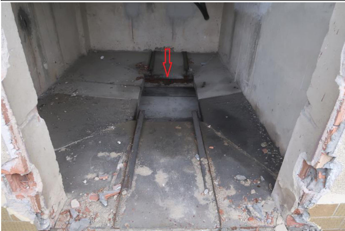
Fot. 99. Korozja podkonstrukcji stalowej w pomieszczeniu w osiach E'-F'/19-20 na parterze (część B budynku).
