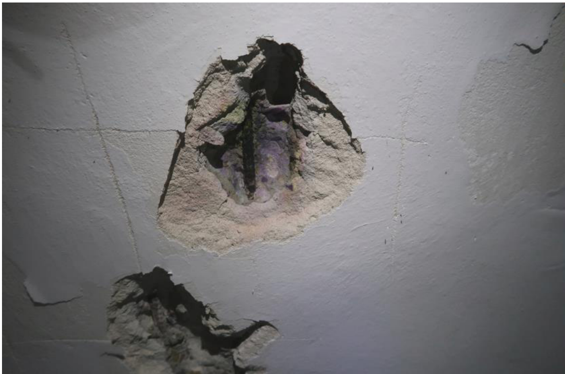
Fot. 79. Odkrywka O.55 stropu. W odkrywce stwierdzono płytę żelbetonową zbrojoną dołem prętami żebrowanymi #10 w rozstawie co 12,0÷16,0cm (kierunek zbrojenia prostopadły do elewacji) oraz prętami rozdzielczymi \phi 6 . Otulina zbrojenia wynosi 10mm. Tynk c-w gr. 2,0cm. Występuje karbonatyzacja betonu w warstwie otuliny zbrojenia.
