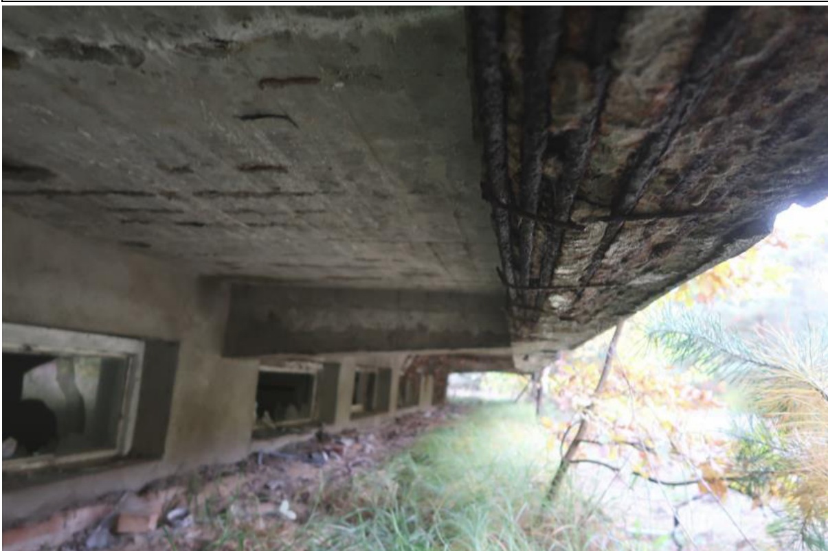
Fot. 91. Odparzony tynk i otulina zbrojenia oraz skorodowane zbrojenie na belce rampy na zachodniej elewacji w osiach B/19-21 części B budynku.
