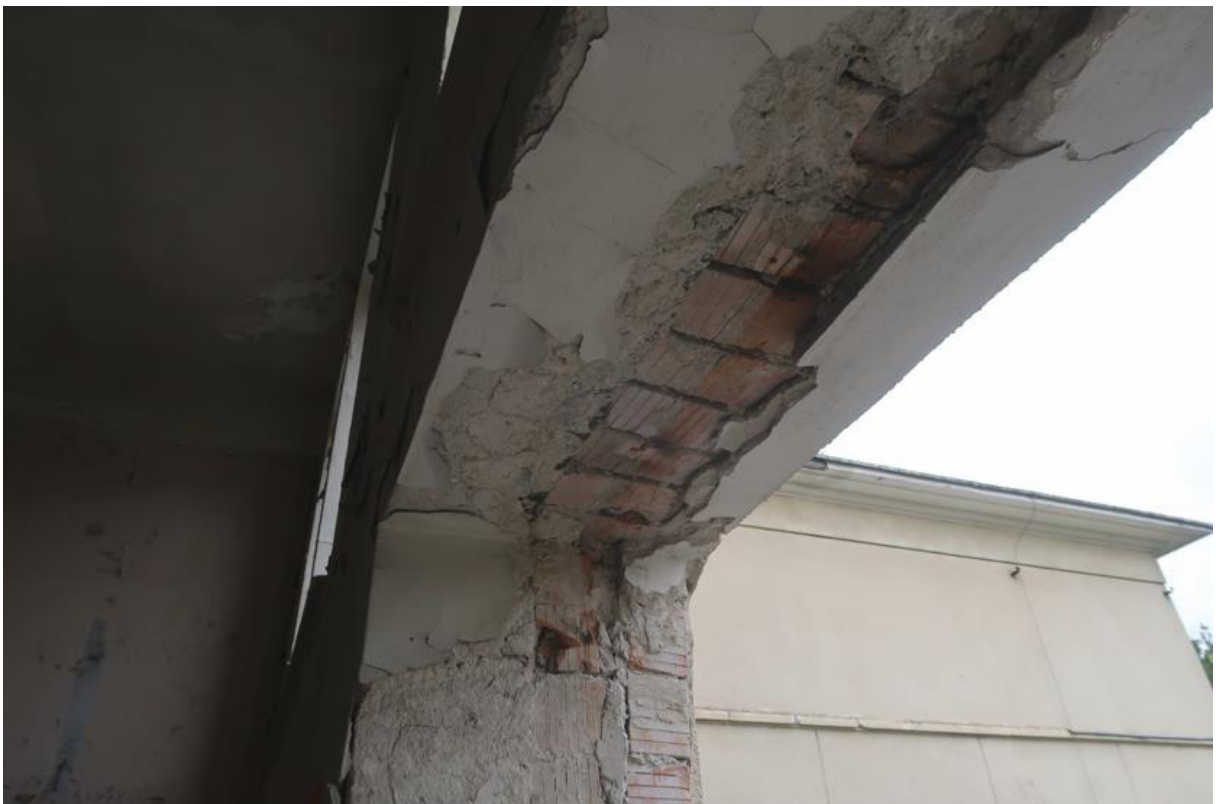
Fot. 56. Odparzony tynk na spodzie nadproża w osiach D/2-6 na I piętrze. Widoczne nadproże płaskie z pustaków kratowych.
