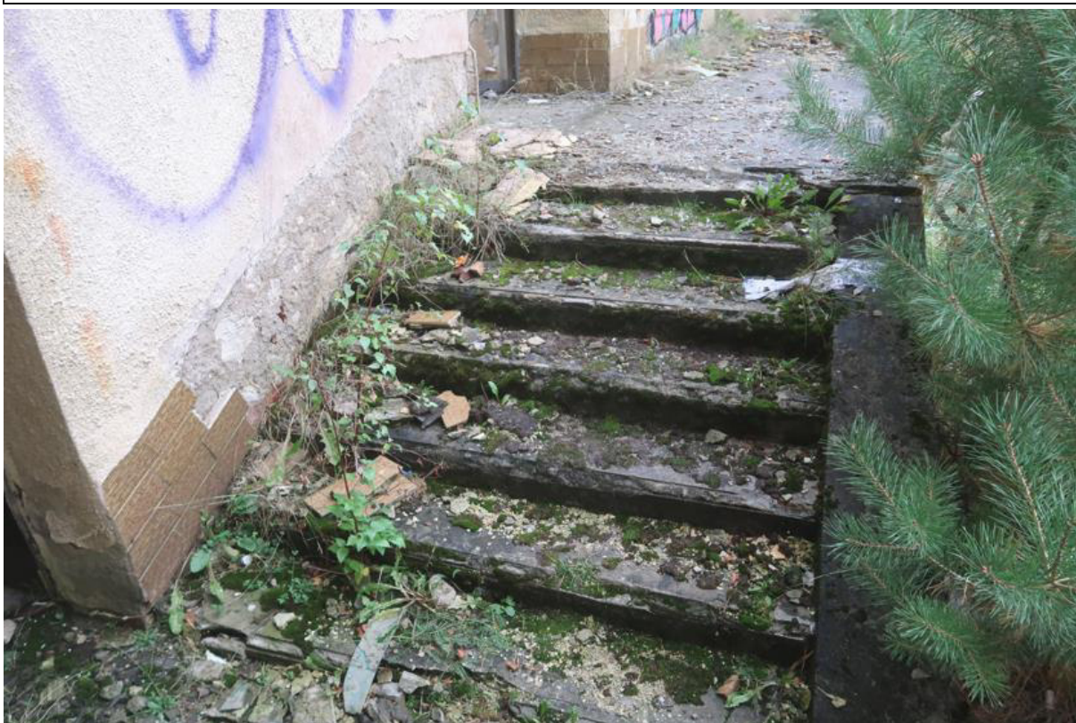
Fot. 153. Zerodowane żelbetowe schody terenowe na rampę na zachodniej elewacji w osiach 14-15 (część B budynku).
