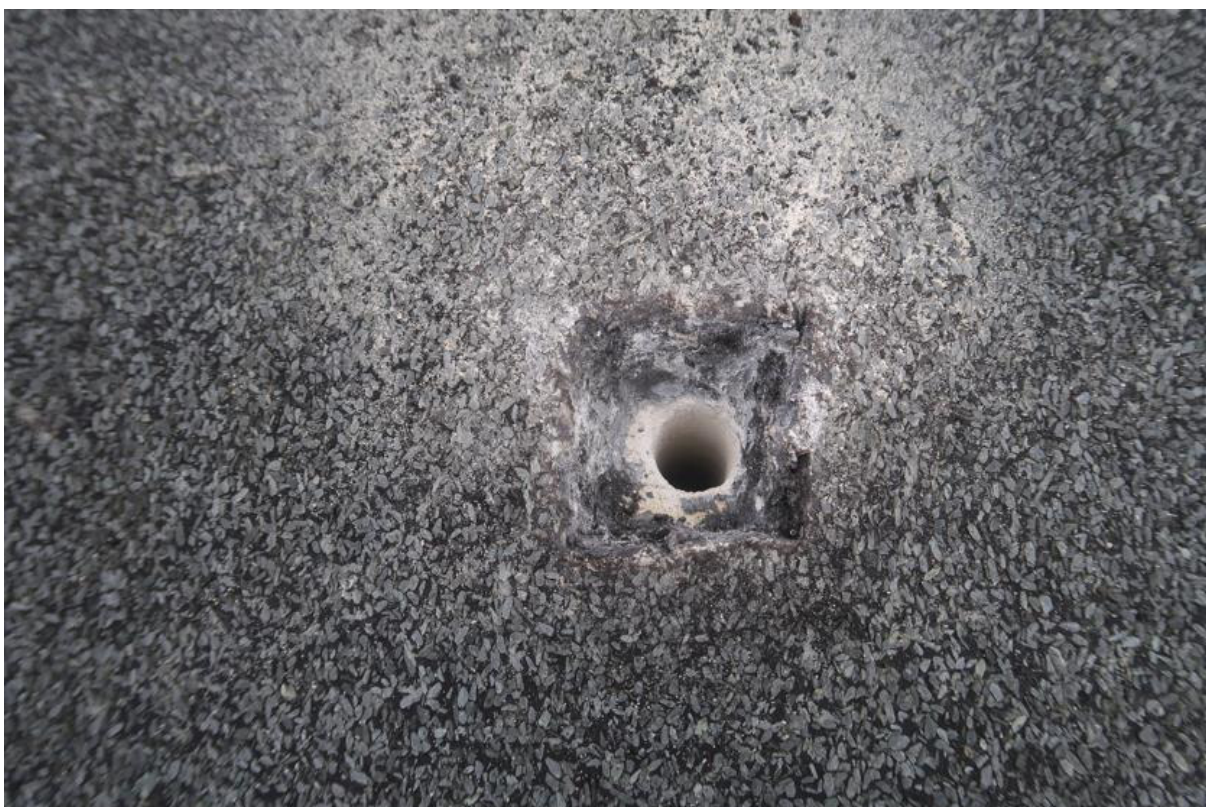
Fot. 167. Odkrywka O.81 stropodachu. Stwierdzono pokrycie z 3x papy, wylewki cementowej gr. 6,5cm i izolacji termicznej z płyt suprema gr. ~10,0cm leżącej na wierzchu stropu Teriva.
