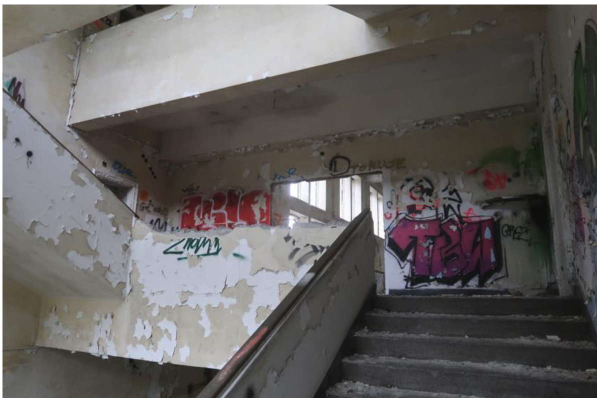
Fot. 156. Schody trójbiegowe łamane o konstrukcji żelbetowej zlokalizowane w osiach C-D/1-2 (część A, główna klatka schodowa). Widoczne balustrady żelbetowe wykończone drewnianym pochwytem oraz odparzona farba na schodach.
