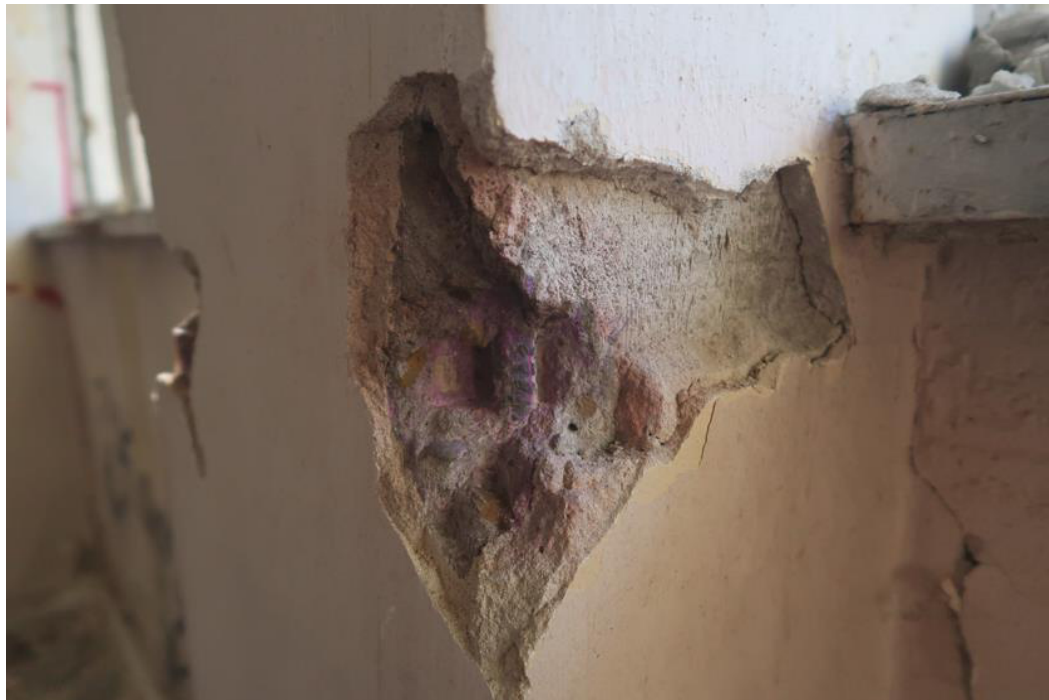
Fot. 108. Odkrywka O.13 słupa. W odkrywce stwierdzono słup żelbetowy o przekroju 38,0x41,0cm (pomiar z tynkiem gr. 1,0÷2,0cm), zbrojony podłużnie prętami żebrowanymi #14 (2 pręty na krótkim boku). Otulina zbrojenia wynosi 20÷30mm. Występuje karbonatyzacja betonu w warstwie otuliny zbrojenia. Do słupa jest dostawiona zewnętrzna ściana murowana z betonu komórkowego o gr. 14,0cm wraz z tynkiem.
