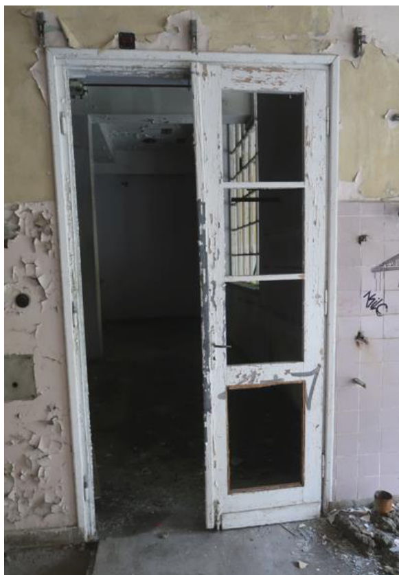
Fot. 164. Ubytki w szkleniu stolarki drzwiowej wewnętrznej w osiach B-C/10 na parterze (część A budynku). Widoczna złuszczone farba na starej drewnianej stolarki drzwiowej.
