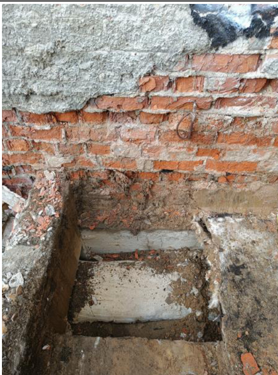
Fot. 17. Odkrywka F.3. fundamentów. W wykonanej odkrywce stwierdzono ścianę fundamentową murowaną z ceramicznej cegły pełnej, z poziomą izolacją p.wilgociową z papy ok. 30cm p.p.t. Na głębokości ok. 50,0 cm p.p.t. stwierdzono kanał instalacyjny wzdłuż ściany budynku.
