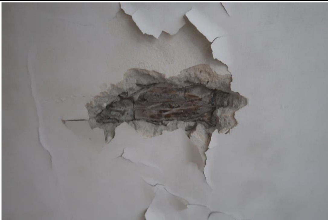
Fot. 83. Odkrywka O.63 stropu Kleina. Stwierdzono płyty gruzobetonowe gr. 5,0cm. Tynk c-w gr. 1,5cm na siatce stalowej. Płyty oparte na dolnych półkach belek stalowych wykonanych z dwuteowników IPN240, skorodowanych powierzchniowo. Belki w rozstawie co ok. 110cm. Na płycie jest zlokalizowany stropodach wentylowany, z polepą gruzową z wiórami gr. 15,0cm oraz pustką powietrzną w miejscu odkrywki o wysokości ok.65,0cm.
