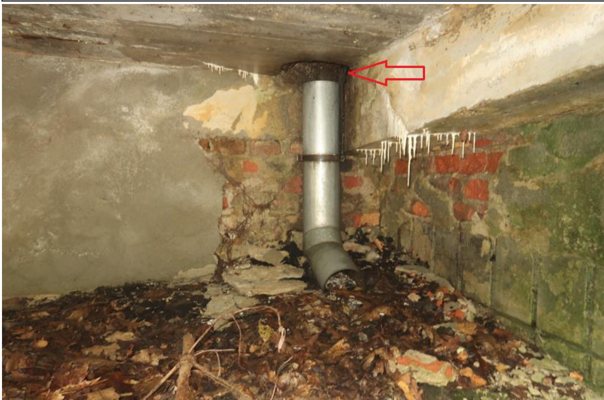
Fot. 180. Brak ciągłości rury spustowej w rejonie rampy w osiach 2-4 (część A budynku). Widoczne zawilgocenie, odparzenie tynku oraz wysolenie na spodzie belki wspornikowej rampy.
