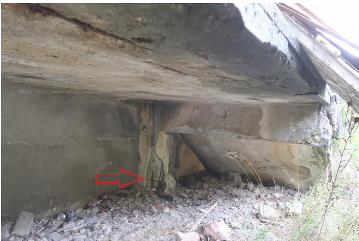
Fot. 124. Odparzony tynk i otulina zbrojenia oraz korozja prętów zbrojeniowych słupa w poziomie terenu pod rampą w osiach B/9 (część A budynku).
