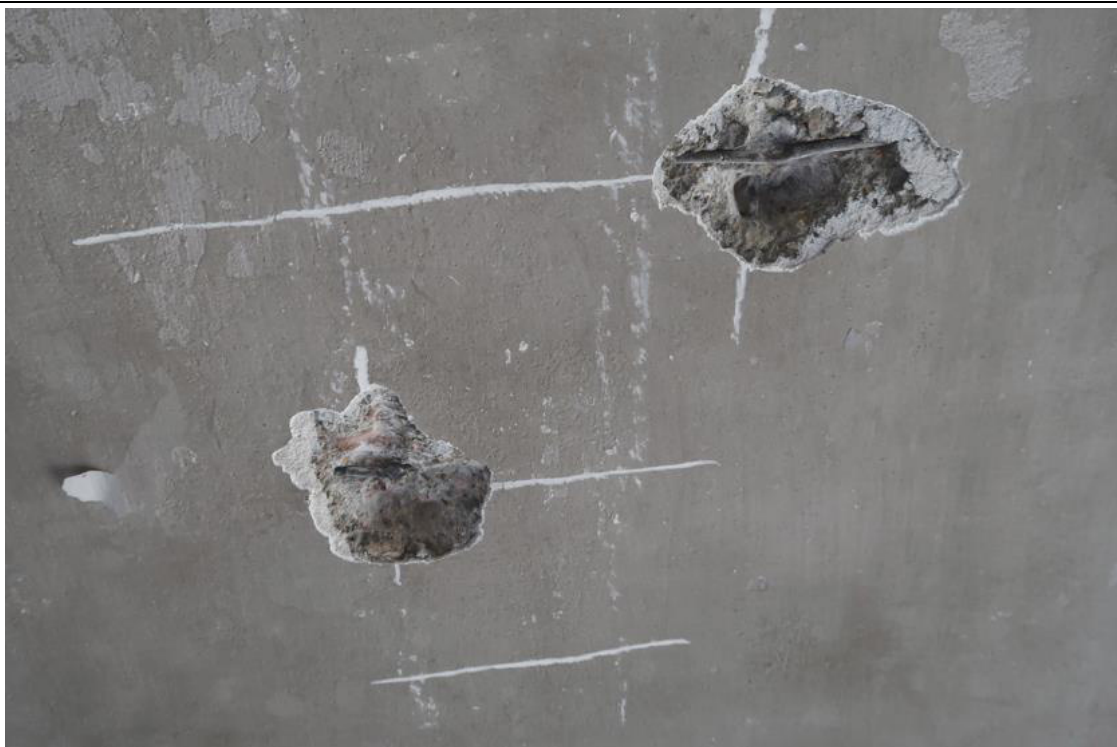
Fot. 63. Odkrywka O.29 stropu. W odkrywce stwierdzono płytę żelbetową gr. 5,0cm zbrojoną dołem prętami gładkimi \varnothing 6 w rozstawie co 15,0÷16,0cm. Kierunek zbrojenia głównego prostopadły do żeber stropowych. Zbrojenie rozdzielcze z prętów \varnothing 6 co 22,0÷27,0cm. Otulina zbrojenia wynosi 10mm. Beton jest niskiej jakości. Występuje karbonatyzacja betonu na gł. 2,0cm. Na płycie jest zlokalizowany stropodach wentylowany, z pustką powietrzną w miejscu odkrywki o wysokości ok.70,0cm.
