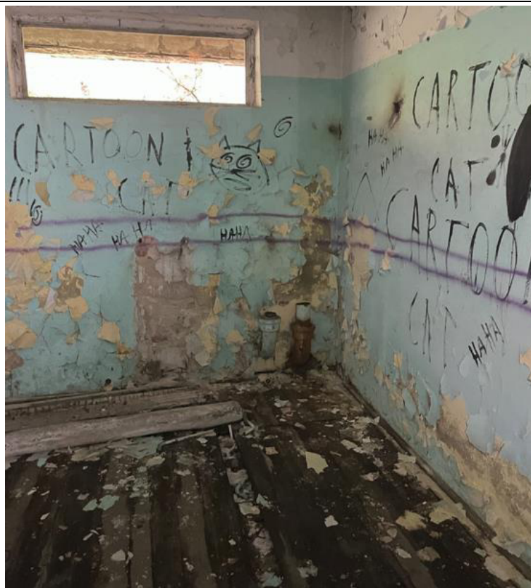
Fot. 44. Zawilgocenie oraz odparzona powłoka malarska i tynk na ścianie w osiach C'-E'/18-21 w piwnicy, część B budynku.
