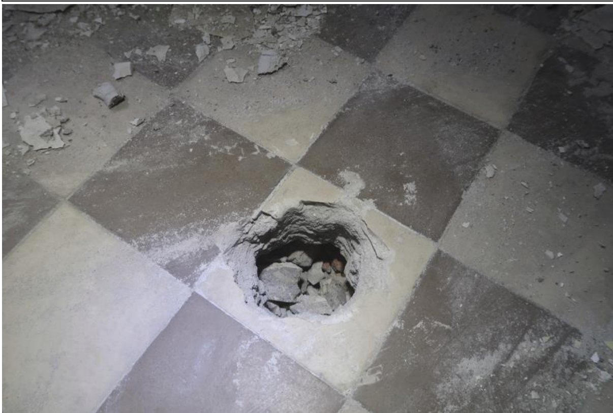
Fot. 142. Odkrywka O.69 posadzki. Stwierdzono płytki ceramiczne gr. 1,0cm, wylewkę cementową gr. 5cm i polepę gruzową gr. 24cm. Wierzch posadzki jest 30,0cm ponad wierzchem płyty stropu Kleina.
