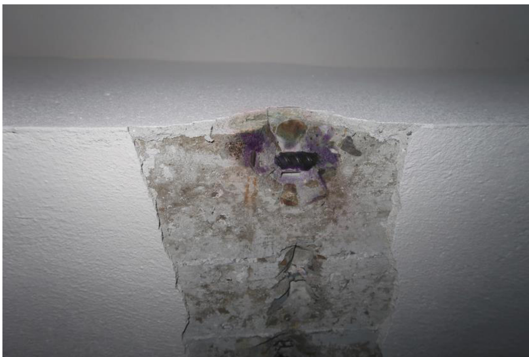
Fot. 82. Odkrywka O.60 podciagu. W odkrywce stwierdzono podciąg żelbetowy o przekroju 35,0x59,0cm (pomiar z tynkiem gr. 1,0cm, wraz z grubością stropu gęstożebrowego 24,0cm), zbrojony podłużnie dołem prętami żebrowanymi 3#18. Otulina zbrojenia wynosi 15/30mm.
