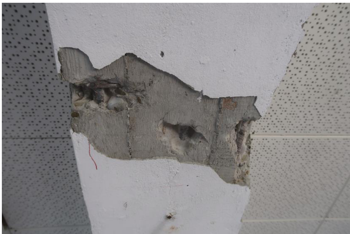
Fot. 66. Odkrywka O.39 podciągu. W odkrywce stwierdzono podciąg żelbetowy o przekroju 37,0x52,0cm (pomiar z tynkiem gr. 1,0cm, do spodu płyty stropowej), zbrojony podłużnie dołem prętami żebrowanymi 3#20. Strzemiona \varnothing 6 . Otulina zbrojenia wynosi 15÷20mm. Występuje karbonatyzacja betonu na gł. 3,0cm.
