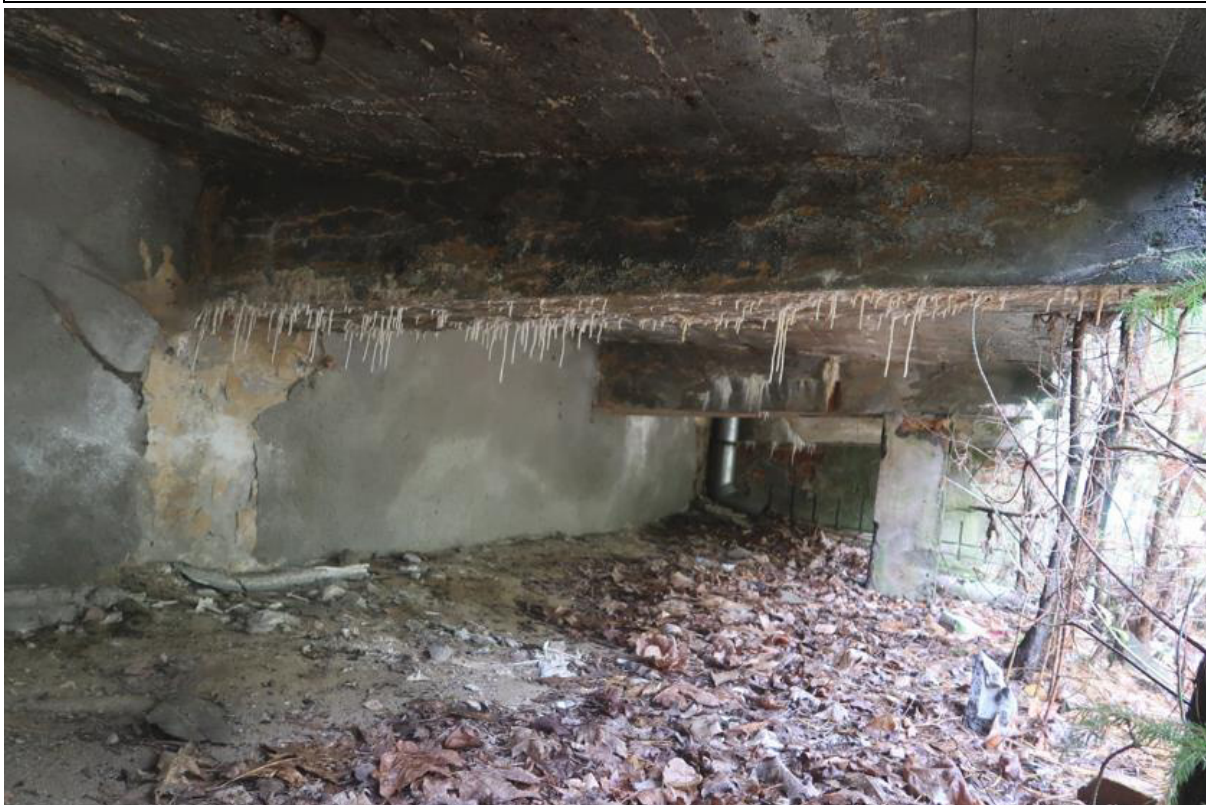
Fot. 93. Wysolenia na spodzie belki wspornikowej rampy na wschodniej elewacji w osiach E/2-5 części A budynku.
