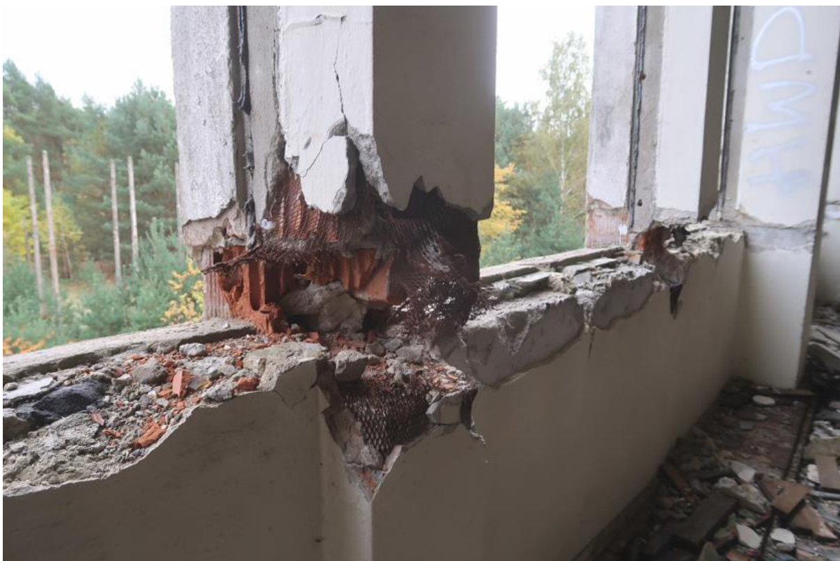
Fot. 51. Ubytki pustaków kratowych w filarkach międzyokiennych w pomieszczeniu w osiach F'/16-18 na I piętrze, część B budynku. Widoczny tynk wykonany na siatce stalowej cięto-ciągnionej.
