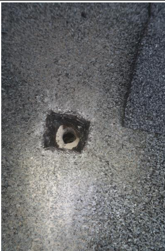
Fot. 166. Odkrywka O.80 stropodachu. Stwierdzono pokrycie z 3x papy, prefabrykowanej płytki żelbetowej gr. 4,5cm i izolacji termicznej z płyt suprema gr. ~10,0cm. Płytki ułożone są na ażurowych ścianach murowanych. W miejscu odkrywki pustka powietrzna ma wysokość ok. 115,0cm do stropu.
