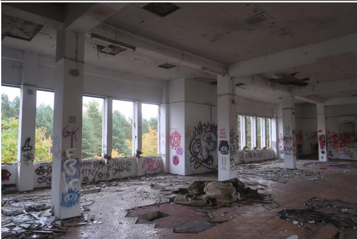
Fot. 121. Słupy o przekrojach prostokątnych występujące w osiach E'-F'/18-22 części B budynku na I piętrze.
