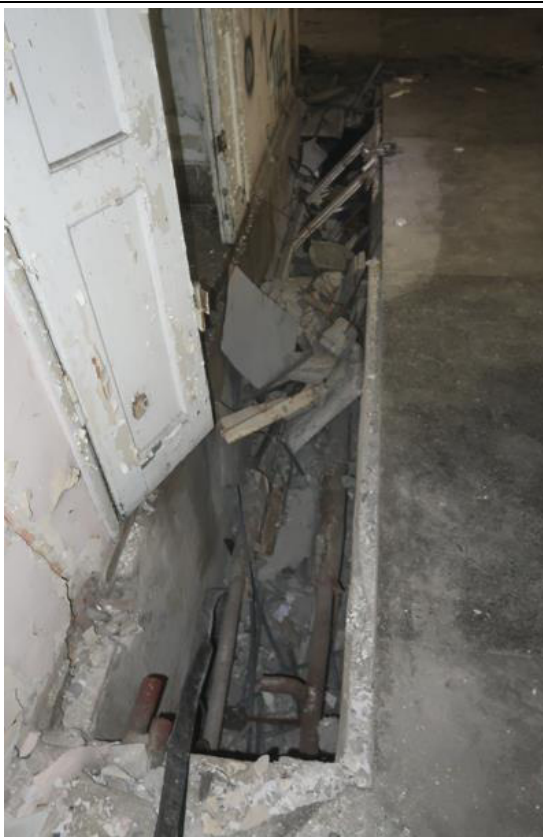
Fot. 148. Zagracony kanał instalacyjny w części komunikacyjnej w osiach D/3-4 na parterze (część A budynku).
