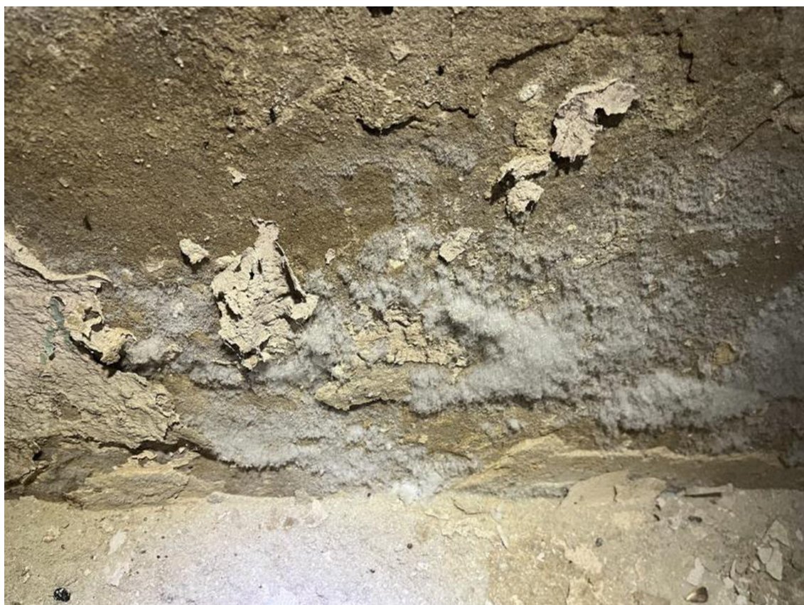
Fot. 47. Wysolenie na ścianach w pomieszczeniu w osiach C-D/1-2 w piwnicy, część A budynku.
