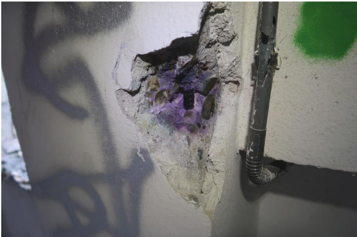
Fot. 119. Odkrywka O.58 słupa. W odkrywce stwierdzono słup żelbetowy o przekroju 35,0x40,0cm (pomiar z tynkiem gr. 1,0÷2,0cm), zbrojony podłużnie prętami żebrowanymi #14 (2 pręty na krótkim boku). Otulina zbrojenia wynosi 25÷30mm. Do słupa jest dostawiona zewnętrzna ściana murowana z bloczków z betonu komórkowego o gr. 15,0cm wraz z tynkiem.
