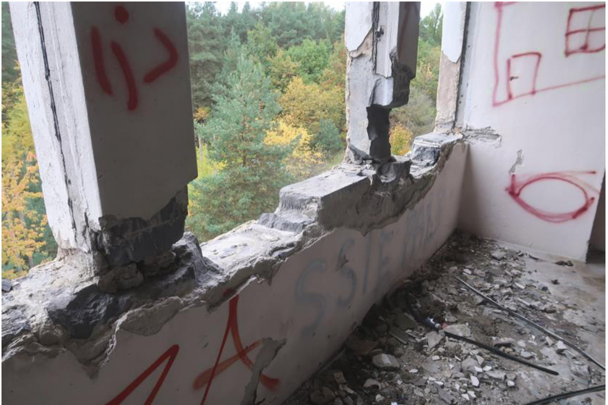
Fot. 52. Ubytki bloczków z betonu komórkowego w filarkach międzyokiennych w pomieszczeniu w osiach F'/20-21 na II piętrze, część B budynku.
