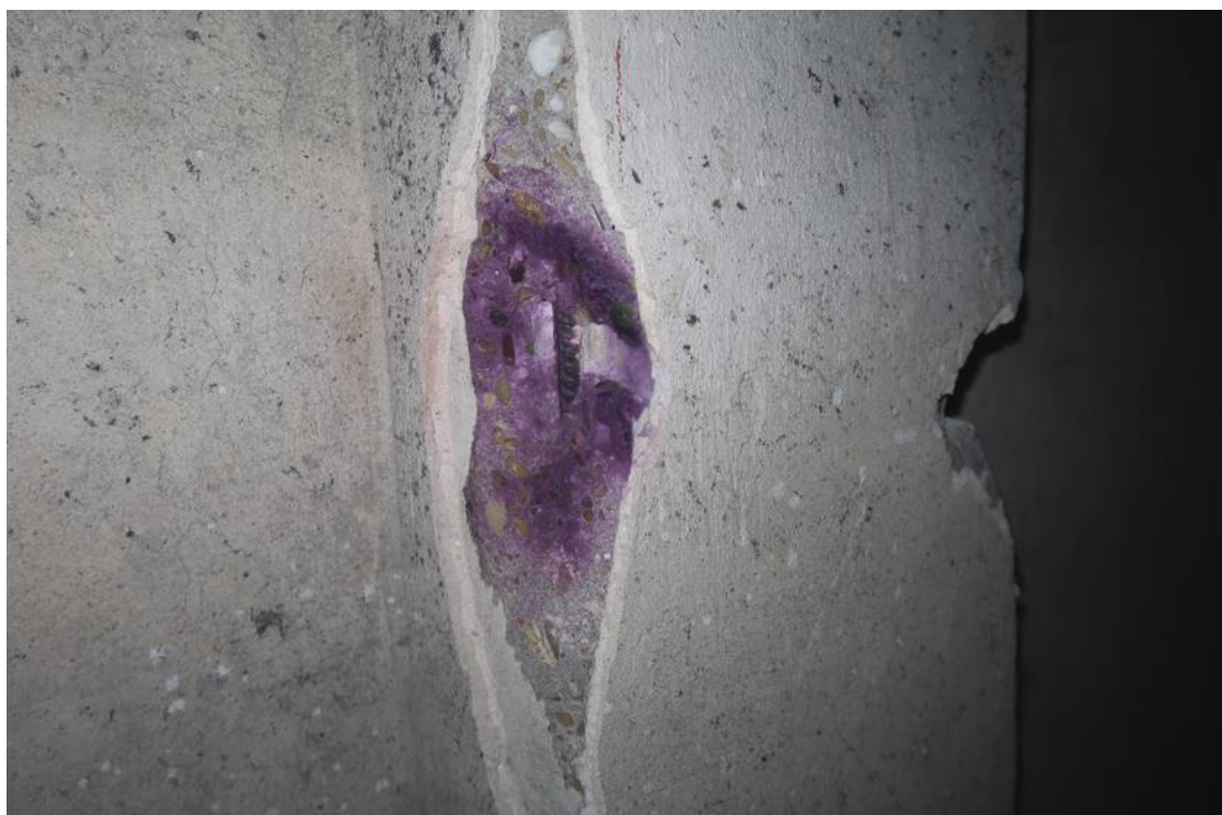
Fot. 112. Odkrywka O.21 słupa. W odkrywce stwierdzono słup żelbetowy o przekroju 38,0x55,0cm (pomiar z tynkiem gr. 1,0÷2,0cm), zbrojony podłużnie prętami żebrowanymi #14 (2 pręty na krótkim boku). Otulina zbrojenia wynosi 30mm. Do słupa z dwóch stron jest dostawiona ściana murowana z ceramicznej cegły pełnej gr. 1½ cegły (41,0cm).
