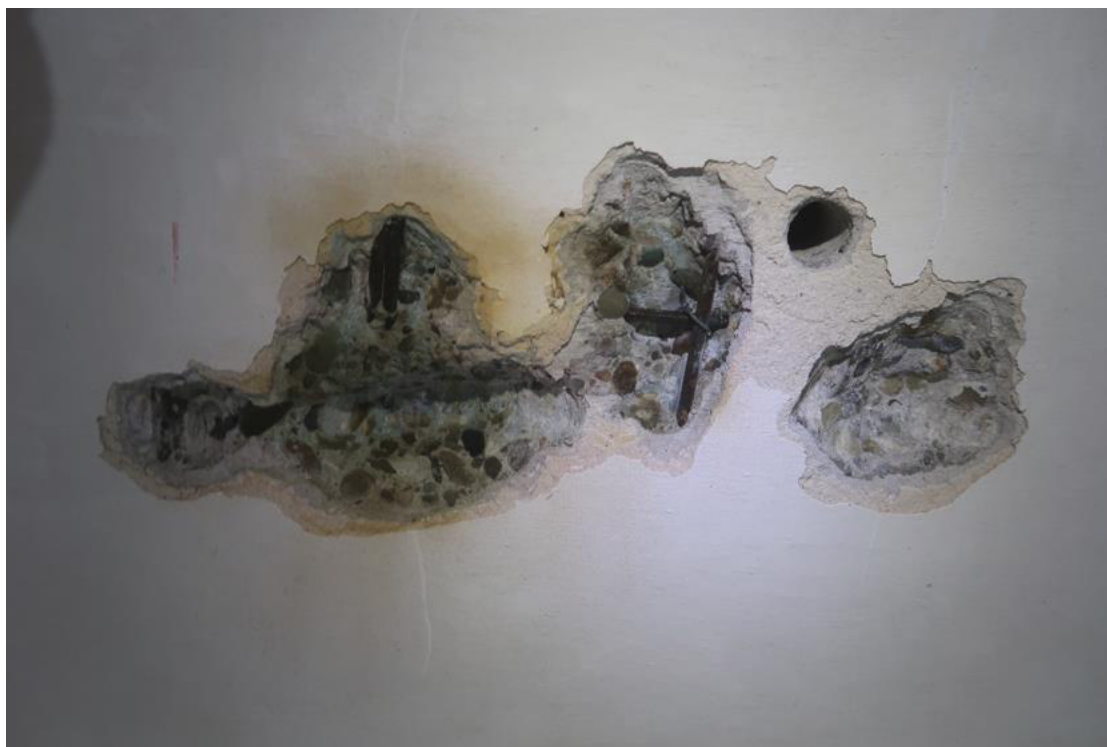
Fot. 74. Odkrywka O.50 stropu. W odkrywce stwierdzono płytę żelbetową gr.10,0cm zbrojoną dołem prętami gładkimi ø6 (co drugi podwójny odginany nad podporą) w rozstawie co 10,0cm. Kierunek zbrojenia głównego jest prostopadły do żeber stropowych. Zbrojenie rozdzielcze z prętów ø6 co 30,0cm. Otulina zbrojenia wynosi 5mm. Tynk c-w gr. 0,5cm. Występuje karbonatyzacja betonu.
