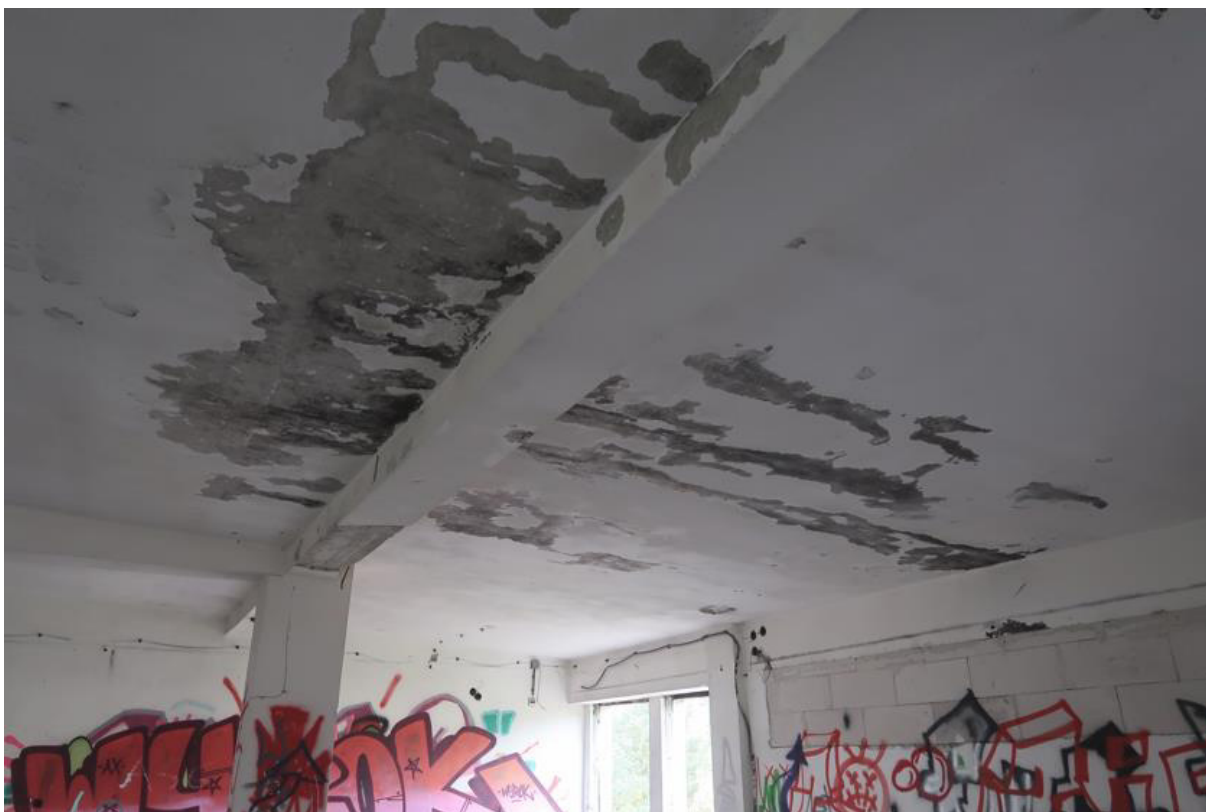
Fot. 102. Zaciek na suficie w pomieszczeniu w osiach A'-E'/18-19 na II piętrze (część B budynku). Widoczny odparzony tynk na suficie i belkach żelbetowych.
