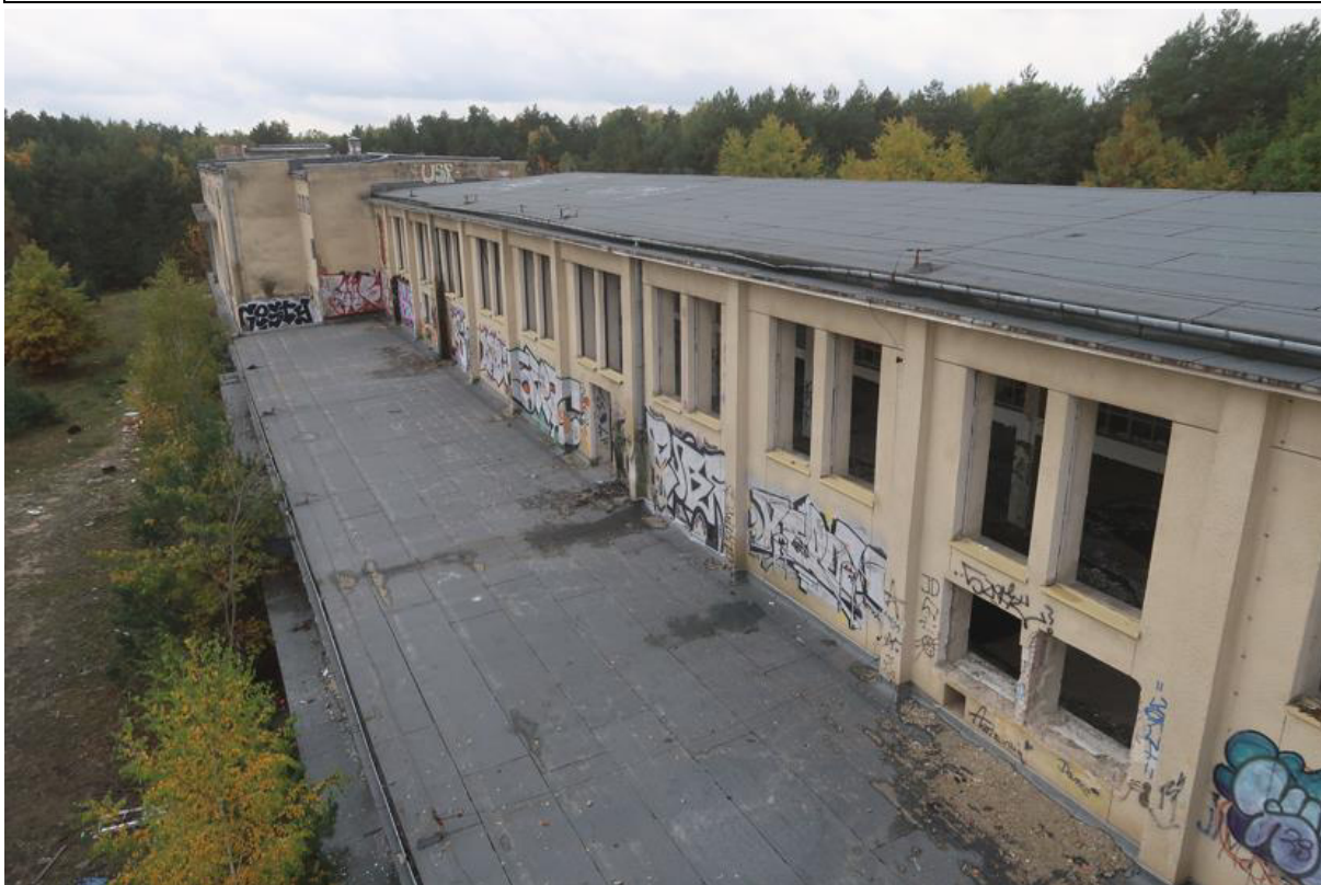
Fot. 168. Pokrycie stropodachu z papy części A przedmiotowego budynku.
