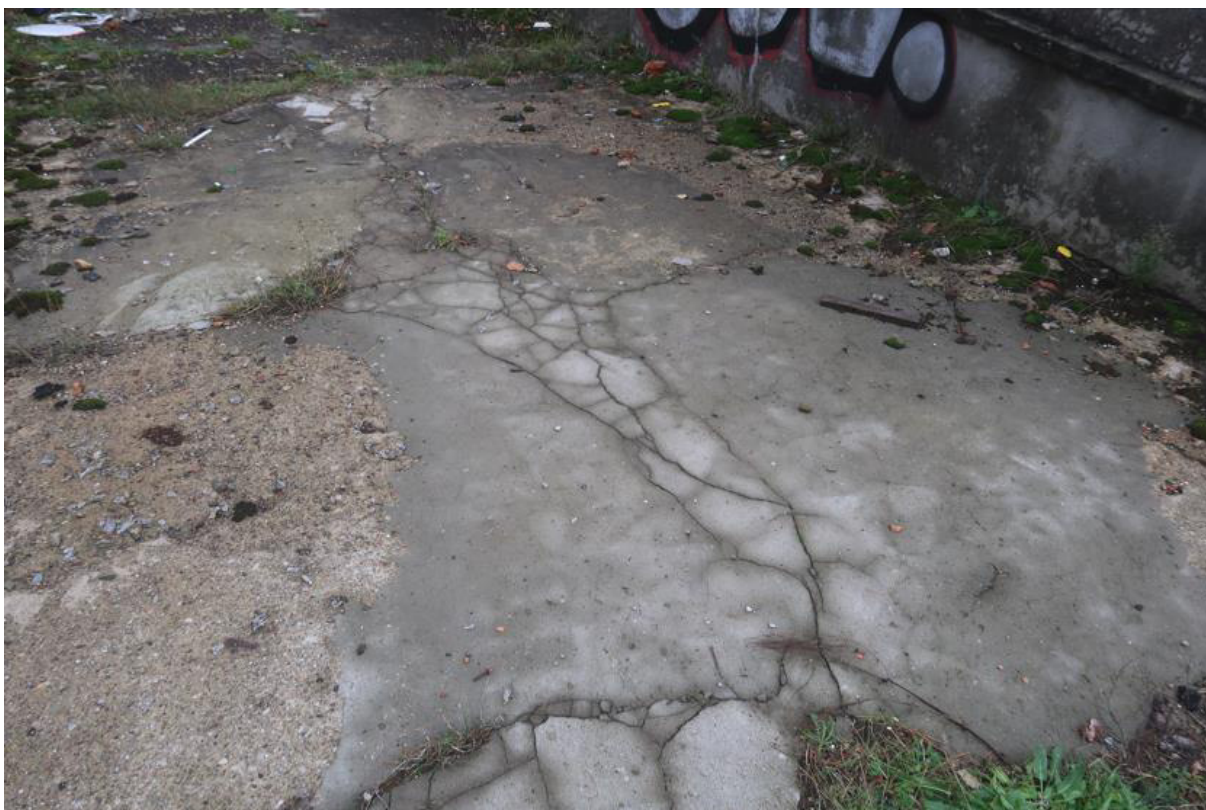
Fot. 143. Popękana posadzka betonowa na pochylni zlokalizowanej od strony południowej części B przedmiotowego budynku.
