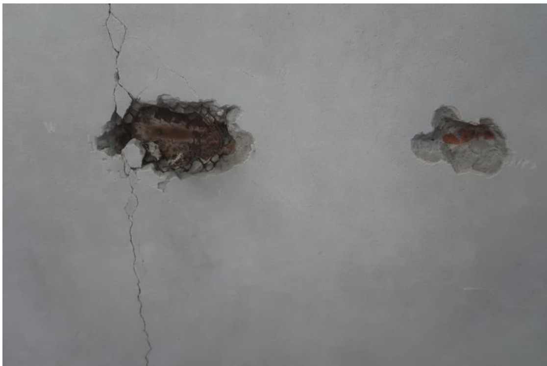
Fot. 84. Odkrywka O.68 stropu Kleina. Stwierdzono płyty ceglane ciężkie wykonane z ceramicznej cegły pełnej. Tynk c-w gr. 1,5cm. Płyty ceglane oparte na dolnych półkach belek stalowych wykonanych z dwuteowników IPN320, osiatkowanych i skorodowanych powierzchniowo. Belki w rozstawie co ok. 190cm.
