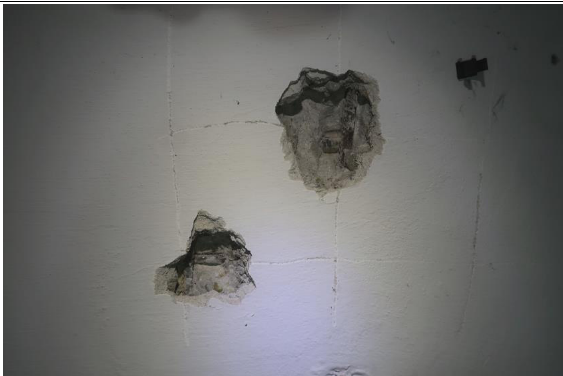
Fot. 77. Odkrywka O.53 stropu. W odkrywce stwierdzono płytę żelbetonową zbrojoną dołem prętami żebrowanymi #10 i #16 w rozstawie co 18,0÷20,0cm (naprzemiennie, kierunek zbrojenia prostopadły do elewacji) oraz w drugim kierunku prętami żebrowanymi #10 i #16 w rozstawie co 15,0÷16,0cm. (naprzemiennie). Otulina zbrojenia wynosi 20mm. Tynk c-w gr. 1,0cm. Występuje karbonatyzacja betonu w warstwie otuliny zbrojenia.
