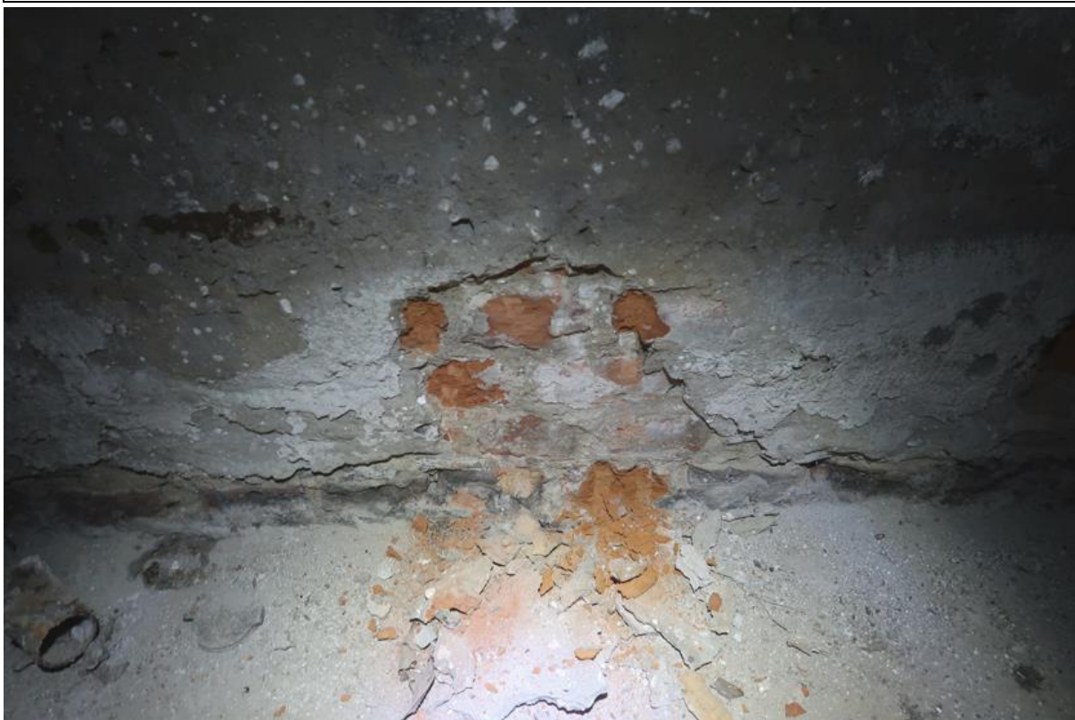
Fot. 30. Odkrywka O.76 ściany zewnętrznej. Stwierdzono konstrukcję ściany z cegły ceramicznej pełnej murowanej na zaprawie cementowo-wapiennej. Tynk c-w gr. 2,0cm.
