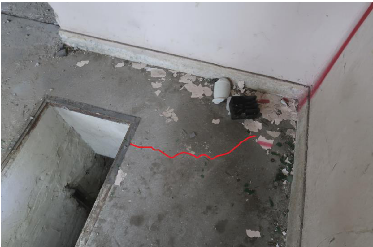
Fot. 147. Zarysowanie na posadzce betonowej w pomieszczeniu w osiach A'-C'/16-18 na parterze (część B budynku), obok kanału instalacyjnego
