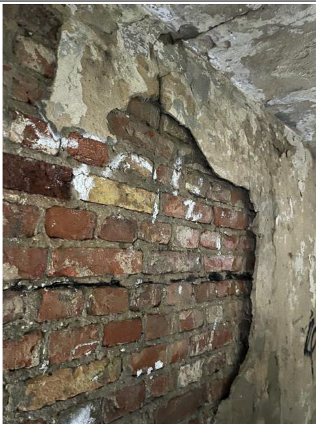
Fot. 46. Zawilgocony i odparzony tynk na ścianie w osiach A'-E'/22-23 w piwnicy. Widoczna pozioma izolacja przeciwwilgociowa, część B budynku.
