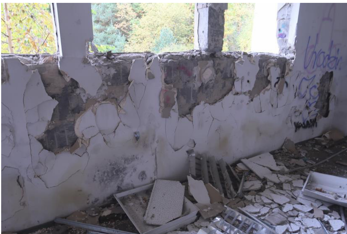
Fot. 49. Odparzony tynk na ścianie podokiennej w pomieszczeniu w osiach A'/15-16 na parterze. Powyżej w filarkach międzyokiennej stwierdzono ubytki bloczków z betonu komórkowego, część B budynku.
