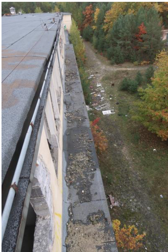
Fot. 173. Zalegający odpierzony tynk na daszku w elewacji w osiach F'/17-22 (część B budynku).
