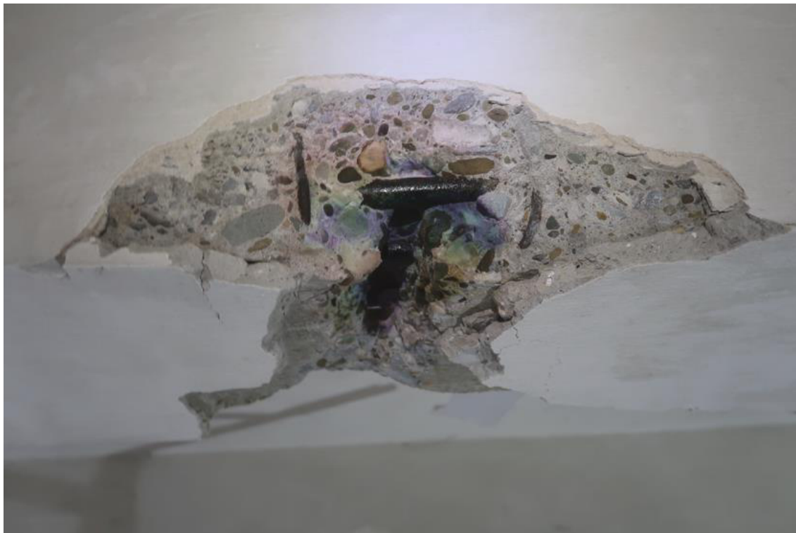
Fot. 73. Odkrywka O.49 żebra. W odkrywce stwierdzono żebro żelbetowe o przekroju 27,0x41,0cm (pomiar z tynkiem gr. 1,0÷2,0cm, do spodu płyty stropowej), zbrojone podłużnie dołem prętami gładkimi 4ø22. Strzemiona ø8. Otulina zbrojenia wynosi 45mm. Występuje karbonatyzacja betonu w warstwie otuliny zbrojenia.
