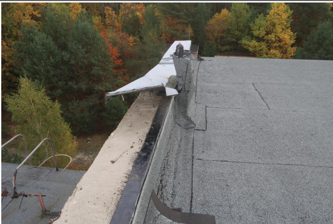
Fot. 182. Ubytki obróbki blacharskich na attyce dachu w osi 15 (część B budynku).
