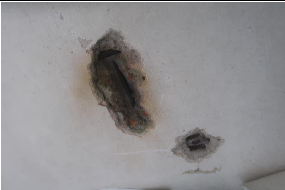
Fot. 85. Odkrywka O.73 stropu. W odkrywce stwierdzono płytę gruzobetonową gr. 8cm zbrojoną dołem prętami gładkimi \varnothing 10 w rozstawie co 10,0 \div 15,0 cm (kierunek zbrojenia prostopadły do belek stropowych) oraz prętami rozdzielczymi \varnothing 6 . Otulina zbrojenia wynosi 10mm. Tynk c-w gr. 2,0cm. Występuje karbonatyzacja betonu w warstwie otuliny zbrojenia.
