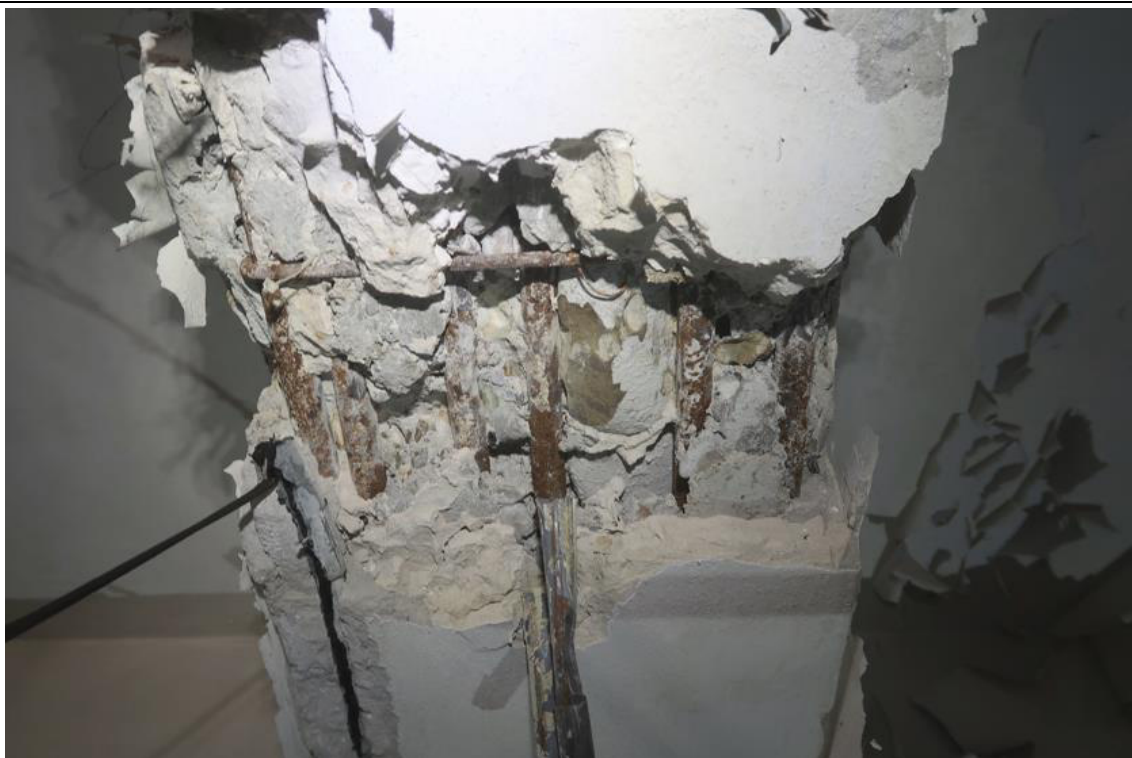
Fot. 69. Odkrywka O.45 podciagu. W odkrywce stwierdzono podciąg żelbetonowy o przekroju 38,0x65,0cm (pomiar z tynkiem gr. 1,0÷3,0cm, do spodu płyty stropowej), zbrojony podłużnie dołem prętami gładkimi 6Ø22. Otulina zbrojenia wynosi 10mm. Beton jest niskiej jakości, słabo zagęszczony (kawerny wypełnione tynkiem) Występuje karbonatyzacja betonu.
