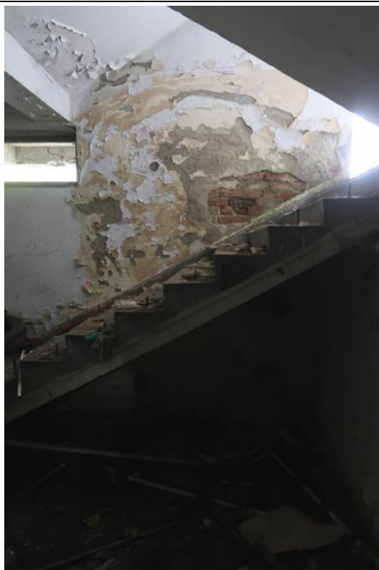
Fot. 42. Zawilgocenie oraz odparzona powłoka malarska i tynk na ścianie przy schodach w osiach B'/14-15 w piwnicy, część B budynku.
