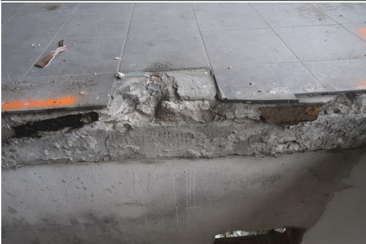
Fot. 138. Odkrywka O.61 posadzki. Stwierdzono płytki gresowe gr.1,0cm, wylewkę cementową gr. 8,0cm leżącą na stropie (płyta żelbetowa gr. 15,0cm).
