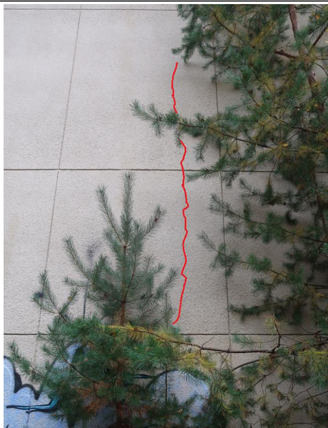
Fot. 32. Zarysowanie pionowe na zachodniej elewacji w osiach A/1-2 części A budynku.
