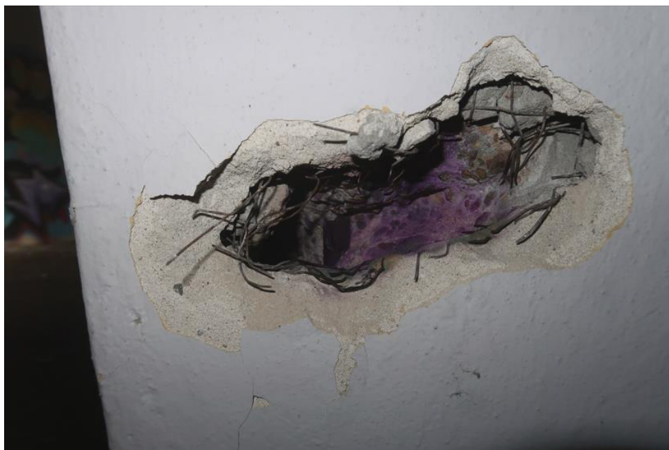
Fot. 104. Odkrywka O.1 słupa. W odkrywce stwierdzono słup żelbetowy o przekroju 40,0x86,0cm (pomiar z tynkiem gr. 1,0÷3,0cm), zbrojony podłużnie prętami gładkimi \varnothing 18 (4 pręty na krótkim boku), strzemiona \varnothing 8 . Otulina zbrojenia wynosi 50/10mm. Beton jest słabo zagęszczony (z kawernami), a pod tynkiem występuje siatka stalowa cięto-ciagniona. Występuje karbonatyzacja betonu w warstwie otuliny zbrojenia.
