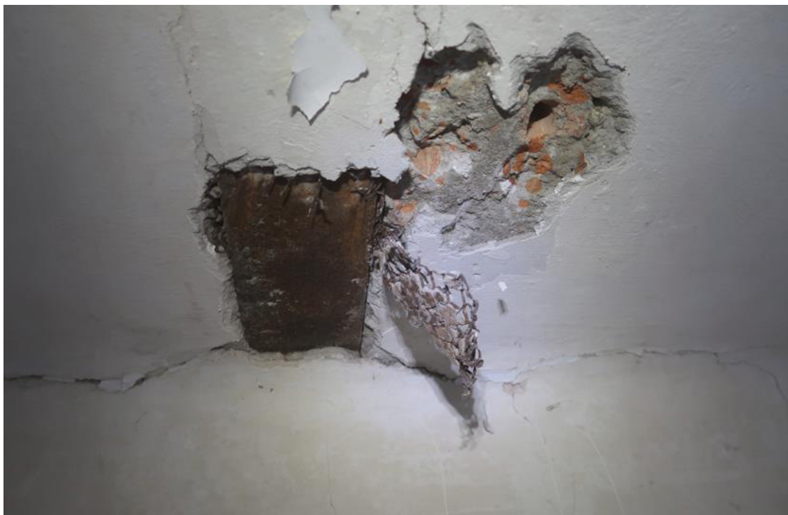
Fot. 72. Odkrywka O.48 stropu Kleina. Stwierdzono płyty z gruzobetonu gr. 8,0÷10,0cm. Tynk c-w gr. 0,5cm na siatce stalowej. Płyty oparte na dolnych półkach belek stalowych wykonanych z dwuteowników IPN320, skorodowanych powierzchniowo. Belki w rozstawie co ok. 190cm.
