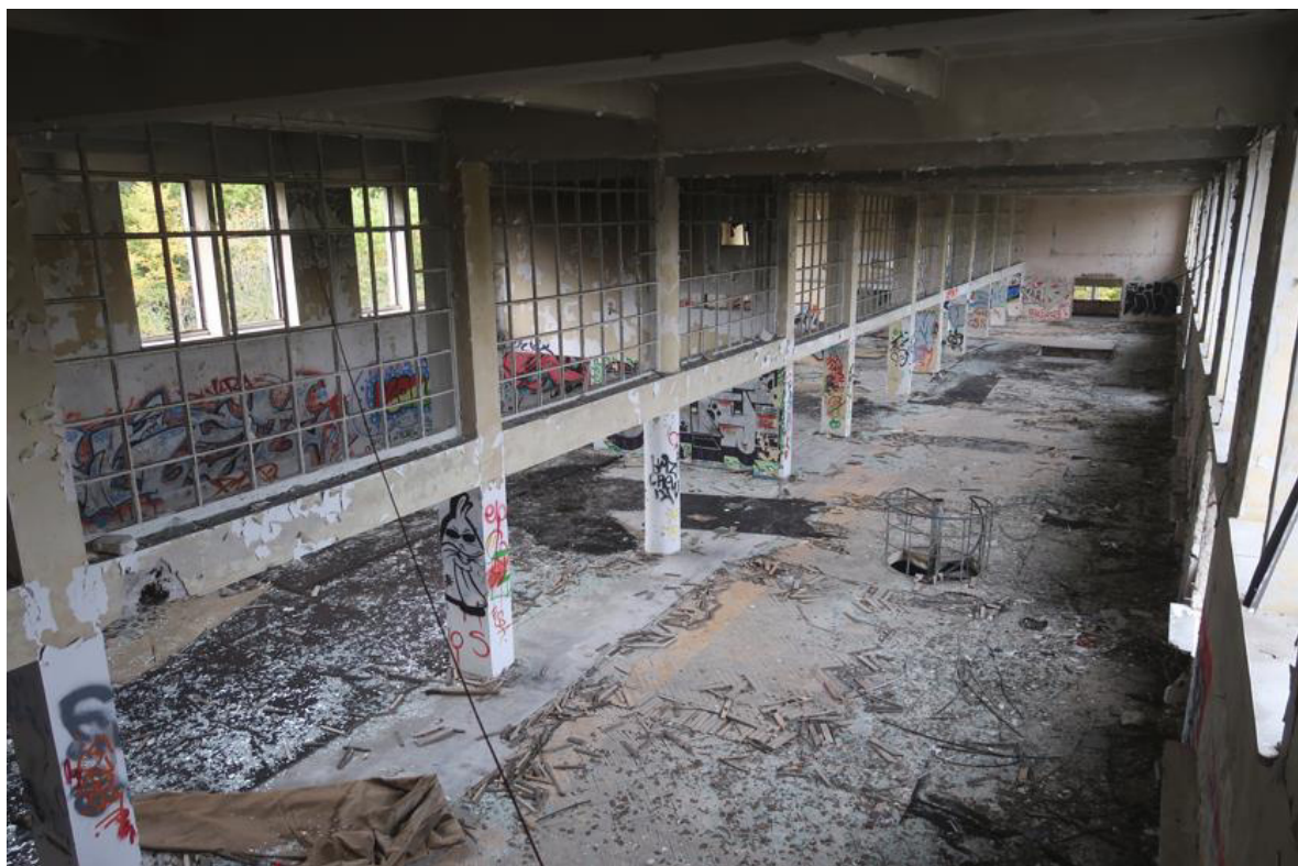
Fot. 120. Rząd słupów środkowych o zróżnicowanej geometrii występujący w osi C części A budynku, w poziomie I piętra.
