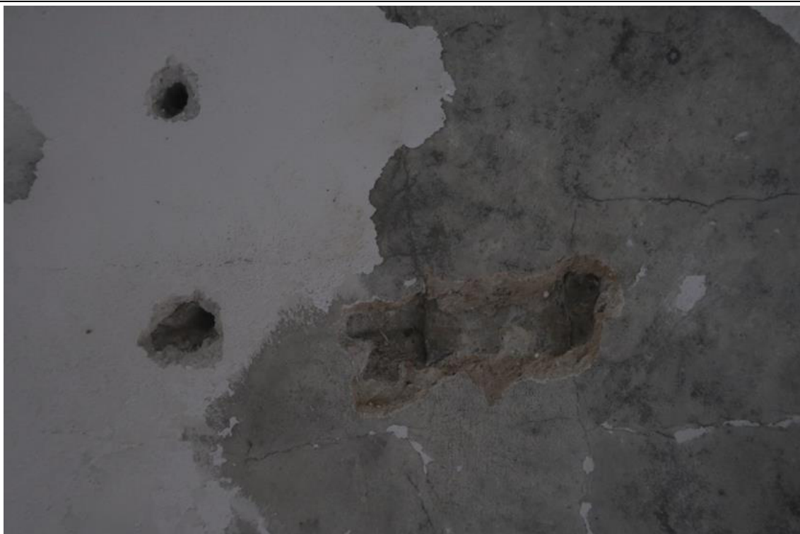
Fot. 81. Odkrywka O.59 stropu gęstożebrowego. Stwierdzono strop gęstożebrowy typu Teriva, z prefabrykowanymi belkami nośnymi szer. 12cm w rozstawie co 60cm. Wysokość pustaka 18cm, a całkowitą gr. stropu oszacowano na 24cm. Tynk c-w gr. 1,5cm.
