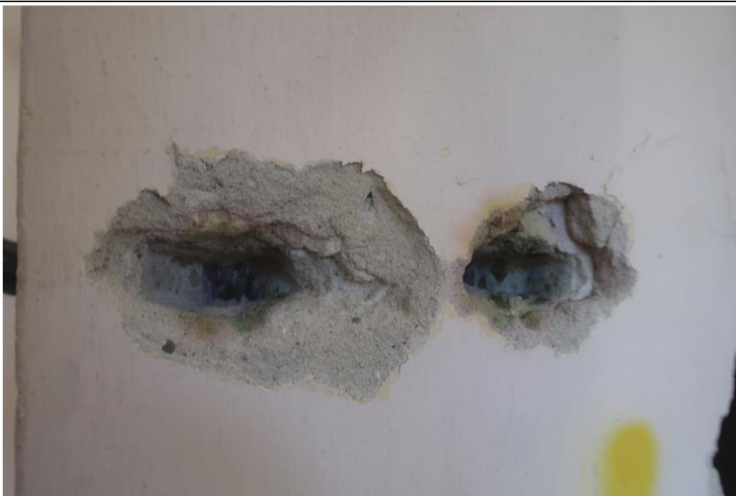
Fot. 107. Odkrywka O.12 słupa. W odkrywce stwierdzono słup żelbetowy o przekroju 39,0x46,0cm (pomiar z tynkiem gr. 1,0÷2,0cm), zbrojony podłużnie prętami żebrowanymi #20 (3 pręty na krótkim boku). Strzemiona \varnothing 6 . Otulina zbrojenia wynosi 20mm. Występuje karbonatyzacja betonu w warstwie otuliny zbrojenia. Do słupa jest dostawiona ściana działowa murowana z ceramicznej cegły pełnej o gr. 15,0cm wraz z tynkiem.
