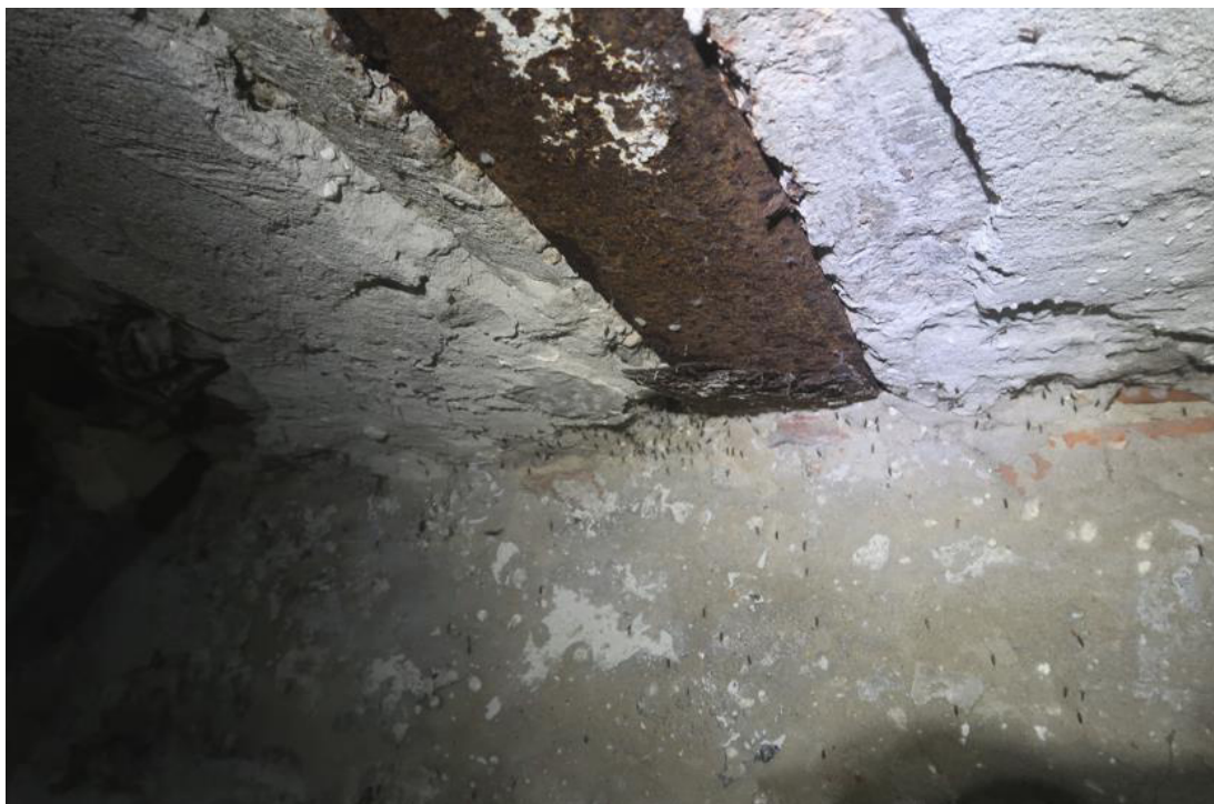
Fot. 86. Odkrywka O.74 stropu Kleina. Stwierdzono płyty gruzobetonowe gr. 8,0cm. Tynk c-w gr. 1,5cm. Płyty oparte na dolnych półkach belek stalowych wykonanych z dwuteowników IPN280, skorodowanych płatowo. Belki w rozstawie co ok. 103cm. W odkrywce stwierdzono zbrojenie płyty dołem prętami gładkimi \varnothing 6 w rozstawie co 10,0 \div 12,0 cm (kierunek zbrojenia prostopadły do belek stropowych). Otulina zbrojenia wynosi 5 \div 10 mm.
