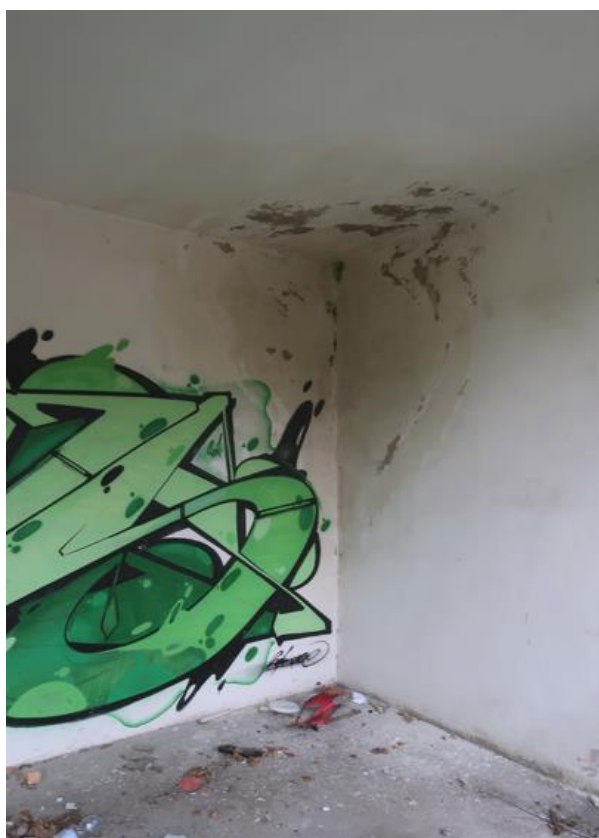
Fot. 100. Zacieki na suficie i na ścianach w pomieszczeniu w osiach E'-F'/14-15 na parterze (część B budynku).
