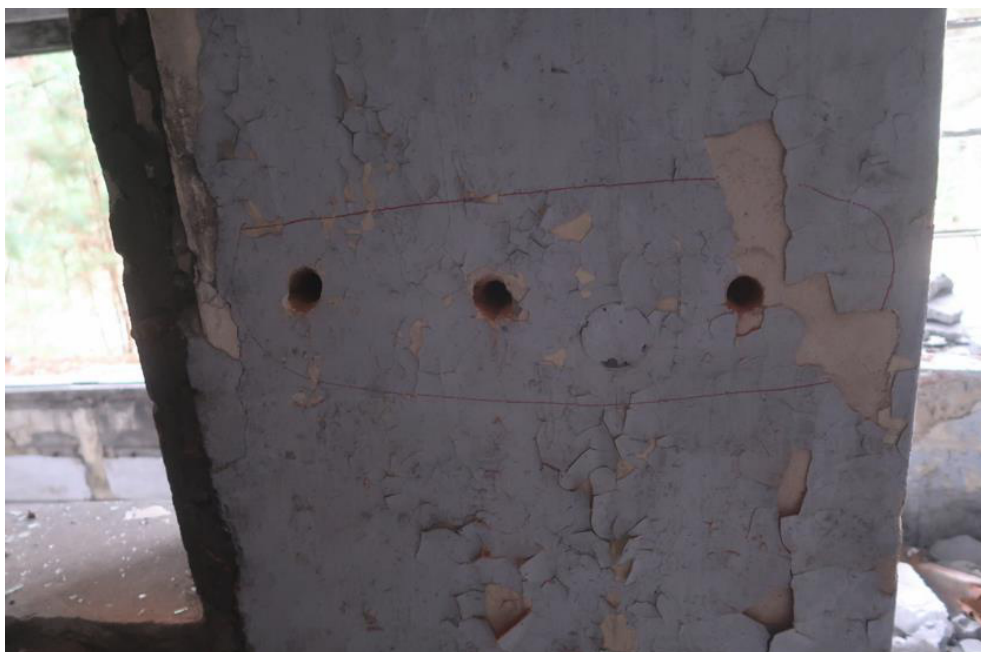
Fot. 21. Odkrywka O.4 ściany wewnętrznej. Stwierdzono konstrukcję ściany z cegły ceramicznej pełnej murowanej na zaprawie cementowo-wapiennej. Tynk c-w gr. 2,0cm.
