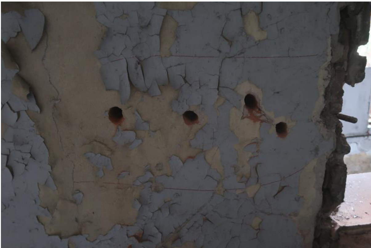
Fot. 22. Odkrywka O.5 ściany wewnętrznej. Stwierdzono konstrukcję ściany z cegły ceramicznej pełnej murowanej na zaprawie cementowo-wapiennej. Tynk c-w gr. 2,0cm.
