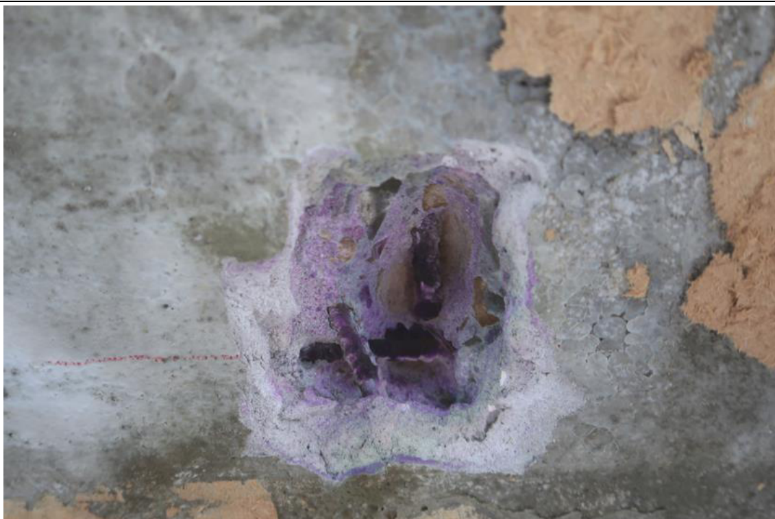
Fot. 67. Odkrywka O.40 stropu. W odkrywce stwierdzono płytę żelbetonową zbrojoną dołem prętami żebrowanymi #14 w rozstawie co 25,0÷30,0cm (kierunek zbrojenia prostopadły do elewacji) oraz w drugim kierunku prętami żebrowanymi #10 w rozstawie co 25,0÷30,0cm. Otulina zbrojenia wynosi 30mm. Występuje karbonatyzacja betonu na gł. 2,0cm.
