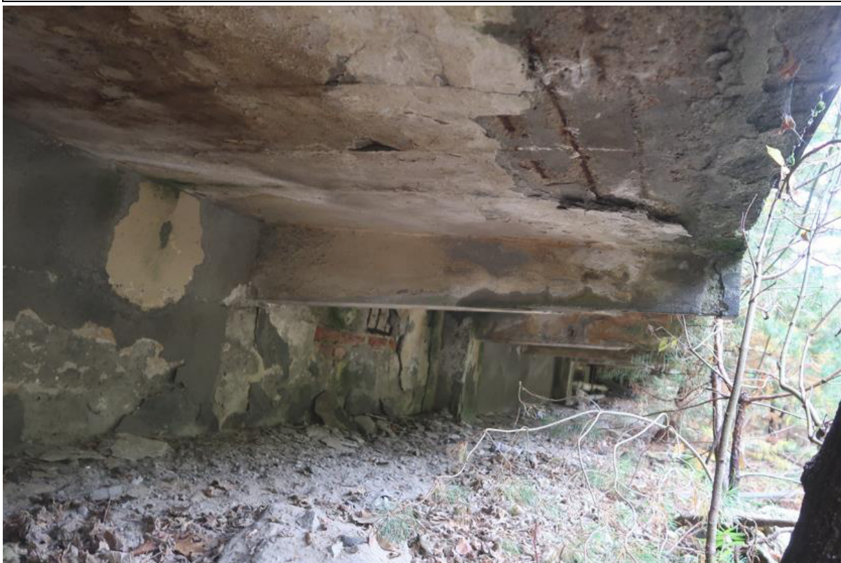
Fot. 89. Odparzony tynk i otulina zbrojenia oraz skorodowane zbrojenie na spodzie rampy na zachodniej elewacji w osiach B/2-5 części A budynku.
