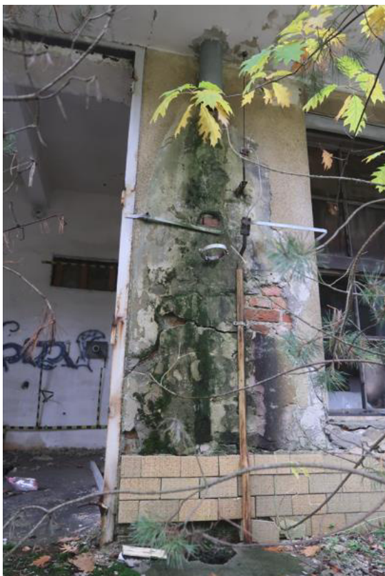
Fot. 179. Zdemontowana rura spustowa na wschodniej elewacji w osiach 2-4 (część A budynku). Na elewacji widoczne zagłobienie, odparzenie tynku i erozja płytek cokołu.
