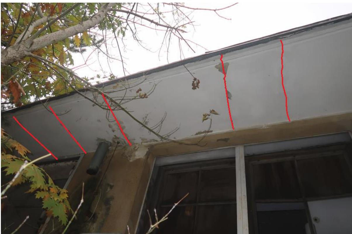
Fot. 92. Zarysowania na spodzie daszka nad rampą na wschodniej elewacji w osiach E/6-8 części A budynku.
