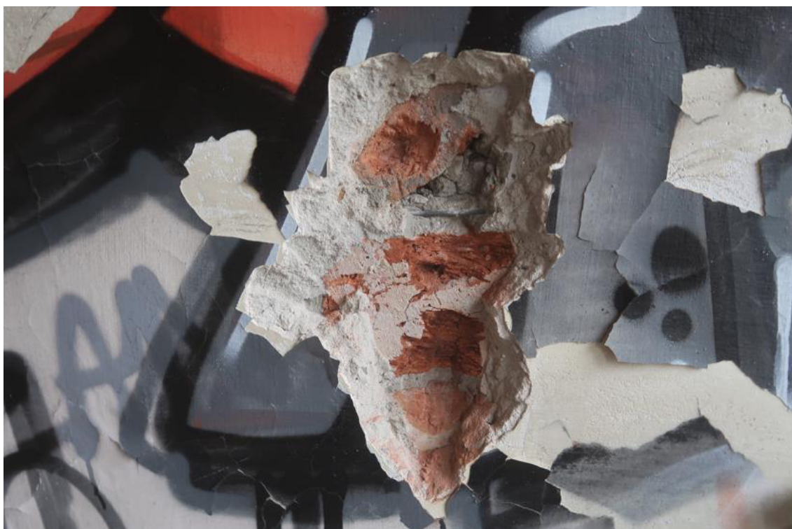
Fot. 27. Odkrywka O.65 ściany działowej. Stwierdzono konstrukcję ściany gr. 10cm z cegły ceramicznej pełnej murowanej na zaprawie cementowo-wapiennej. Tynk c-w gr. 2,5cm. W spoinach stwierdzono zbrojenie prętami gładkimi \varnothing 4 .
