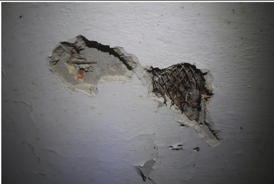
Fot. 87. Odkrywka O.77 stropu Kleina. Stwierdzono płyty gruzobetonowe. Tynk c-w gr. 1,5cm. Płyty oparte na dolnych półkach belek stalowych wykonanych z dwuteowników IPN280 osiatkowanych i skorodowanych powierzchniowo. Belki w rozstawie co ok. 125cm. W odkrywce stwierdzono zbrojenie płyty dołem prętami gładkimi \varnothing 8 w rozstawie co 10,0cm (kierunek zbrojenia prostopadły do belek stropowych). Otulina zbrojenia wynosi 5mm.
