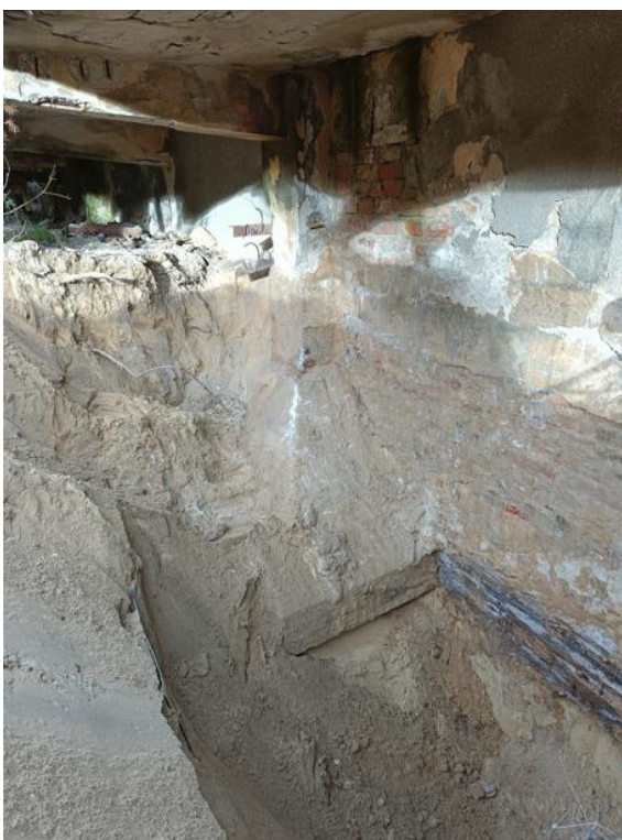
Fot. 18. Odkrywka F.4. fundamentów. W wykonanej odkrywce stwierdzono trapezową żelbetową stopę fundamentową słupa o wymiarach w rzucie 200,0x260,0cm i wysokości 110,0cm. Obok pod ścianą elewacyjną budynku stwierdzono betonową ławę fundamentową gr. 30,0cm bez odsadzek. Ściana fundamentowa murowana z ceramicznej cegły pełnej. Ława i stopa są posadowione około 185,0cm p.p.t. Nie stwierdzono pionowej izolacji p.wilgociowej ściany fundamentowej.
