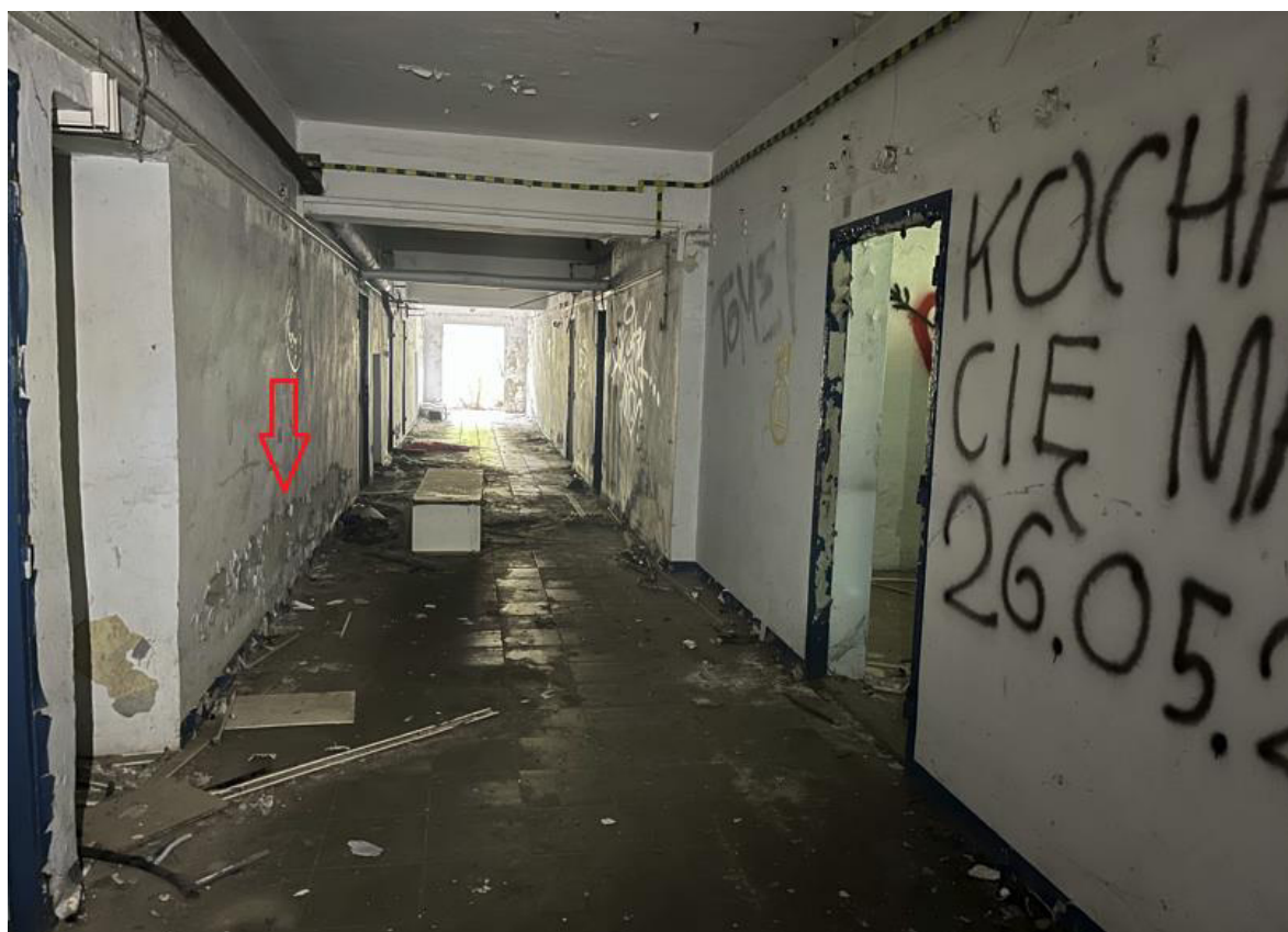
Fot. 43. Zawilgocenie oraz odparzona powłoka malarska i tynk na ścianie w osiach C'-E'/18-21 w piwnicy, część B budynku.
