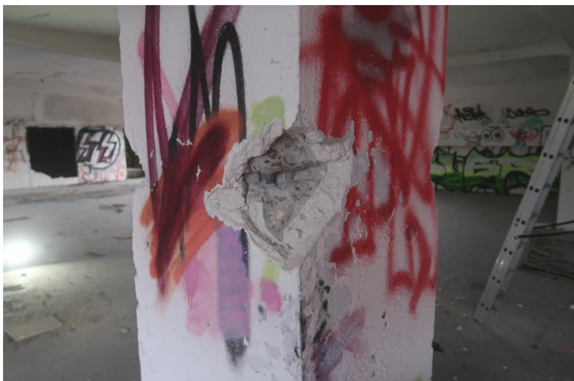
Fot. 118. Odkrywka O.57 słupa. W odkrywce stwierdzono słup żelbetowy o przekroju 44,0x51,0cm (pomiar z tynkiem gr. 1,0÷5,0cm, żelbet 35,0x45,0), zbrojony podłużnie prętami żebrowanymi #18 (2 pręty na krótkim boku). Otulina zbrojenia wynosi 25/50mm. Występuje karbonatyzacja betonu na gł. 1,0cm.
