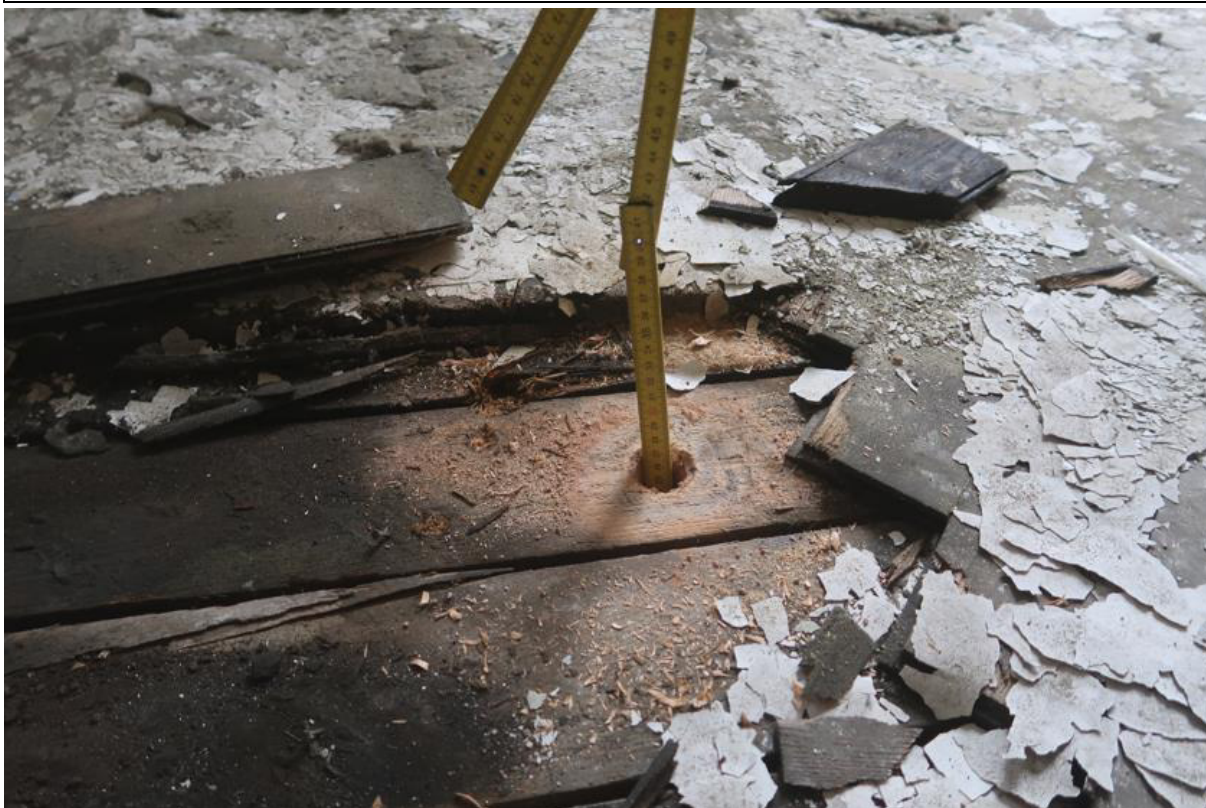
Fot. 126. Odkrywka O.8 posadzki. Stwierdzono parkiet gr.2,0cm, deski gr. 3,0cm leżące na legarach i pospółce gruzowej o gr. 15,0cm oraz polepie. Wierzch posadzki jest ok. 29,0cm ponad wierzchem płyty ceglanej stropu Kleina.
