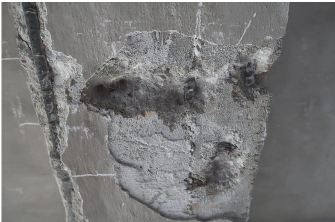
Fot. 62. Odkrywka O.28 podciagu. W odkrywce stwierdzono podciąg żelbetowy o przekroju 40,0x57,0cm (pomiar z tynkiem gr. 1,0cm, do spodu płyty stropowej), zbrojony dołem prętami grzebieniowymi 4#18x18 (nr 26 wg [21]). Strzemiona \varnothing 8 . Otulina zbrojenia wynosi 20mm. Beton jest niskiej jakości, słabo zagęszczony (z kawernami). Występuje karbonatyzacja betonu.
