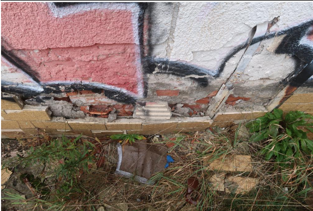
Fot. 34. Odparzone płytki cokołu na południowej elewacji w osiach B/13 części A budynku.
