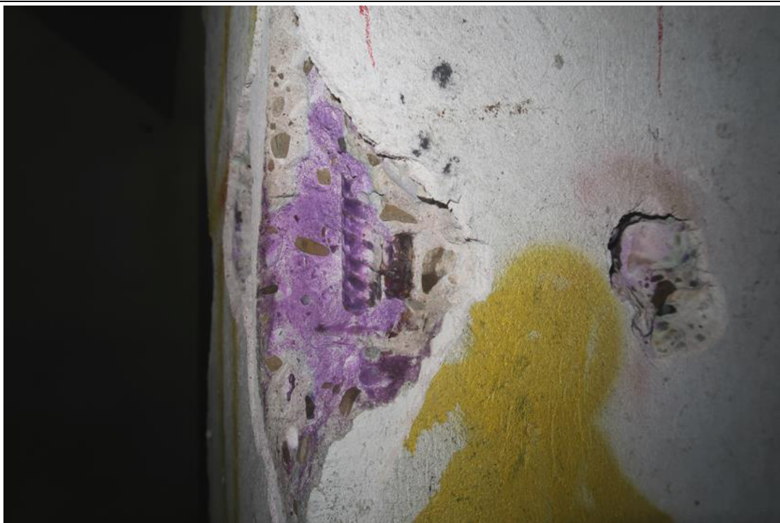
Fot. 111. Odkrywka O.19 słupa. W odkrywce stwierdzono słup żelbetowy o przekroju 37,0x47,0cm (pomiar z tynkiem gr. 1,0÷2,0cm), zbrojony podłużnie prętami żebrowanymi #20 (5 prętów na krótkim boku, 1 pręt na długim). W narożnikach pręty zbrojeniowe są podwójone. Otulina zbrojenia wynosi 20÷30mm. Występuje karbonatyzacja betonu w warstwie otuliny zbrojenia.
