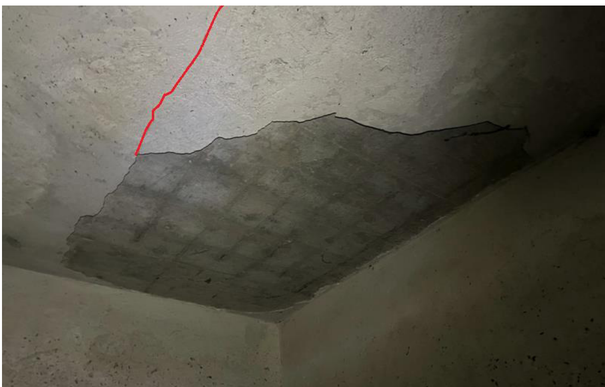
Fot. 96. Zarysowanie i odparzony tynk na suficie w narożu ścian w osiach B'/15 w piwnicy (część B budynku).
