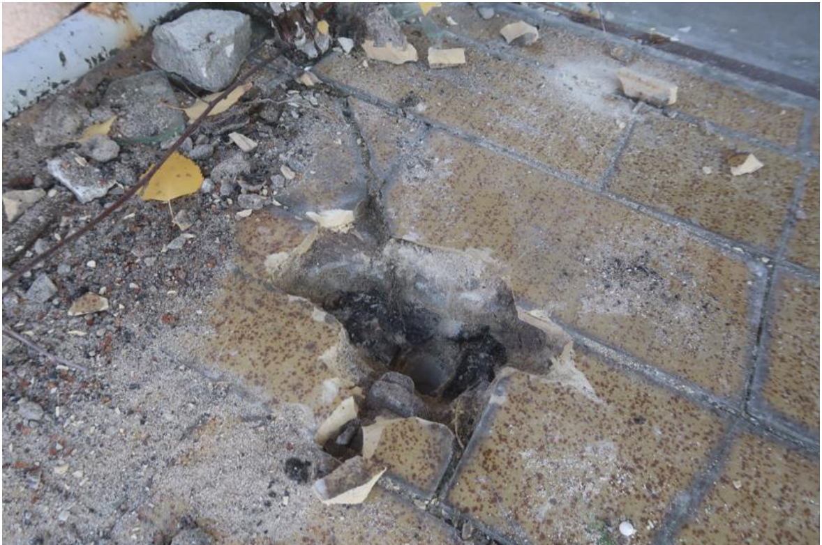
Fot. 160. Odkrywka O.37 posadzki balkonu. Stwierdzono płytki ceramiczne gr. 1,0cm, wylewkę cementową gr. 4,0cm, papę i płytę żelbetową gr. 13,0÷14,0cm. Płyta oparta jest na wspornikowych belkach stalowych.
