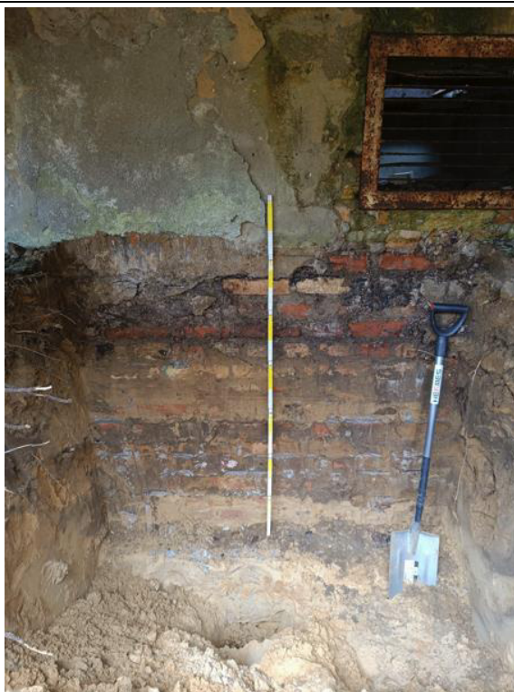
Fot. 15. Odkrywka F.1. fundamentów. W wykonanej odkrywce stwierdzono ławę fundamentową betonową gr. 45,0cm z odsadzką 15,0cm. Ściana fundamentowa murowana z ceramicznej cegły pełnej, z poziomą izolacją p.wilgociową z papy. Ława jest posadowiona około 165,0cm p.p.t. Nie stwierdzono pionowej izolacji p.wilgociowej ściany fundamentowej.
