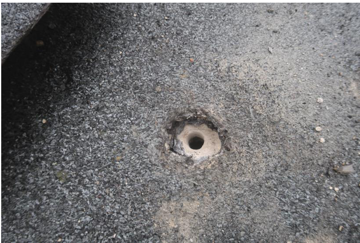
Fot. 165. Odkrywka O.79 stropodachu. Stwierdzono pokrycie z 2x papy, prefabrykowanej płytki żelbetowej gr. 4,5cm i izolacji termicznej z płyt suprema gr. ~5,0cm. Płytki ułożone są na ażurowych ścianach murowanych. W miejscu odkrywki pustka powietrzna ma wysokość ok.50,0cm do stropu.
