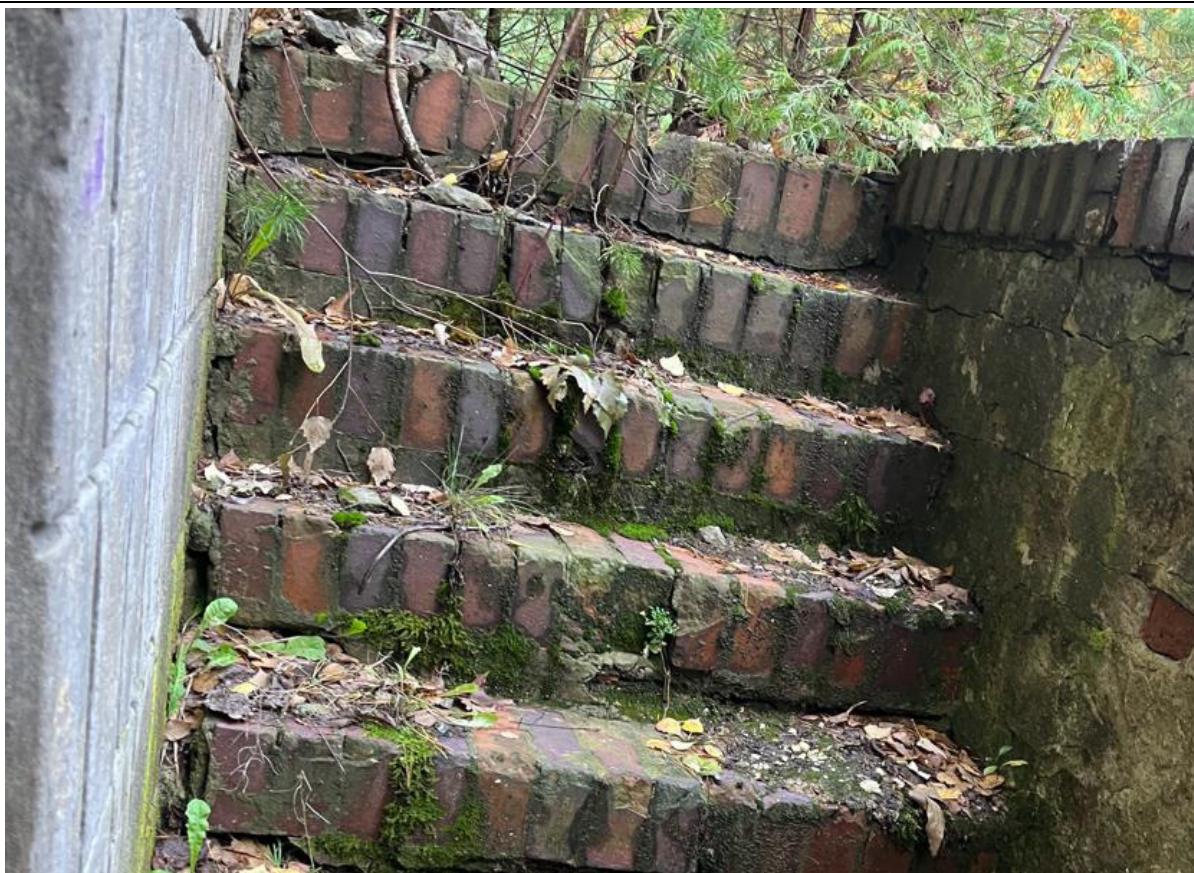
Fot. 155. Zagłonięcie i zużycie schodów ceglanych w osiach F/1-2 (część A budynku).
