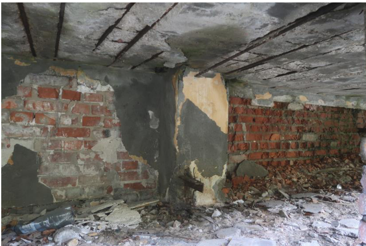
Fot. 90. Odparzony tynk i otulina zbrojenia oraz skorodowane zbrojenie na spodzie rampy na zachodniej elewacji w osiach B/9-11 części A budynku. Widoczna korozja cegły w ścianie elewacyjnej.
