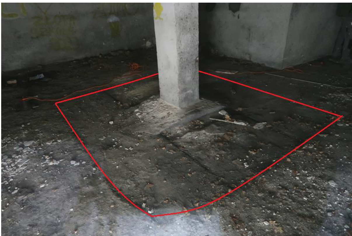
Fot. 131. Odkrywka O.24 posadzki. Widoczny obrys stopy fundamentowej o wymiarach w rzucie 290,0x330,0cm.
