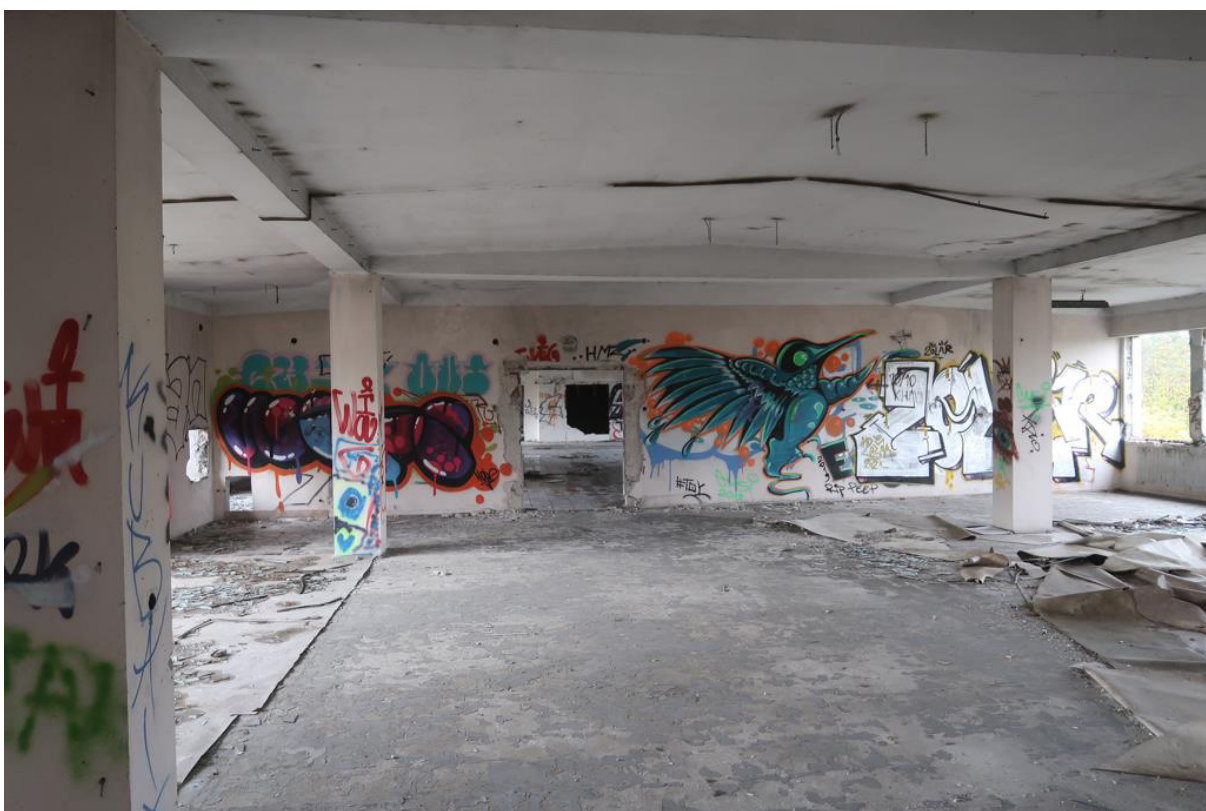
Fot. 14. Pomieszczenie osiach 19-22 w części B budynku na II piętrze. Widoczny pochyły stropodach gęstożebrowy Teriva.
