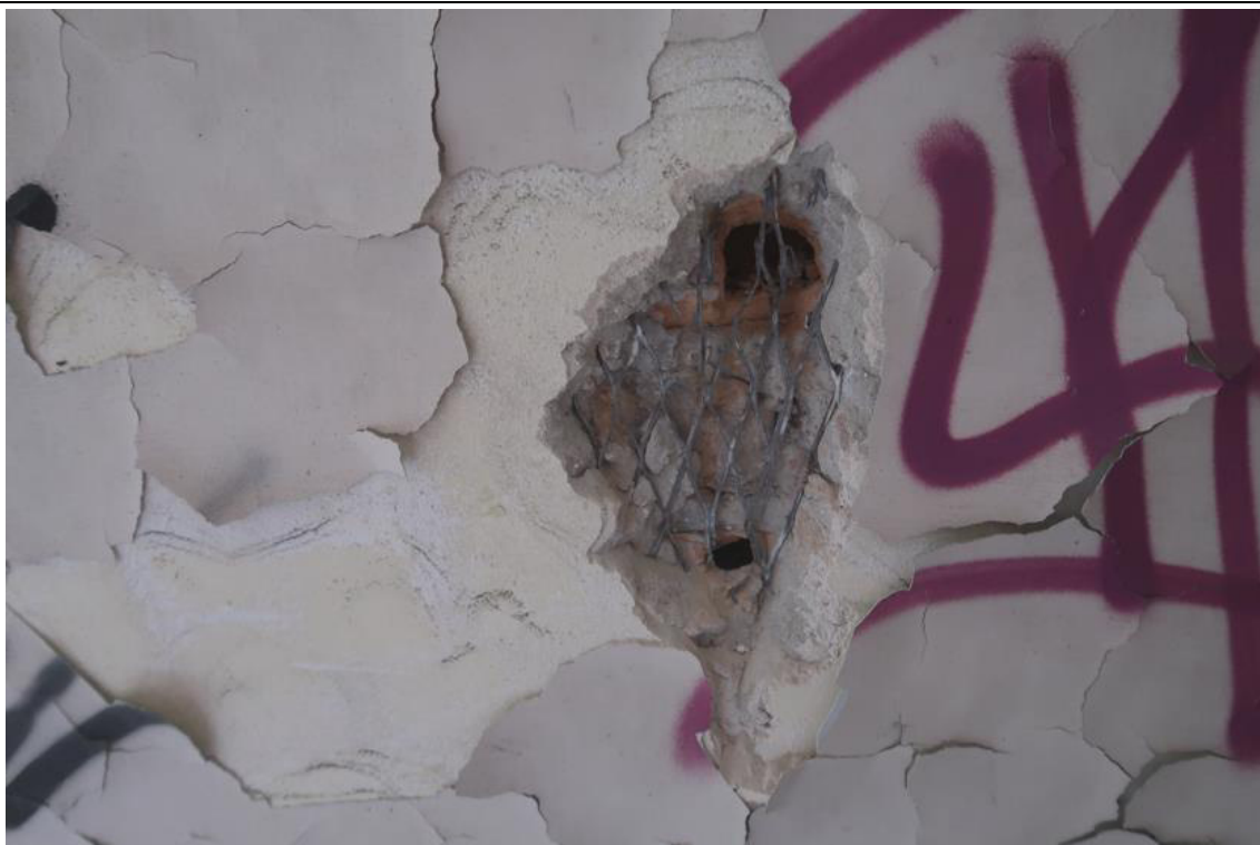
Fot. 26. Odkrywka O.64 ściany zewnętrznej. Stwierdzono konstrukcję ściany gr. 47cm z cegły ceramicznej dziurawki murowanej na zaprawie cementowo-wapiennej. Tynk c-w gr. 3,5cm na siatce stalowej cięto-ciagnionej.
