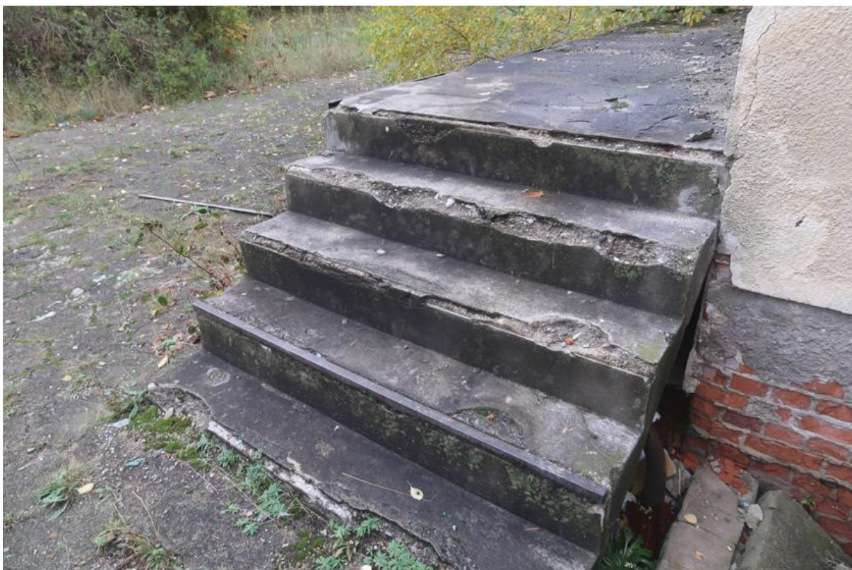
Fot. 152. Zerodowane żelbetowe schody terenowe na rampę na zachodniej elewacji w osiach 13-14 (część A budynku).
