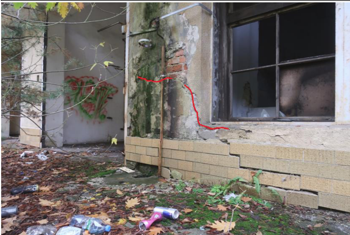
Fot. 40. Zarysowanie skośne, odparzony i zagłonięty tynk oraz odparzone płytki cokołu na wschodniej elewacji w osiach E/6-8 części A budynku.
