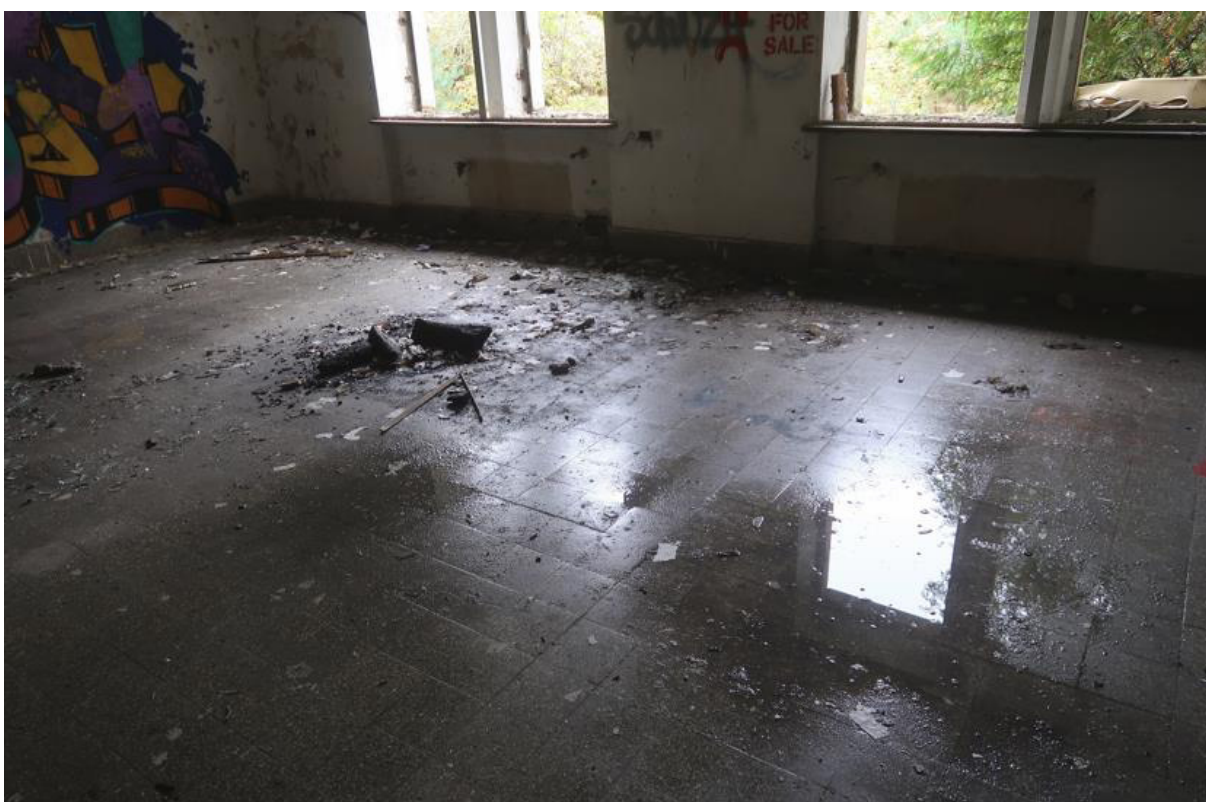
Fot. 145. Zalana posadzka z płytek lastryko w pomieszczeniu w osiach D-F/1-2 na parterze (część A budynku).
