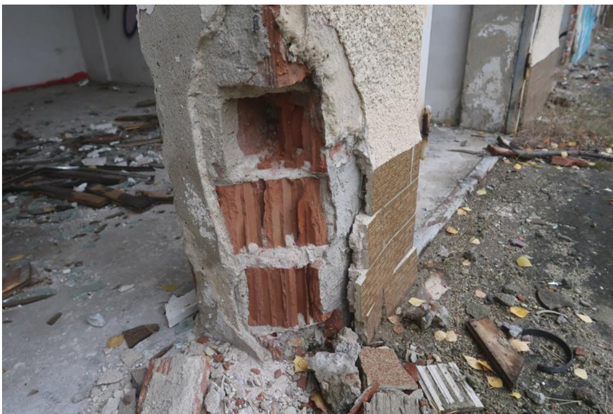
Fot. 35. Odparzony tynk, płytki cokołu oraz pustaki kratowe w filarku na zachodniej elewacji w osiach A'/18-19 części B budynku.
