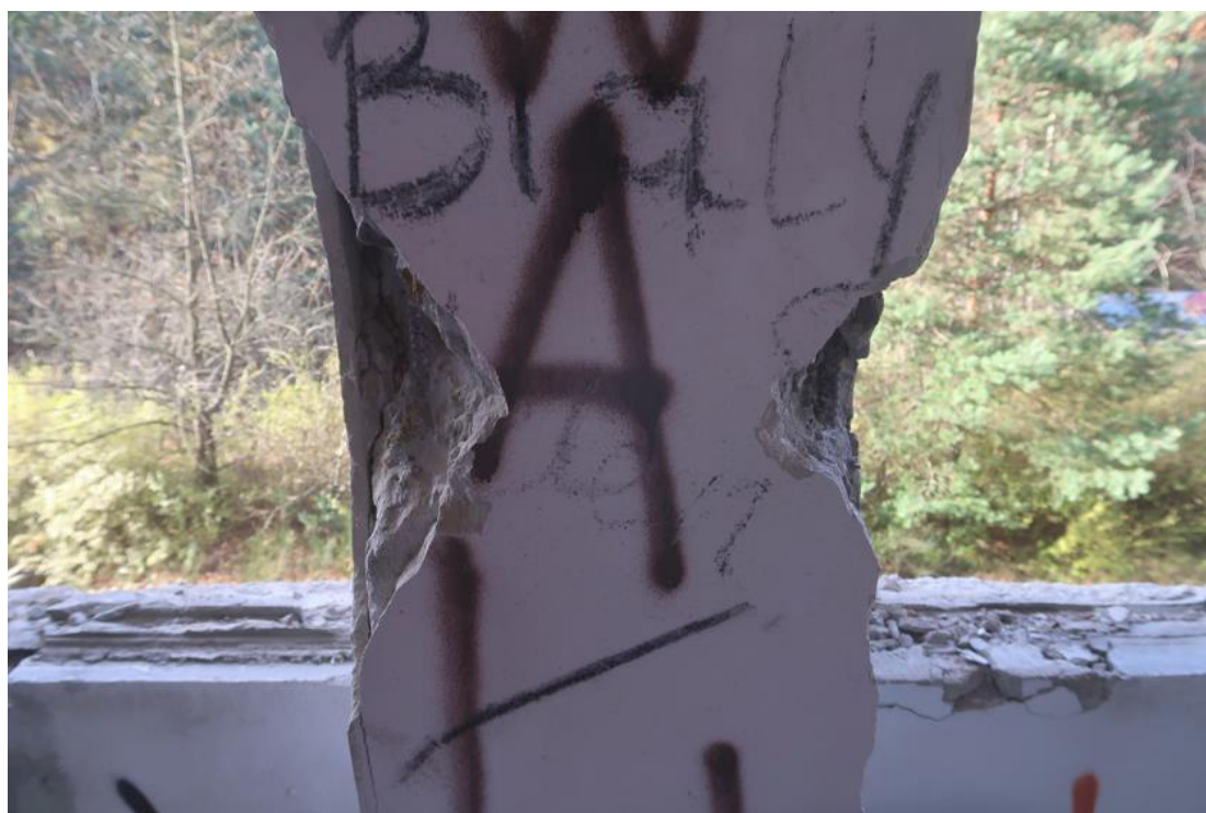
Fot. 116. Odkrywka O.41 słupa. W odkrywce stwierdzono słup żelbetowy o przekroju 35,0 \times 44,0\text{cm} (pomiar z tynkiem gr. 1,0 \div 2,0\text{cm} ), zbrojony podłużnie prętami żebrowanymi #14 (2 pręty na krótkim boku). Otulina zbrojenia wynosi 20 \div 45\text{mm} . Do słupa jest dostawiona zewnętrzna ściana murowana z ceramicznej cegły pełnej o gr. 15,0\text{cm} wraz z tynkiem.
