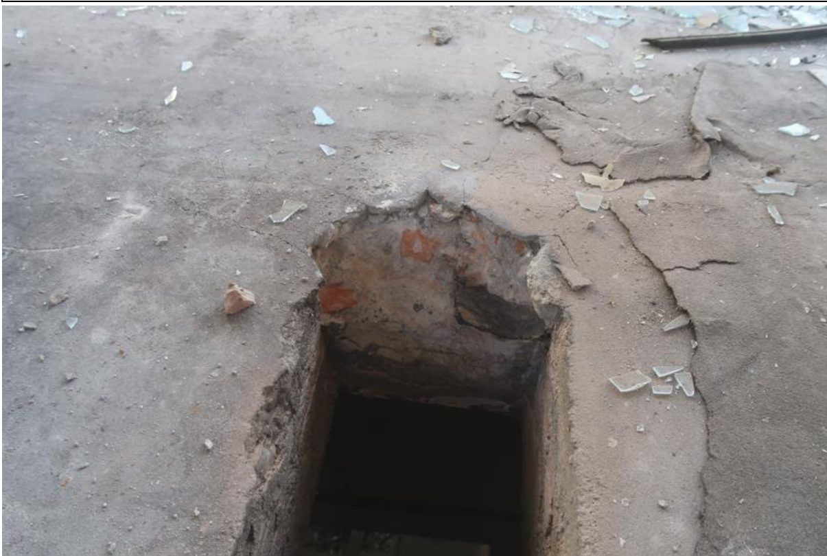
Fot. 136. Odkrywka O.36 posadzki. Stwierdzono wylewkę cementową gr. 7,0cm leżącą na stropie (płyta żelbetowa gr. 13,0cm).
