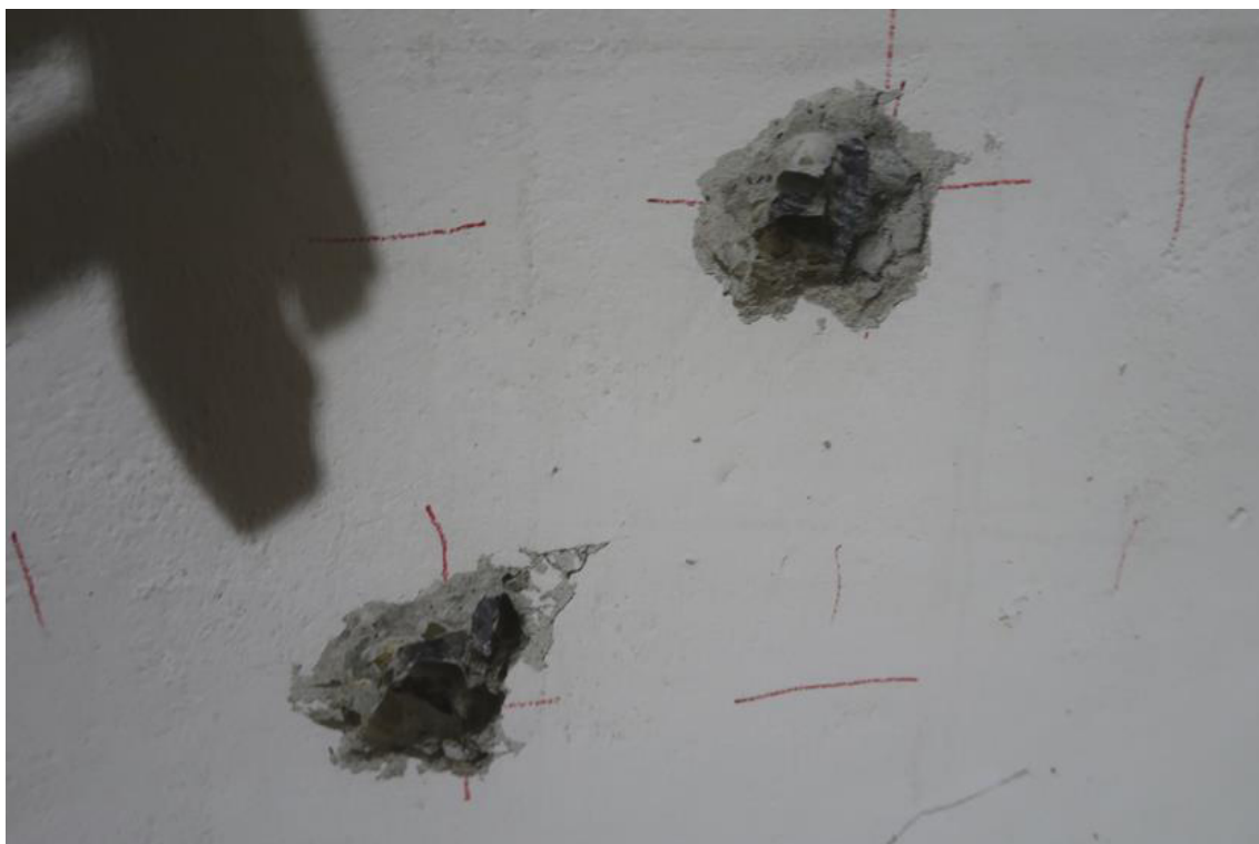
Fot. 58. Odkrywka O.18 stropu. W odkrywce stwierdzono płytę żelbetową gr. 18,0cm zbrojoną dołem prętami żebrowanymi #10 i #16 (naprzemiennie) w rozstawie co 14÷18cm. Kierunek zbrojenia głównego prostopadły do ram żelbetowych. Zbrojenie rozdzielcze z prętów #10 co 20,0cm. Otulina zbrojenia wynosi 10mm.
