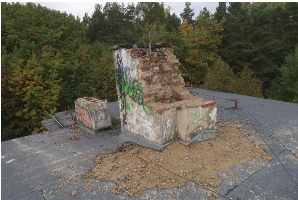
Fot. 174. Uszkodzony komin na dachu w osiach A-C/1-2 (część A budynku). Widoczna porastająca roślinność w kominie oraz ubytki cegieł. Tynk i luźne fragmenty cegieł zalegają na pokryciu przy kominie.
