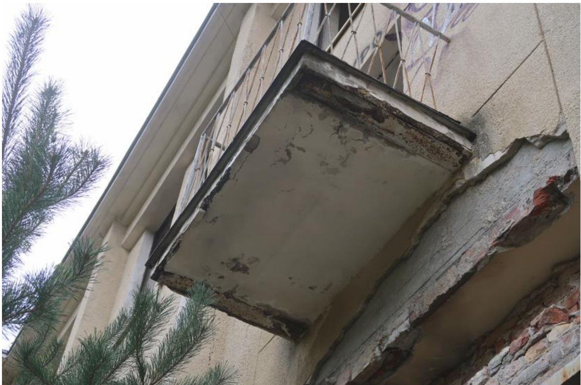
Fot. 161. Balkon wspornikowy na belkach stalowych w poziomie I piętra na zachodniej elewacji w osiach B/4-5 (część A budynku). Widoczny odparzony tynk w miejscu belek stalowych oraz korozja powierzchniowa belek.
