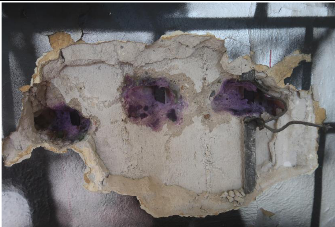
Fot. 113. Odkrywka O.31 słupa. W odkrywce stwierdzono słup żelbetowy o przekroju 40,0x84,0cm (pomiar z tynkiem gr. 1,0÷3,0cm), zbrojony podłużnie prętami grzebieniowymi #20x20 (nr 30 wg [21]) - 3 pręty na krótkim boku. Otulina zbrojenia wynosi 40mm. Beton jest niskiej jakości, słabo zagęszczony (z kawernami). Do słupa z dwóch stron jest dostawiona ściana murowana z ceramicznej cegły pełnej gr. 2-ch cegieł (58,0cm z tynkiem).
