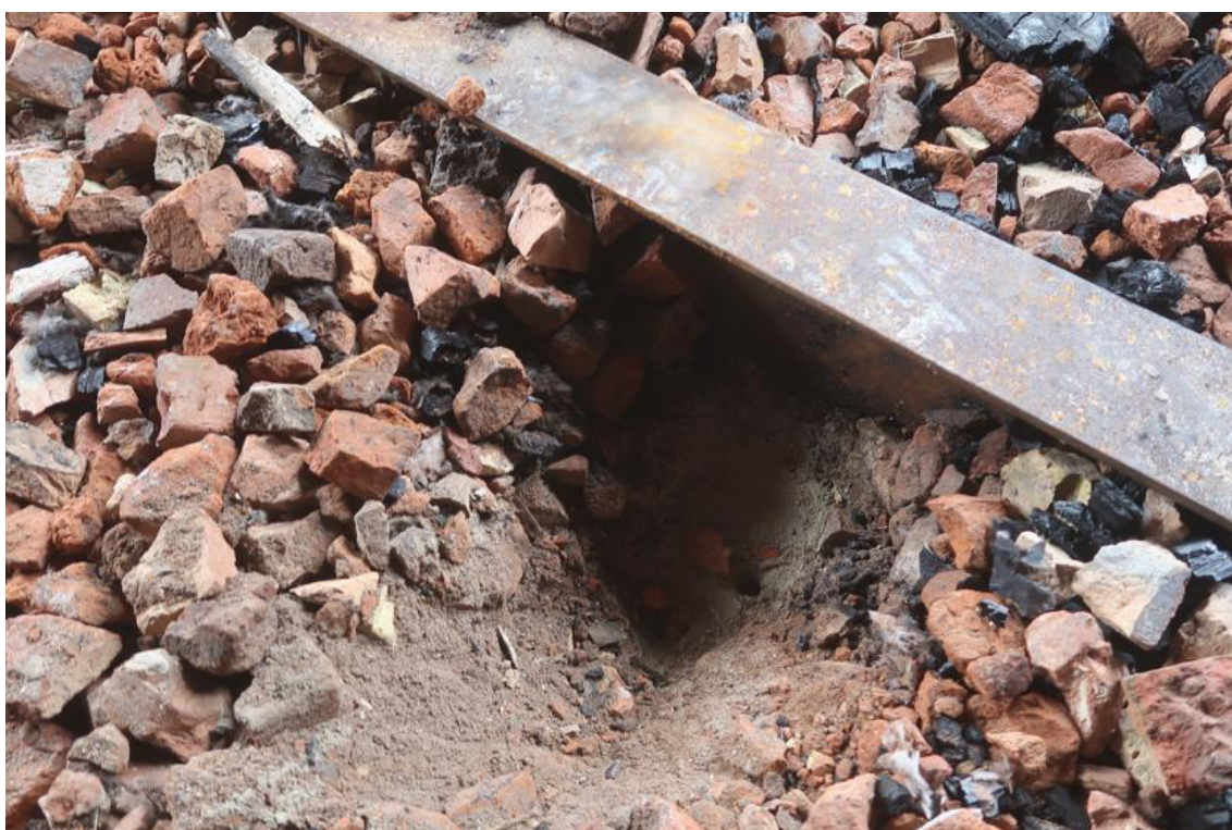
Fot. 141. Odkrywka O.67 posadzki. Stwierdzono parkiet gr. 2,0cm, deski gr. 2,5cm leżące na legarach i pospółce gruzowej o gr. ~24cm. Wierzch posadzki jest 35,5cm ponad wierzchem płyty gruzobetonowej stropu Kleina (płyta gr. 8,0cm). Belki stalowe wykonane z dwuteowników IPN320 w rozstawie co ok. 195cm, skorodowane powierzchniowo.
