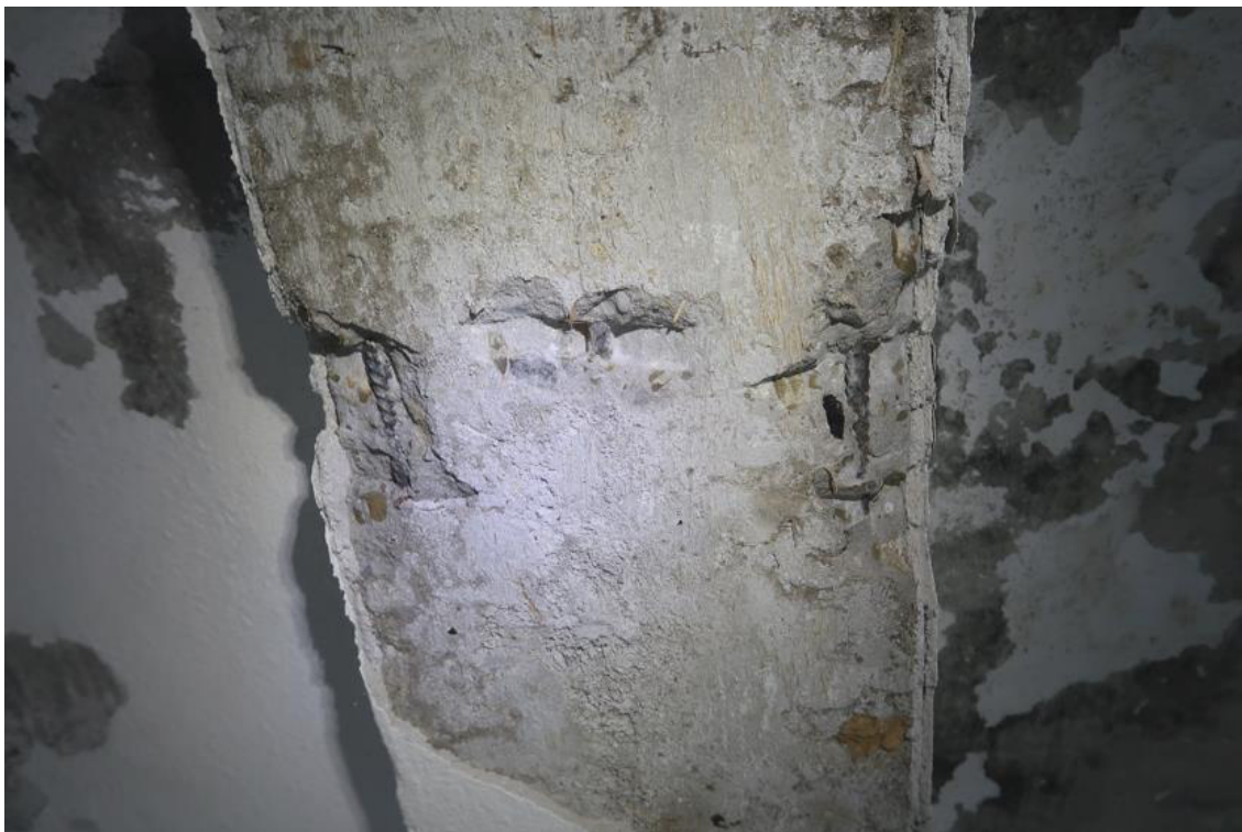
Fot. 80. Odkrywka O.56 podciagu. W odkrywce stwierdzono podciąg żelbetonowy o przekroju 30,0x40,0cm (pomiar z tynkiem gr. 2,0cm, wraz z grubością stropu gęstożebrowego 24,0cm), zbrojony podłużnie dołem prętami żebrowanymi 3#10. Strzemiona \phi 6 . Otulina zbrojenia wynosi 15mm. Występuje karbonatyzacja betonu na gł. 2,0cm.
