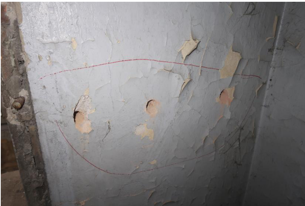
Fot. 23. Odkrywka O.6 ściany wewnętrznej. Stwierdzono konstrukcję ściany z cegły ceramicznej pełnej murowanej na zaprawie cementowo-wapiennej. Tynk c-w gr. 2,0cm.
