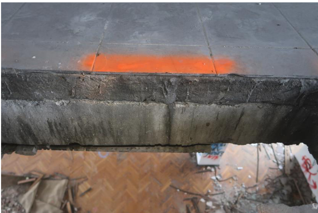
Fot. 139. Odkrywka O.62 posadzki. Stwierdzono płytki ceramiczne gr.1,0cm, wylewkę cementową gr. 9,0cm leżącą na stropie (płyta żelbetowa gr. 18,0cm).
