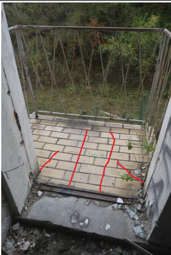
Fot. 162. Zarysowanie płytek ceramicznych wykończenia posadzki na balkonie.
