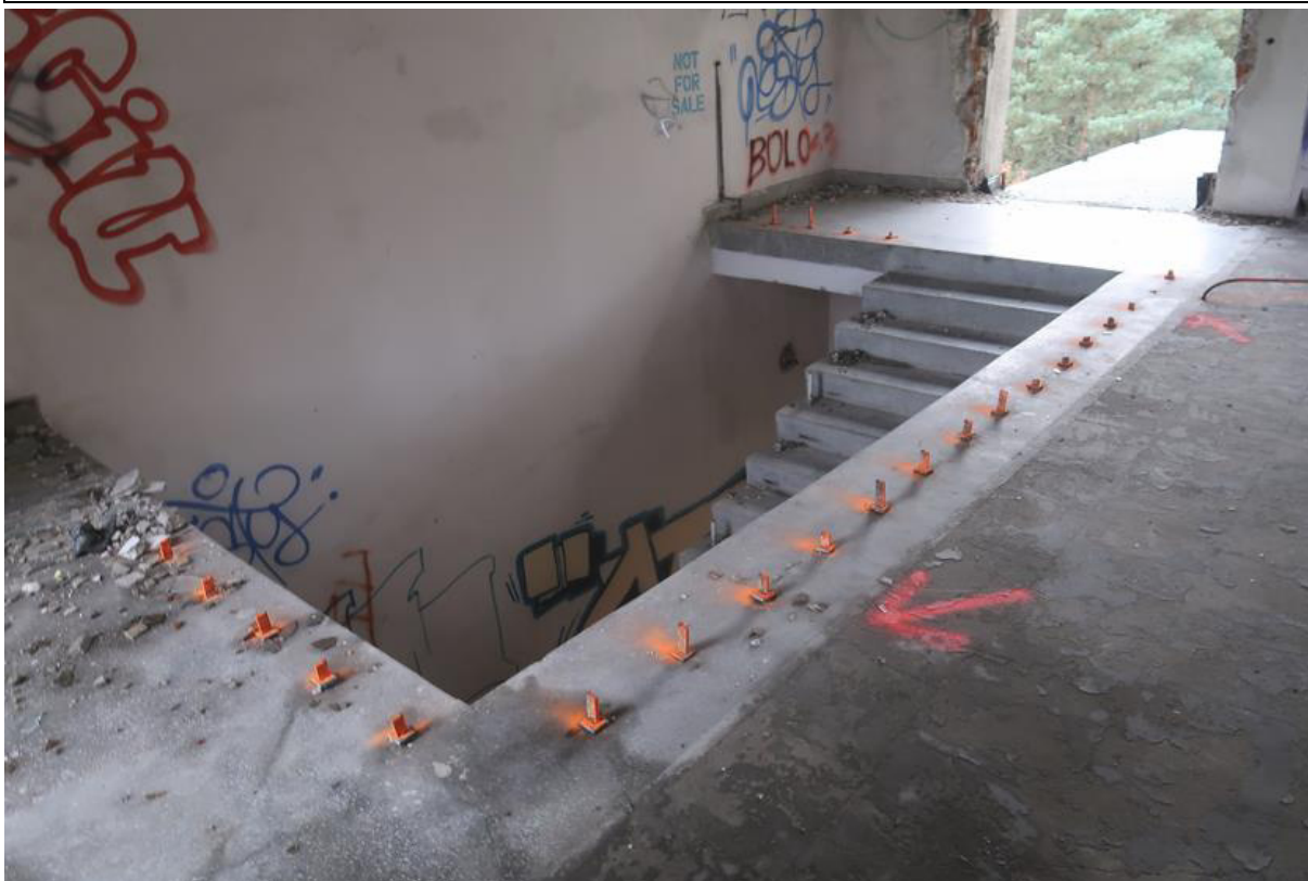
Fot. 159. Wycięta balustrada stalowa na klatce schodowej w poziomie II piętra w osiach C'-E'/22-23 (część B budynku).
