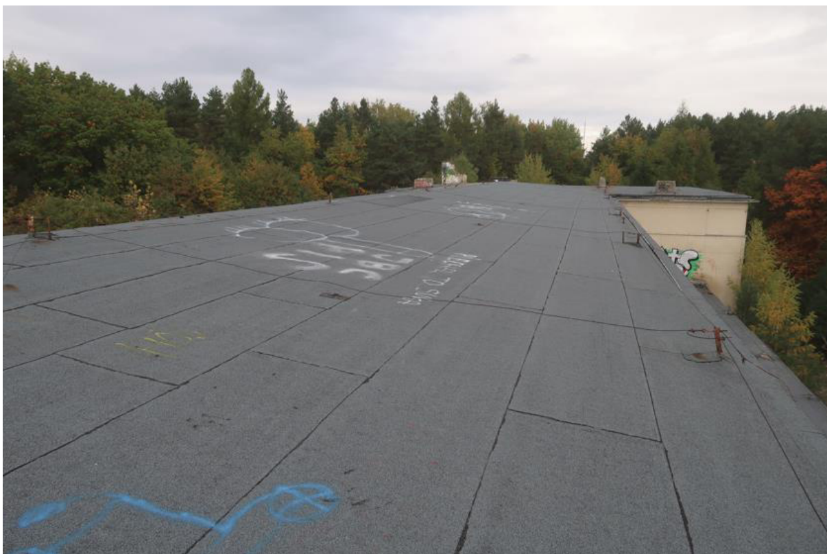
Fot. 169. Pokrycie stropodachu z papy w osiach B-D/2-12 części A przedmiotowego budynku.
