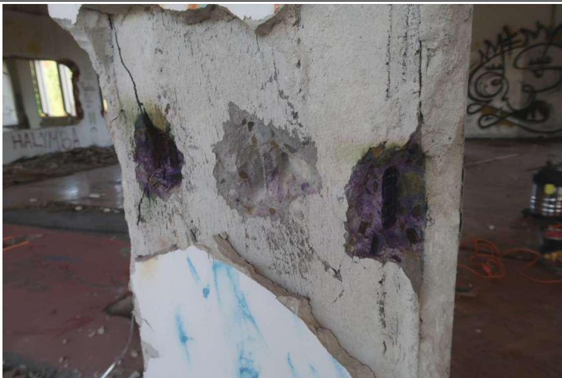
Fot. 117. Odkrywka O.42 słupa. W odkrywce stwierdzono słup żelbetowy o przekroju 43,0x52,0cm (pomiar z tynkiem gr. 1,0÷5,0cm, żelbet 35,0x45,0), zbrojony podłużnie prętami żebrowanymi #18 (3 pręty na krótkim boku). Otulina zbrojenia wynosi 30mm.
