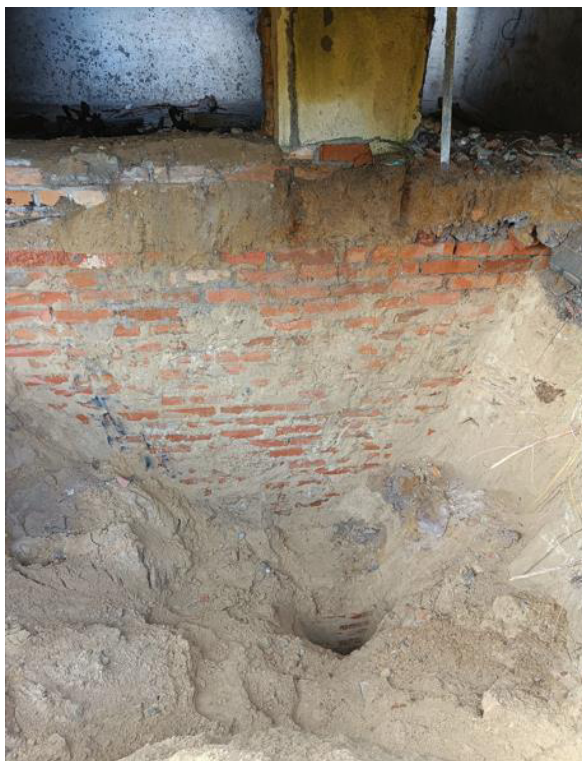
Fot. 16. Odkrywka F.2. fundamentów. W wykonanej odkrywce stwierdzono ławę fundamentową ceglana gr. min. 40,0cm z odsadzką 65,0cm. Ściana fundamentowa murowana z ceramicznej cegły pełnej, z pionową izolacją p.wilgociową z papy (ze ścianką osłonową gr. 1/2 cegły). Ława jest posadowiona około 250,0cm p.p.t. Na odsadzce widoczna jest płytka betonowa gr. 10cm.
