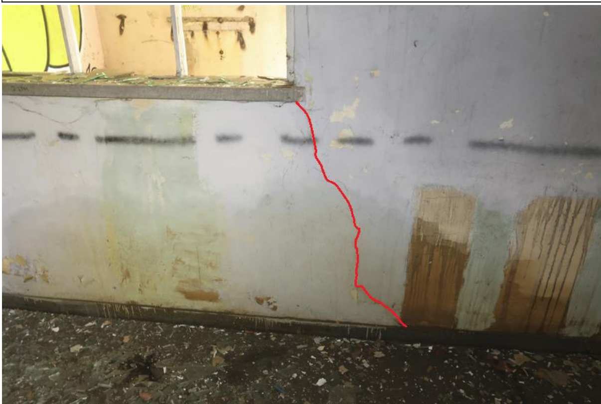
Fot. 48. Zarysowanie skośne ściany w pomieszczeniu w osiach B-C/10-11 na parterze, część A budynku.
