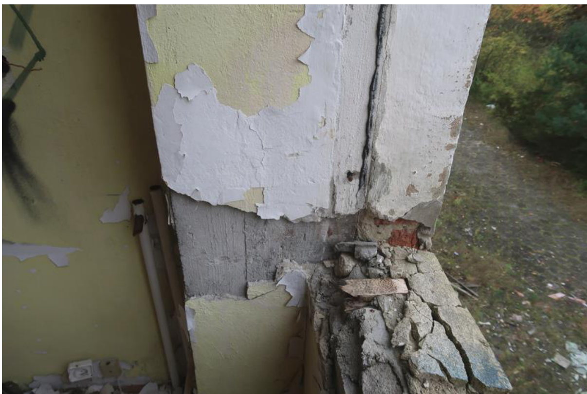
Fot. 122. Słup żelbetowy odmurowany od zewnątrz cegłą ceramiczną w osiach B'/16 części B budynku na I piętrze.
