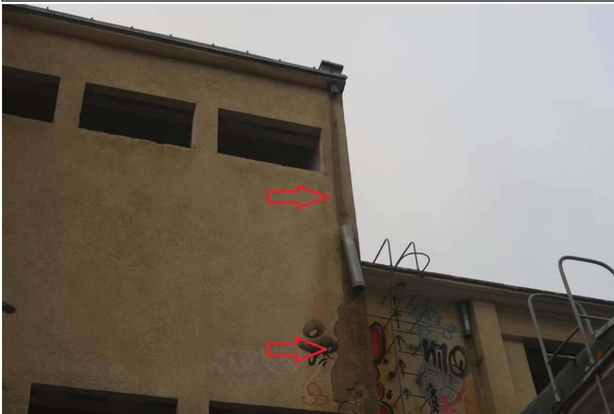
Fot. 178. Zdemontowana rura spustowa na wschodniej elewacji w osiach 14-15 (część B budynku).
