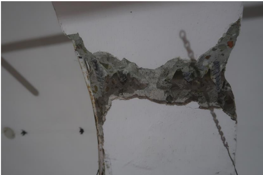
Fot. 75. Odkrywka O.51 podciągu. W odkrywce stwierdzono podciąg żelbetowy o przekroju 36,0x54,0cm (pomiar z tynkiem gr. 0,5÷1,0cm, do spodu płyty stropowej), zbrojony podłużnie dołem prętami żebrowanymi 4#20. Strzemiona \varnothing 8 . Otulina zbrojenia wynosi 20mm. Beton jest niskiej jakości, słabo zagęszczony (kawerny wypełnione tynkiem) Występuje karbonatyzacja betonu w warstwie otuliny zbrojenia.
