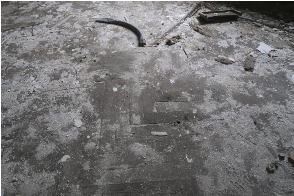
Fot. 146. Zużyty parkiet drewniany w pomieszczeniu w osiach A-C/1-2 na parterze (część A budynku).
