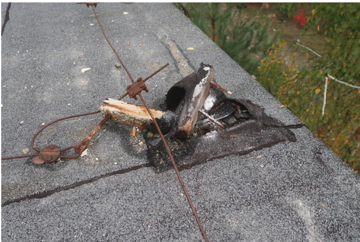
Fot. 181. Skorodowana instalacja odgromowa oraz wyrwane mocowanie instalacji na dachu w osiach E-D/12-13 (część A budynku).
