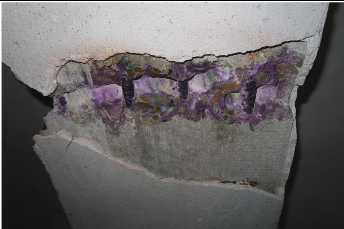
Fot. 61. Odkrywka O.23 podciagu. W odkrywce stwierdzono podciąg żelbetowy o przekroju 36,0x27,0cm (pomiar z tynkiem gr. 1,0cm, do spodu płyty stropowej), zbrojony podłużnie dołem prętami żebrowanymi 4#14. Otulina zbrojenia wynosi 10mm. Występuje karbonatyzacja betonu w warstwie otuliny zbrojenia.
