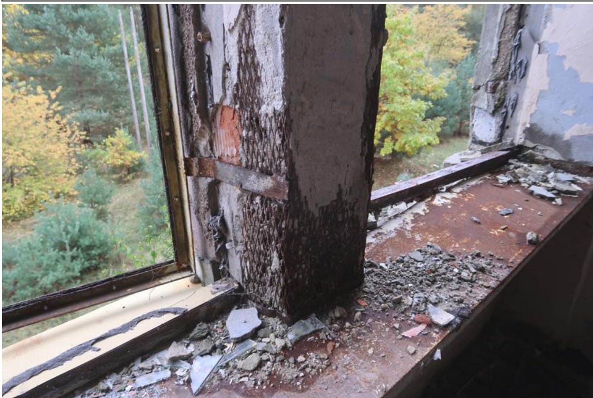
Fot. 50. Odparzony tynk na filarku międzyokiennym w pomieszczeniu w osiach F'/15-16 na I piętrze, część B budynku. Widoczny tynk wykonany na siatce stalowej cięto-ciągnionej.
