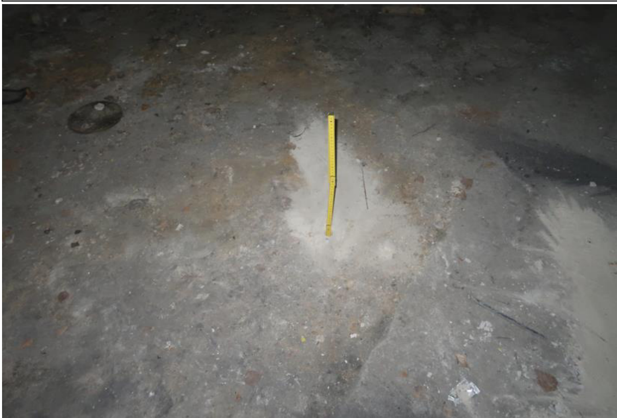
Fot. 132. Odkrywka O.25 posadzki. Stwierdzono posadzkę betonową gr. ok. 18,0cm wykonaną na warstwie gruzobetonu leżącego na podsypce piaskowej.
