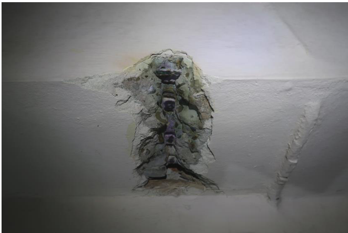
Fot. 78. Odkrywka O.54 podciagu. W odkrywce stwierdzono podciąg żelbetonowy o przekroju 38,0x38,0cm (pomiar z tynkiem gr. 1,0cm, do spodu płyty stropowej), zbrojony podłużnie dołem prętami żebrowanymi 4#18. Otulina zbrojenia wynosi 40mm. Beton jest niskiej jakości z kruszywem o dużej frakcji. Występuje karbonatyzacja betonu w warstwie otuliny zbrojenia.
