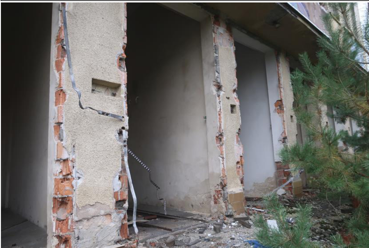
Fot. 38. Odparzony tynk, płytki cokołu oraz uszkodzone pustaki kratowe w filarkach na wschodniej elewacji w osiach F'/15-17 części B budynku.
