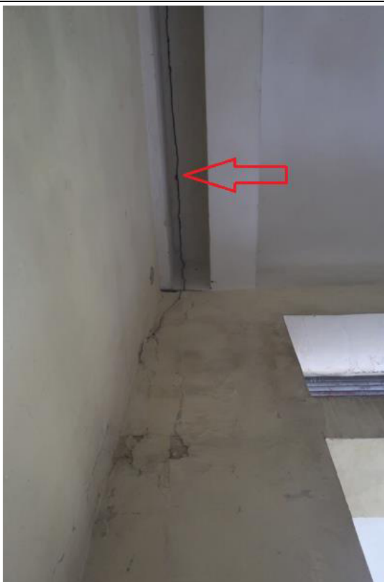
Fot. 101. Zarysowanie na suficie w miejscu dylatacji w pomieszczeniu w osiach E-D/9-10 na parterze (część A budynku).
