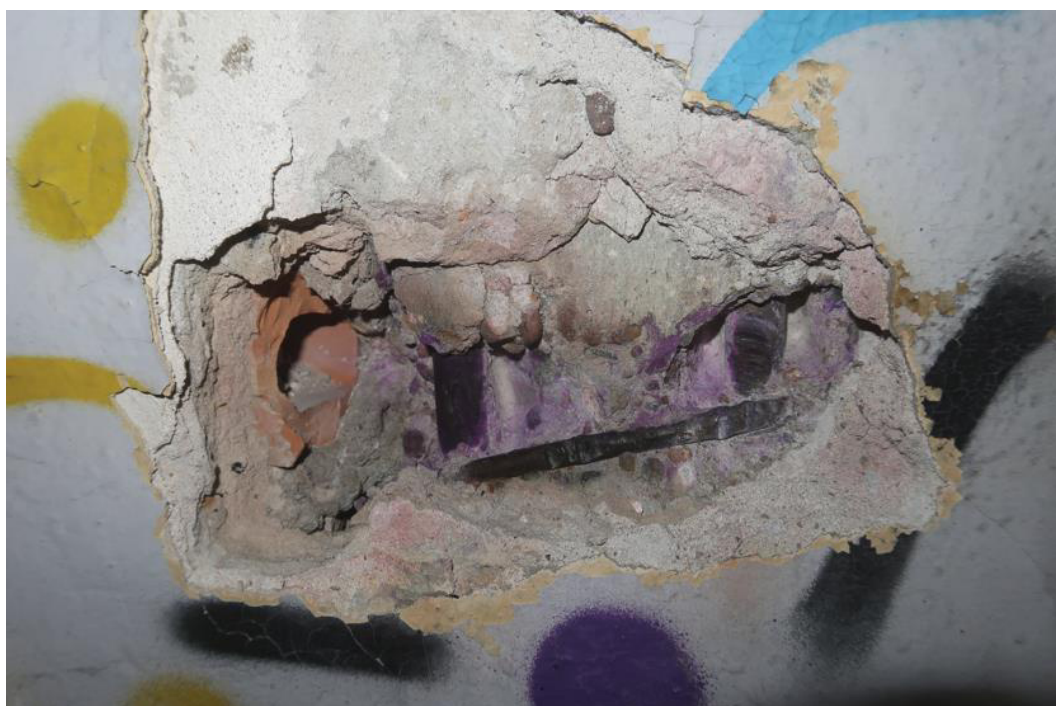
Fot. 106. Odkrywka O.3 słupa. W odkrywce stwierdzono słup żelbetowy o przekroju 39x80cm (pomiar z tynkiem gr. 1,0÷3,0cm), zbrojony podłużnie prętami gładkimi \varnothing 18 (4 pręty na krótkim boku). Otulina zbrojenia wynosi 50/30mm. Występuje karbonatyzacja betonu w warstwie otuliny zbrojenia. Pręty zbrojeniowe w elewacji skorodowane powierzchniowo. Słup jest wbudowany w ścianę murowaną ceglana o gr. 47,0cm wraz z tynkiem. Od strony zewnętrznej występuje korozja powierzchniowa zbrojenia.
