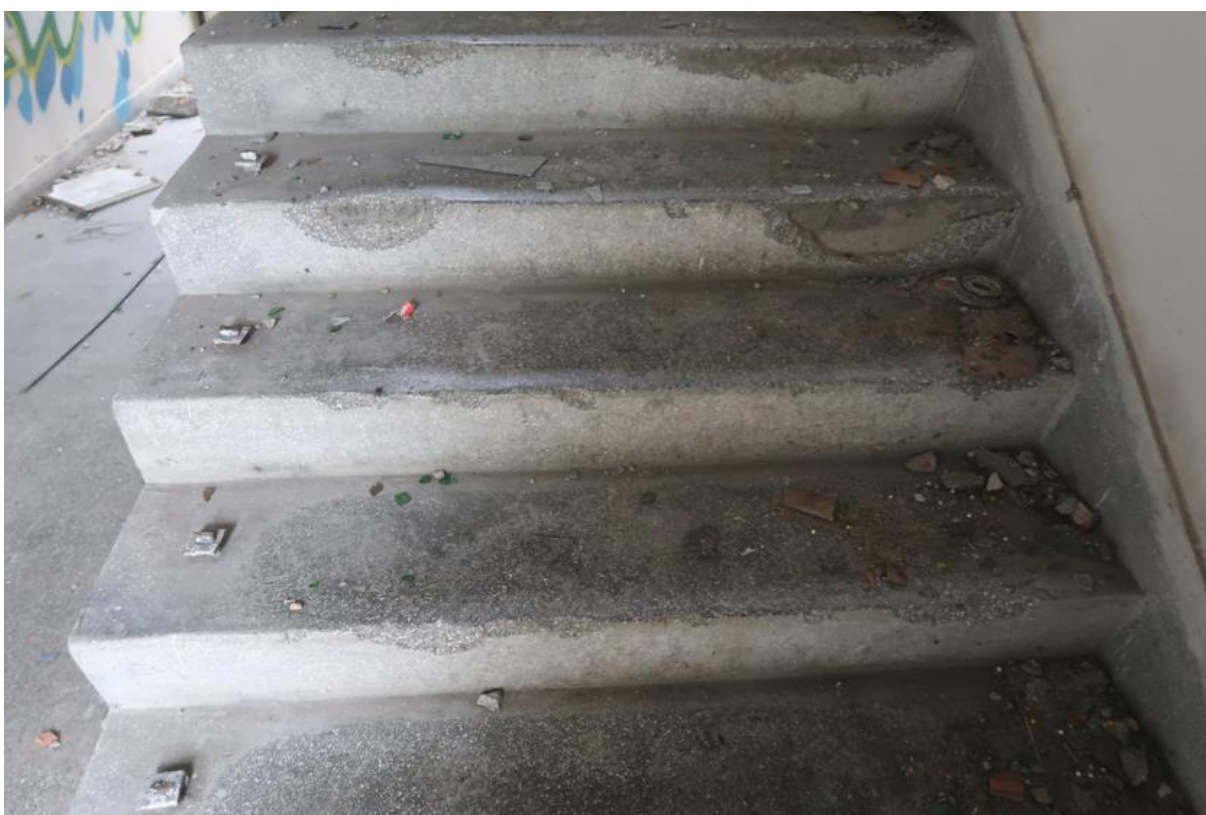
Fot. 158. Ubytki okładziny z lastryko w żelbetowych schodach zlokalizowanych w osiach B'-D'/14-15 na parterze (część B budynku). Widoczne ślady wyciętej balustrady stalowej.
