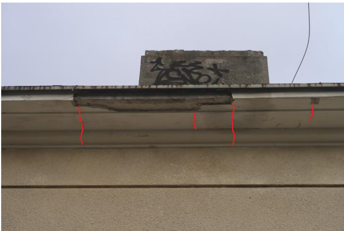
Fot. 41. Zarysowania oraz odparzony tynk na gzymsie na wschodniej elewacji w osiach E-D/2 w poziomie stropodachu.
