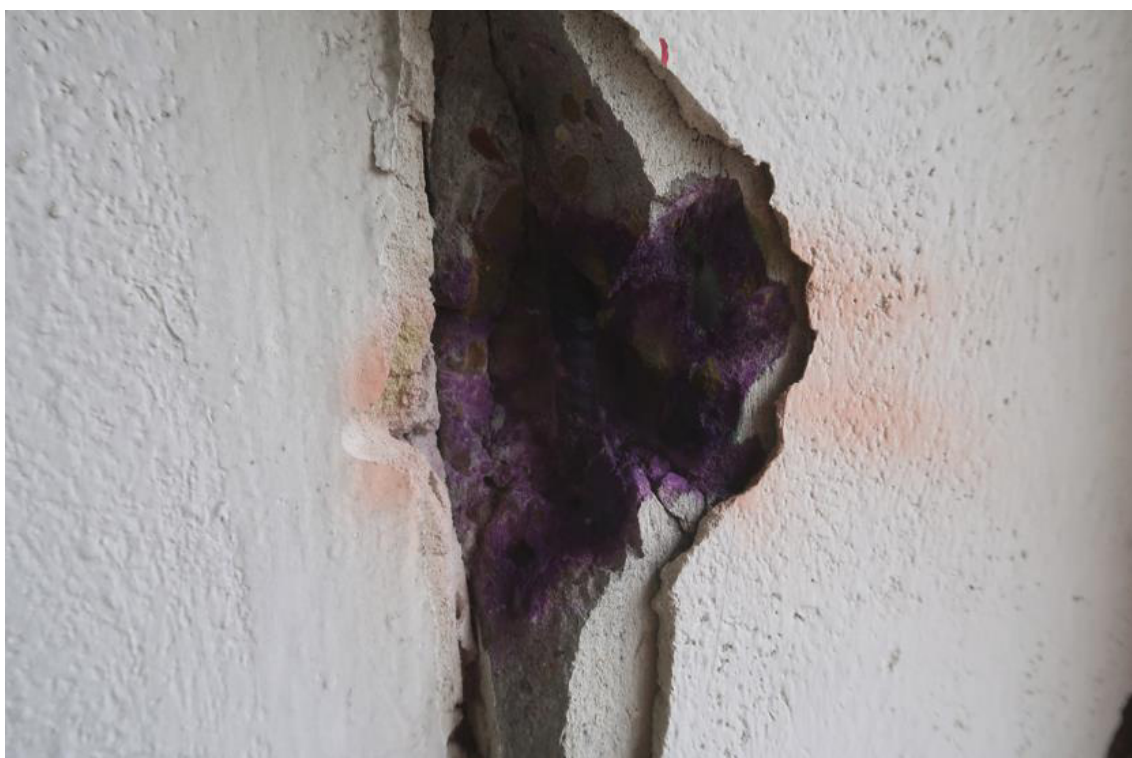
Fot. 110. Odkrywka O.15 słupa. W odkrywce stwierdzono słup żelbetowy o przekroju 35,0\times28,0\text{cm} (pomiar z tynkiem gr. 1,0\div2,0\text{cm} ), zbrojony podłużnie prętami żebrowanymi #14 (2 pręty na krótkim boku). Otulina zbrojenia wynosi 30\text{mm} . Do słupa jest dostawiona zewnętrzna ściana murowana z pustaków kratowych o gr. 28,0\text{cm} wraz z tynkiem.
