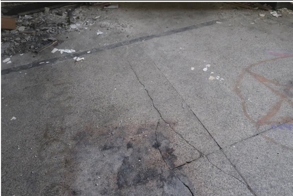
Fot. 144. Popękana posadzka betonowa w rejonie wejścia głównego do budynku w osiach C-D/2 na parterze (część A budynku).
