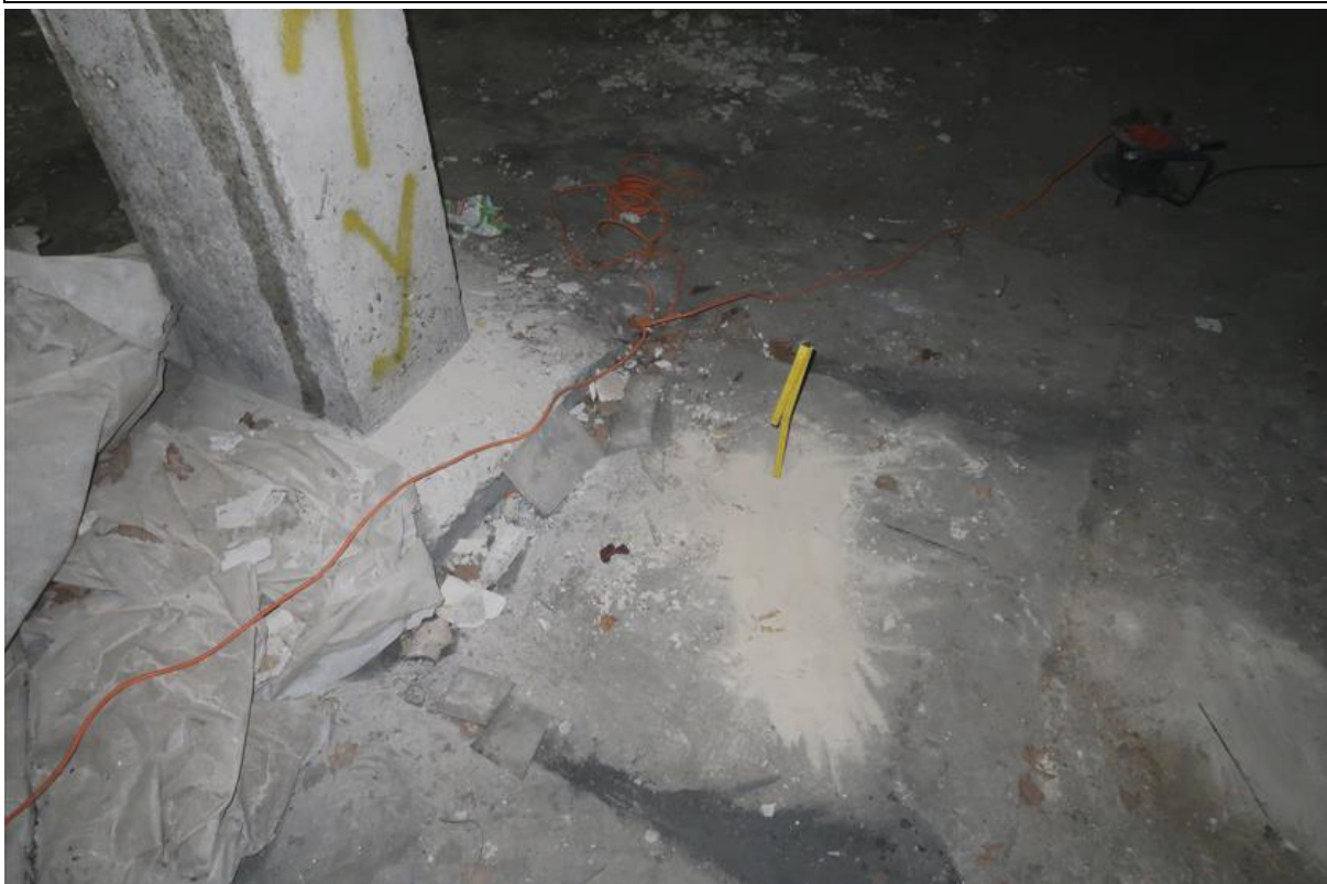
Fot. 130. Odkrywka O.24 posadzki. Stwierdzono stopę fundamentową gr. > 30,0cm o wymiarach w rzucie 290,0x330,0cm. Wierzch stopy zlicowany z wierzchem posadzki.
