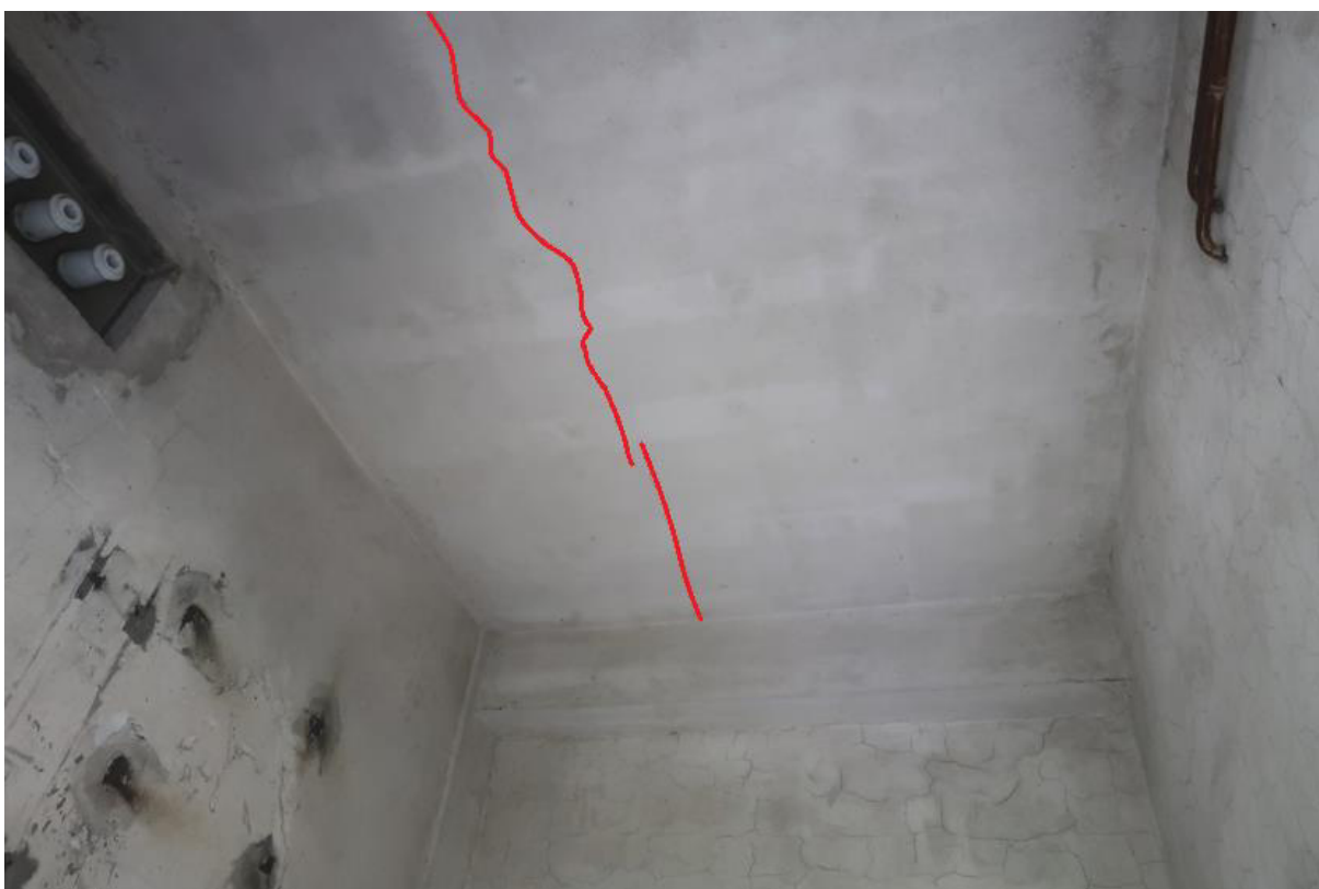
Fot. 98. Zarysowanie na suficie w pomieszczeniu w osiach A'-C'/19-20 części B budynku na parterze.
