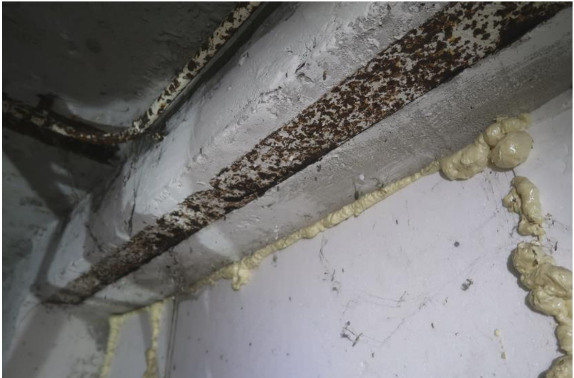
Fot. 55. Odkrywka O.75 nadproża. Stwierdzono nadproże z belek stalowych wykonanych z dwuteowników IPN180, skorodowanych powierzchniowo. Przestrzeń pomiędzy belkami wypełniona jest cegłą.
