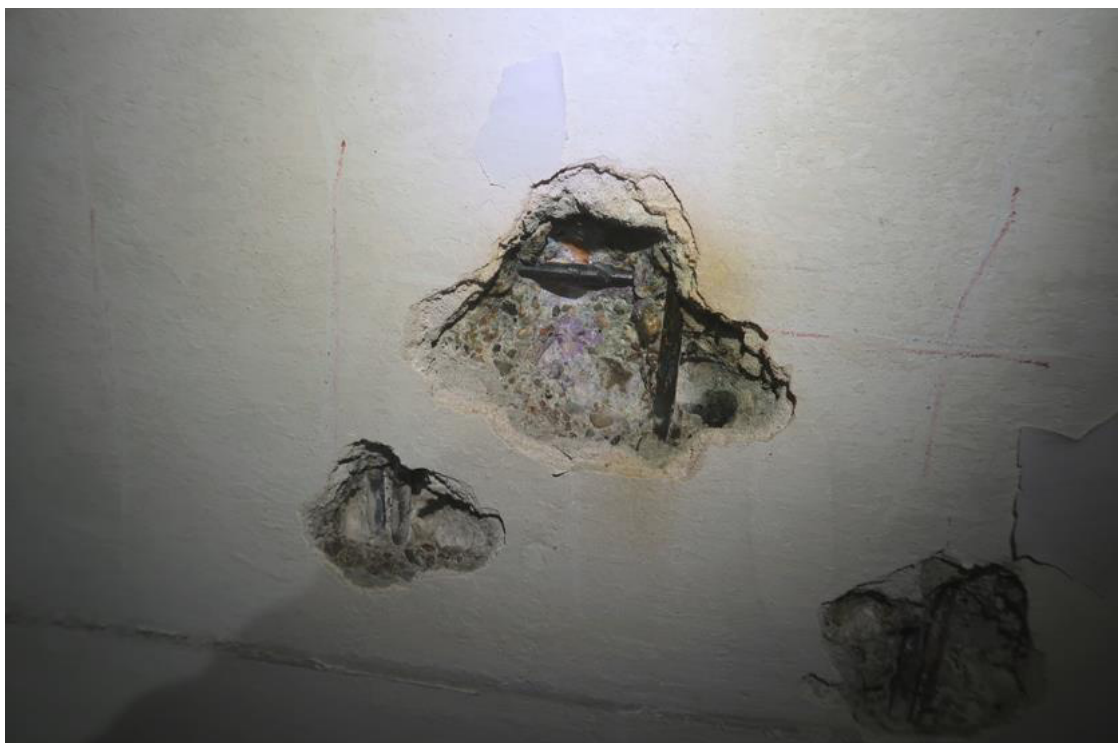
Fot. 70. Odkrywka O.46 stropu. W odkrywce stwierdzono płytę żelbetonową zbrojoną dołem prętami gładkimi Ø8 (co drugi podwójny) w rozstawie co 15,0cm. Kierunek zbrojenia głównego jest prostopadły do żeber stropowych. Zbrojenie rozdzielcze z prętów Ø8 co 30,0cm. Otulina zbrojenia wynosi 10mm. Występuje karbonatyzacja betonu na gł. 2,0cm.
