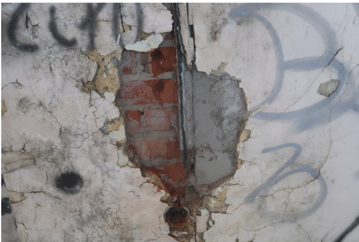
Fot. 25. Odkrywka O.34 ściany zewnętrznej. Stwierdzono konstrukcję ściany z cegły ceramicznej pełnej murowanej na zaprawie cementowo-wapiennej. Tynk c-w gr. 2,0cm.
