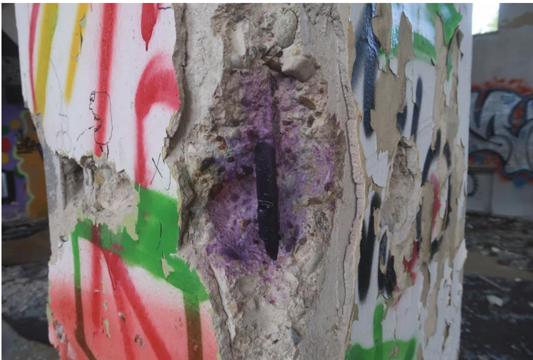
Fot. 114. Odkrywka O.32 słupa. W odkrywce stwierdzono słup żelbetowy o przekroju 40,0x64,0cm (pomiar z tynkiem gr. 1,0÷2,0cm), zbrojony podłużnie prętami grzebieniowymi #20x20 (nr 30 wg [21]) - 3 pręty na krótkim boku i #12x12 (nr 18 wg [21]) - 1 pręt na długim boku. Otulina zbrojenia wynosi 30÷50mm. Beton jest niskiej jakości, słabo zagęszczony (z kawernami). Występuje karbonatyzacja betonu na gł. 2,0cm.
