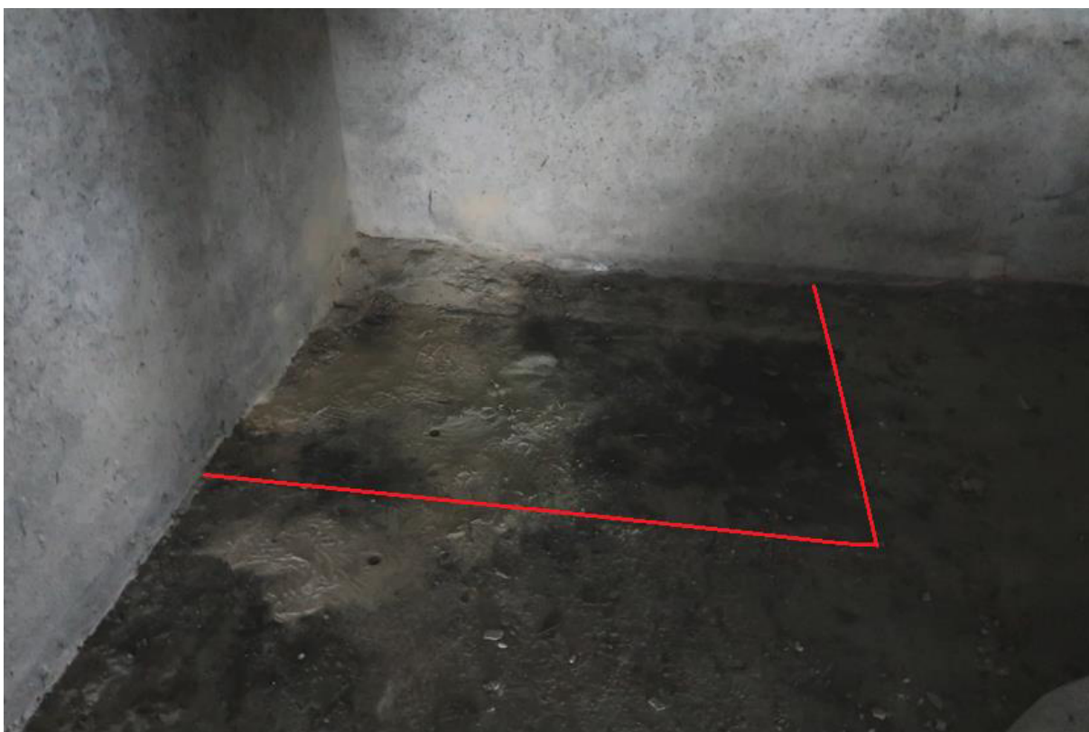
Fot. 133. Odkrywka O.26 posadzki. Stwierdzono stopę fundamentową gr. > 30,0cm o wymiarach w rzucie 290,0x330,0cm. Wierzch stopy zlicowany z wierzchem posadzki.
