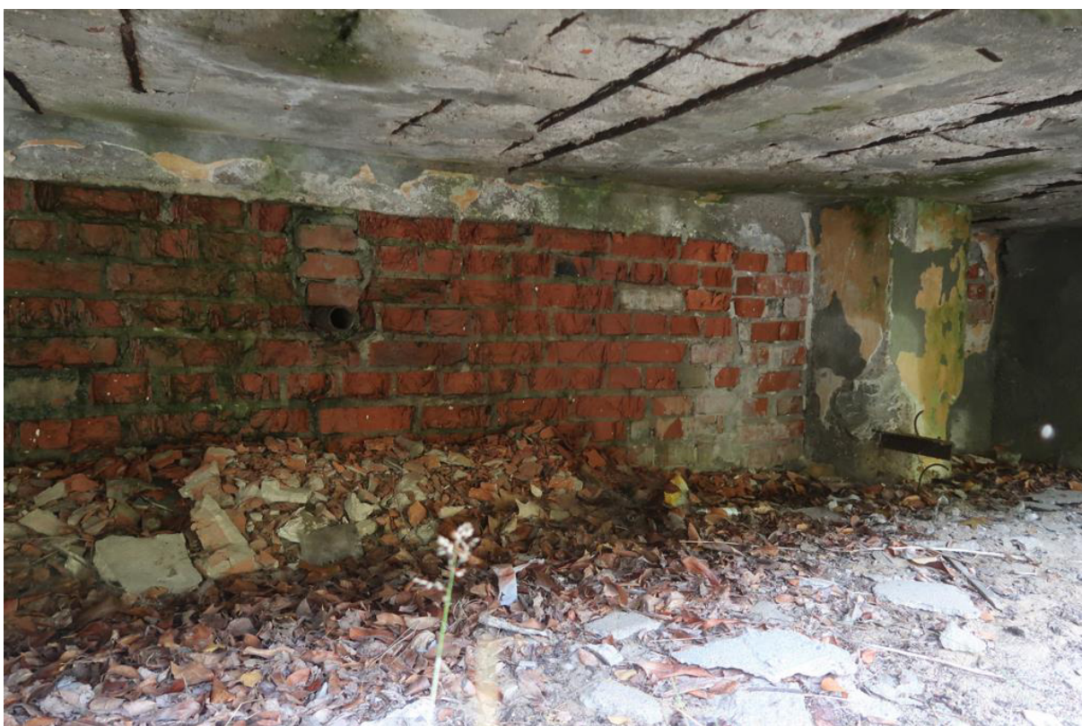
Fot. 33. Odparzony tynk i erozja wierzchniej warstwy cegieł pod rampą na zachodniej elewacji w osiach B/10-12 części A budynku.
