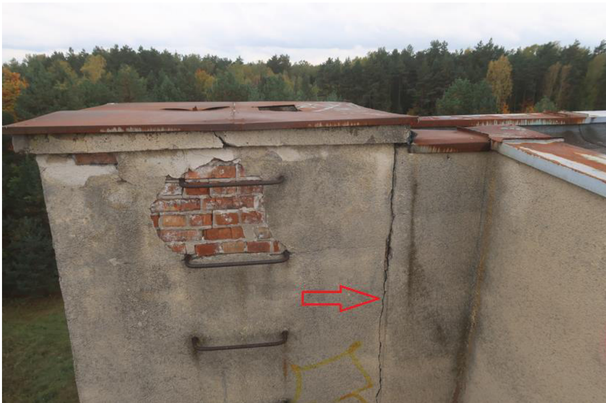
Fot. 177. Zarysowanie pionowe ściany w miejscu dostawienia komina do ścian klatki schodowej w osiach E'/22-23 (część B budynku). Widoczny odparzony tynk na kominie.
