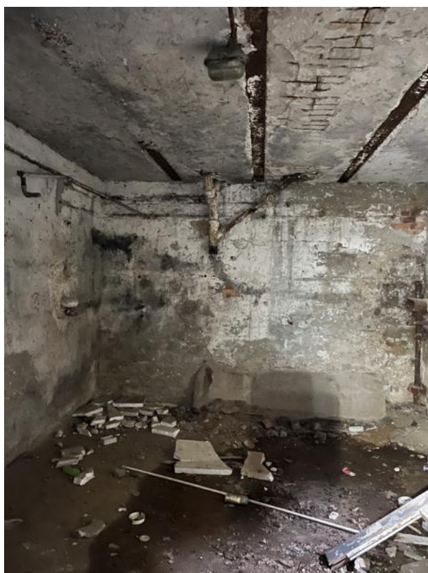
Fot. 94. Korozja płytowa belek nośnych stropu Kleina oraz odparzona otulina zbrojenia i korozja odkrytego zbrojenia w płytach pomiędzy belkami w osiach A-C/1-2 w piwnicy (część A budynku).
