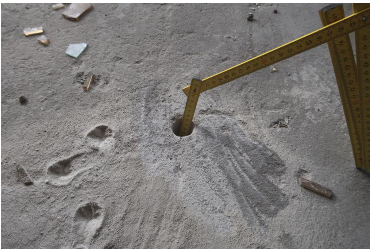
Fot. 129. Odkrywka O.16 posadzki. Stwierdzono posadzkę betonową gr. ok. 14,0cm wykonaną na warstwie gruzobetonu leżącego na stropie nad piwnicą (płyta żelbetowa gr. 16,0cm).
