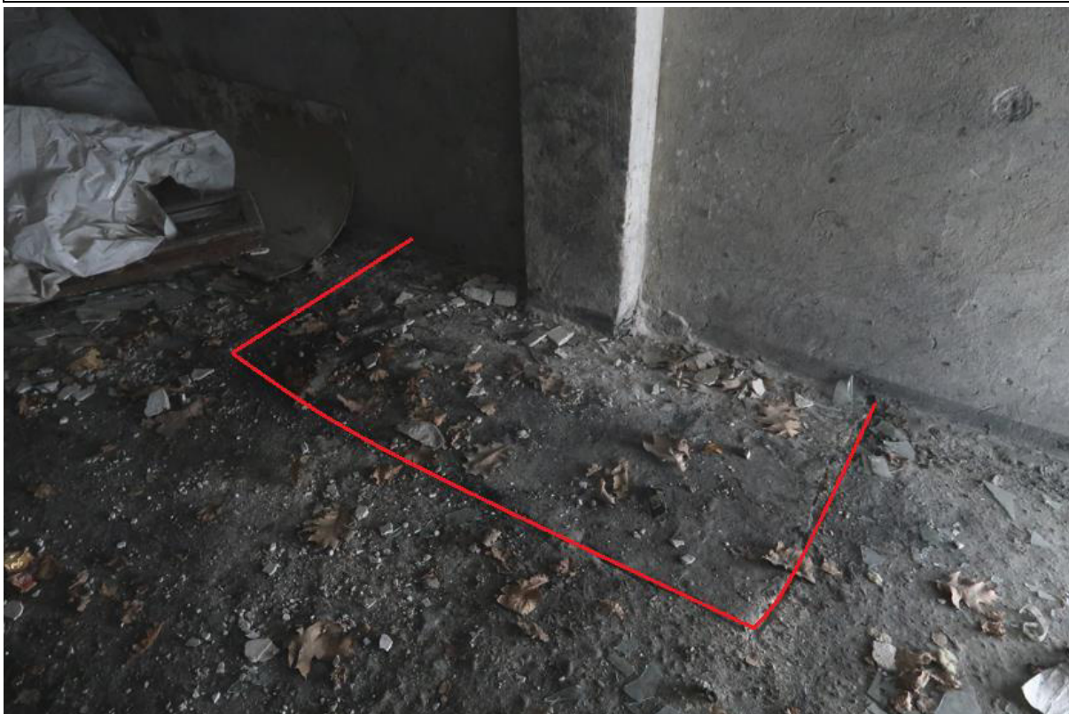
Fot. 134. Odkrywka O.27 posadzki. Stwierdzono stopę fundamentową gr. > 30,0cm o wymiarach w rzucie 185,0x200,0cm. Wierzch stopy zlicowany z wierzchem posadzki.
