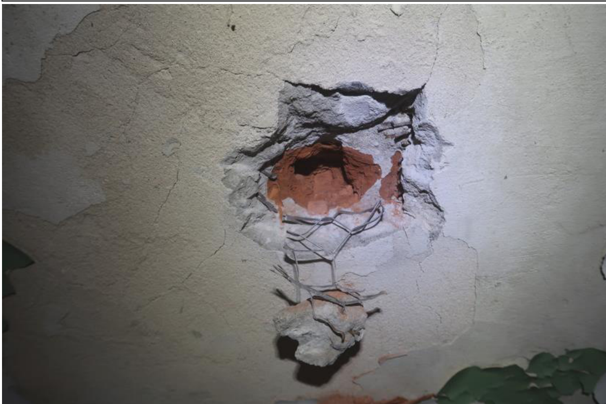
Fot. 28. Odkrywka O.70 ściany zewnętrznej. Stwierdzono konstrukcję ściany gr. 60cm z cegły ceramicznej dziurawki murowanej na zaprawie cementowo-wapiennej. Tynk c-w gr. 3,0cm na siatce stalowej cięto-ciagnionej.
