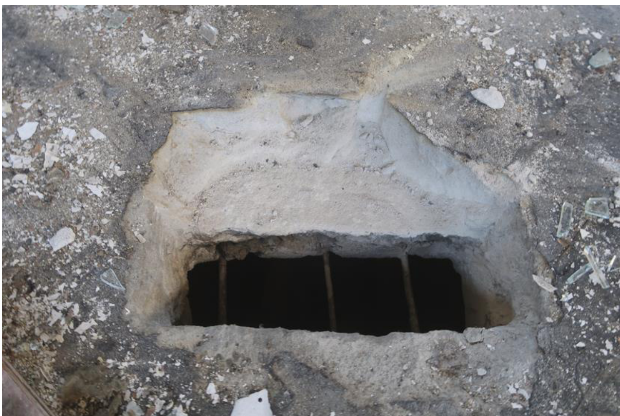
Fot. 135. Odkrywka O.35 posadzki. Stwierdzono parkiet gr.2,0cm (klejony lepikiem smołowym) i wylewkę cementową gr. 7,0cm leżącą na stropie (płyta żelbetowa gr. 10,0cm zbrojona dołem prętami gładkimi \varnothing 6 i 8 naprzemiennie).
