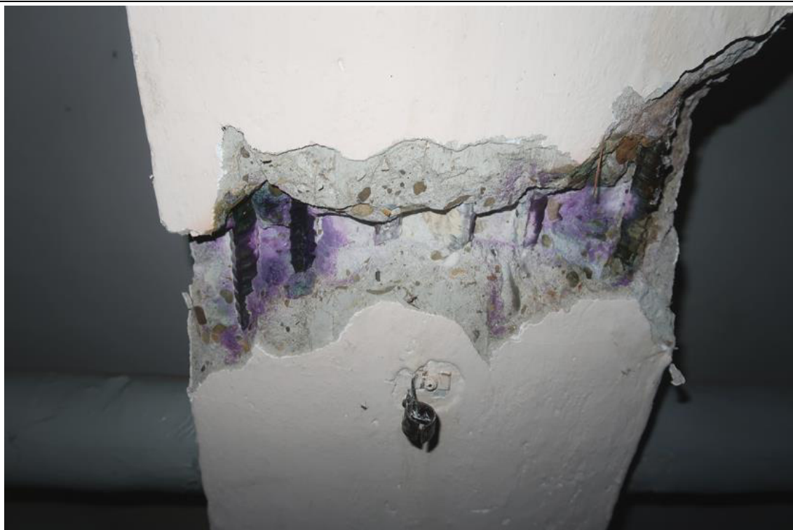
Fot. 57. Odkrywka O.17 podciagu. W odkrywce stwierdzono podciąg żelbetowy o przekroju 36,0x55,0cm (pomiar z tynkiem gr. 1,0cm, do spodu płyty stropowej), zbrojony podłużnie dołem prętami żebrowanymi 6#20. Otulina zbrojenia wynosi 20mm. Występuje karbonatyzacja betonu w warstwie otuliny zbrojenia.
