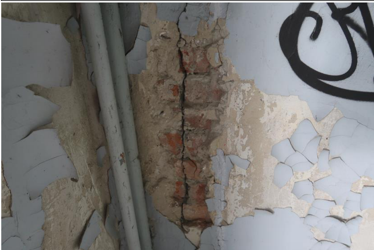
Fot. 24. Odkrywka O.11 ściany wewnętrznej. Stwierdzono konstrukcję ściany z cegły ceramicznej pełnej murowanej na zaprawie cementowo-wapiennej zarysowaną pionowo, o rozwarości rysy 5mm. Tynk c-w gr. 2,0cm.
