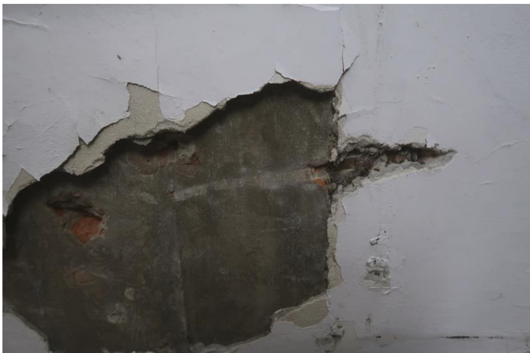
Fot. 88. Odkrywka O.78 stropu Kleina. Stwierdzono płyty gruzobetonowe. Tynk c-w gr. 1,5cm. Płyty oparte na dolnych półkach belek stalowych wykonanych z dwuteowników IPN280 osiatkowanych i skorodowanych powierzchniowo. Belki w rozstawie co ok. 160cm. W odkrywce stwierdzono zbrojenie płyty dołem prętami gładkimi \varnothing 6 w rozstawie co 10,0÷12,0cm (kierunek zbrojenia prostopadły do belek stropowych). Otulina zbrojenia wynosi 5mm.
