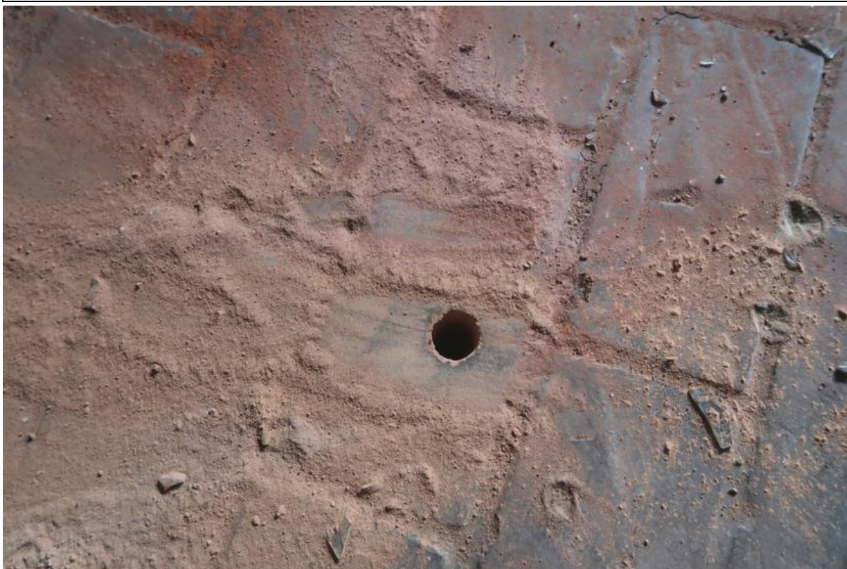
Fot. 128. Odkrywka O.10 posadzki. Stwierdzono posadzkę z płytek betonowych gr.2,5cm i wylewki gruzobetonowej o łącznej gr. 20,0cm, leżącej na podsypce piaskowej.
