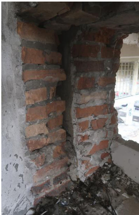
Fot. 53. Części A i B budynku są od siebie oddylatowane i posiadają oddzielne ściany szczytowe. Ściana części A jest otynkowana, co świadczy o jej wcześniejszym powstaniu. Dylatacja zlokalizowana jest w osiach numerowych 13-14.
