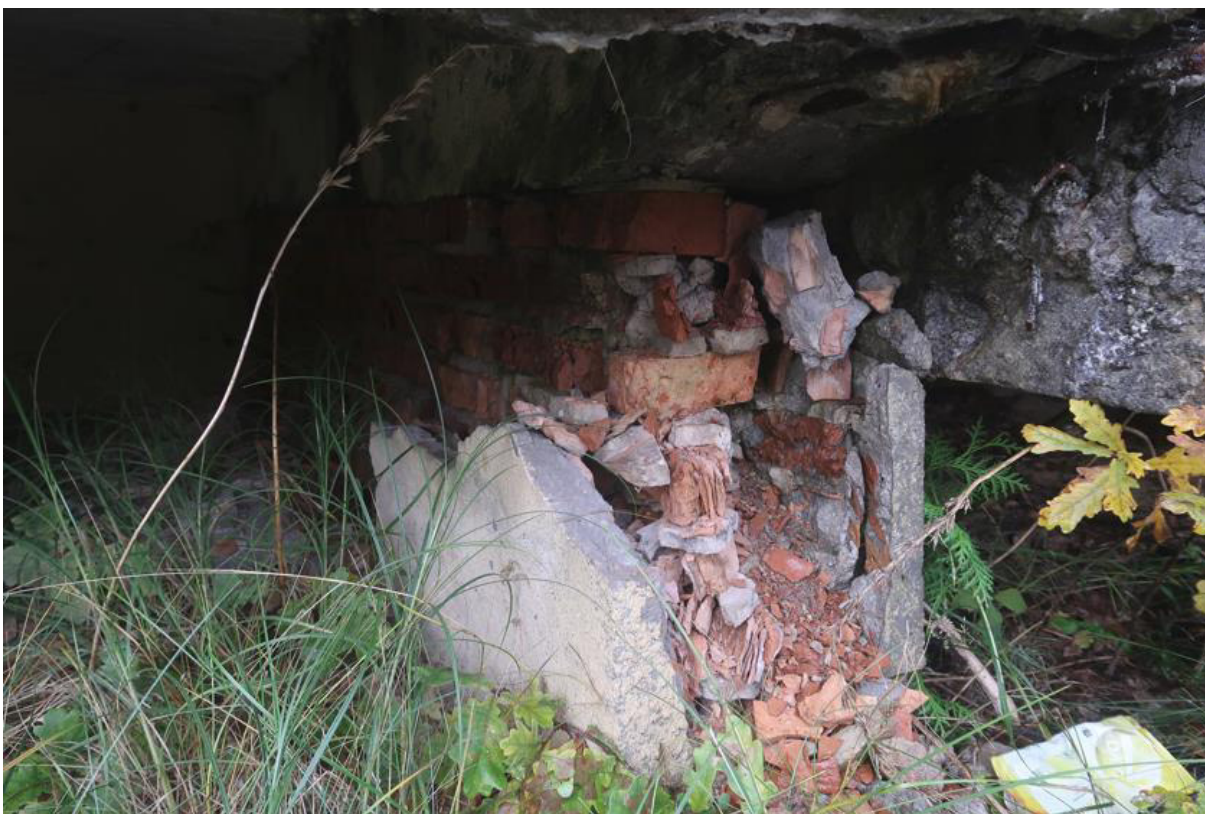
Fot. 39. Zerodowany mur ceglany pod rampą na wschodniej elewacji w osiach F'/14-15 części B budynku.
