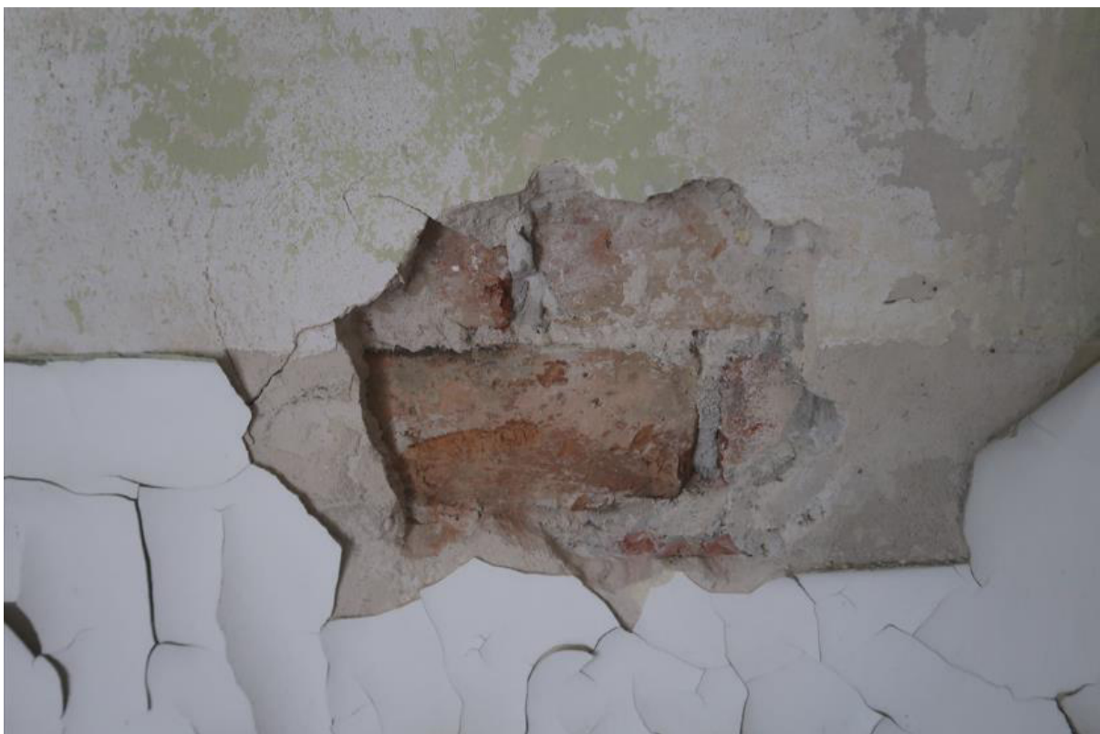
Fot. 29. Odkrywka O.71 ściany działowej. Stwierdzono konstrukcję ściany gr. 10cm z cegły ceramicznej pełnej murowanej na zaprawie cementowo-wapiennej. Tynk c-w gr. 2,0cm.
