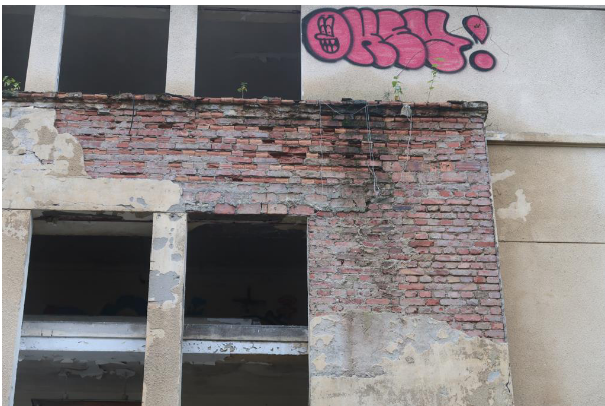
Fot. 31. Odparzony tynk na elewacji frontowej części A budynku. Widoczny odparzony tynk i erozja wierzchniej warstwy cegieł.
