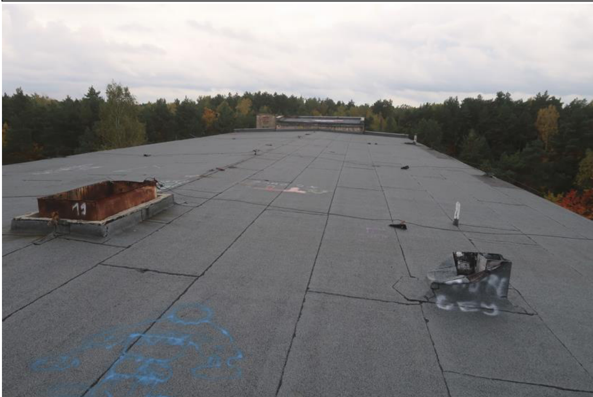
Fot. 170. Pokrycie stropodachu z papy w osiach A'-F'/15-22 części B przedmiotowego budynku. Widoczne zdemontowane elementy kominów instalacyjnych na dachu.
