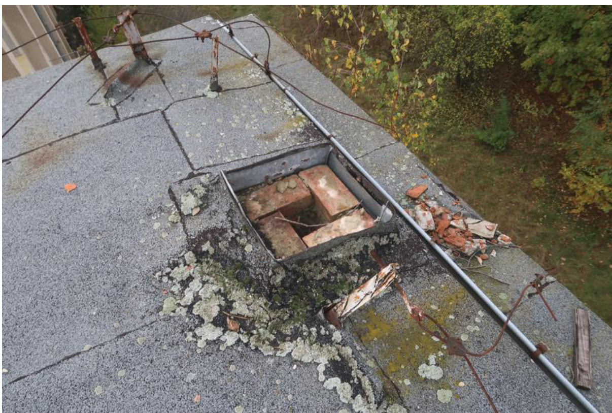
Fot. 176. Uszkodzony komin i zalegające luźne fragmenty cegieł i tynku przy krawędzi dachu w osiach E'-F'/15 (część B budynku).
