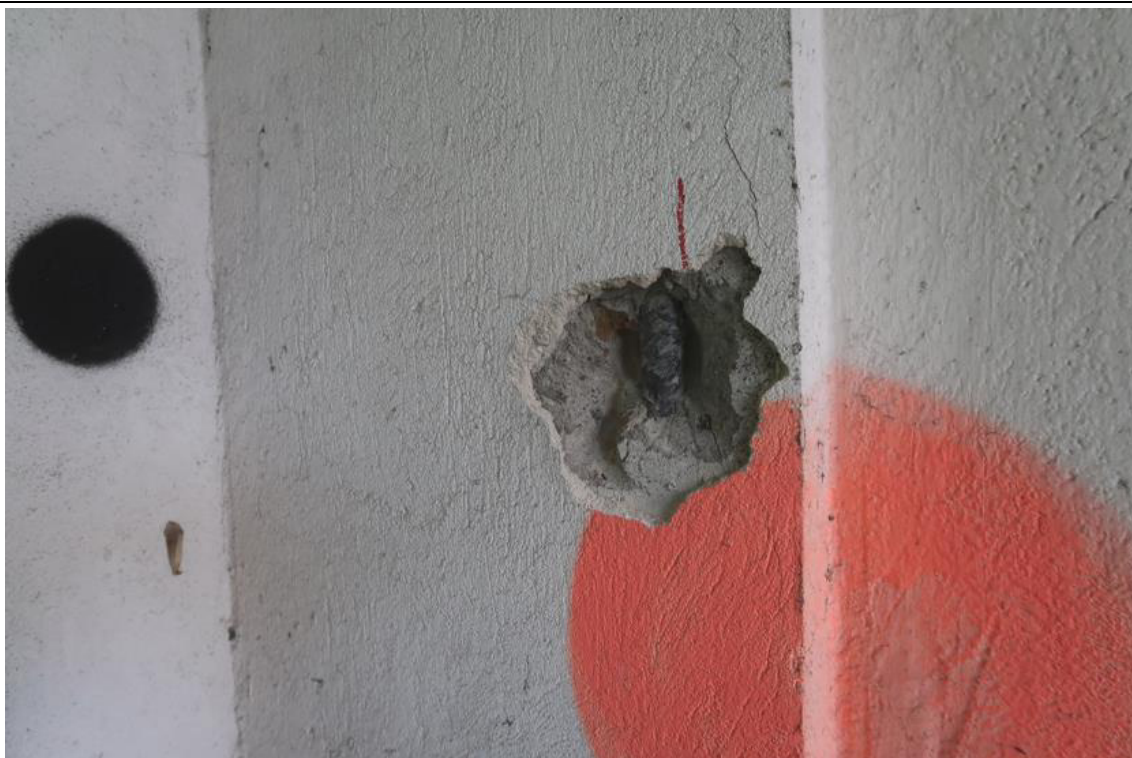
Fot. 109. Odkrywka O.14 słupa. W odkrywce stwierdzono słup żelbetowy, zbrojony podłużnie prętami żebrowanymi #20. Otulina zbrojenia wynosi 20\div40\text{mm} . Występuje karbonatyzacja betonu w warstwie otuliny zbrojenia. Do słupa z dwóch stron jest dostawiona ściana murowana z ceramicznej cegły pełnej.
