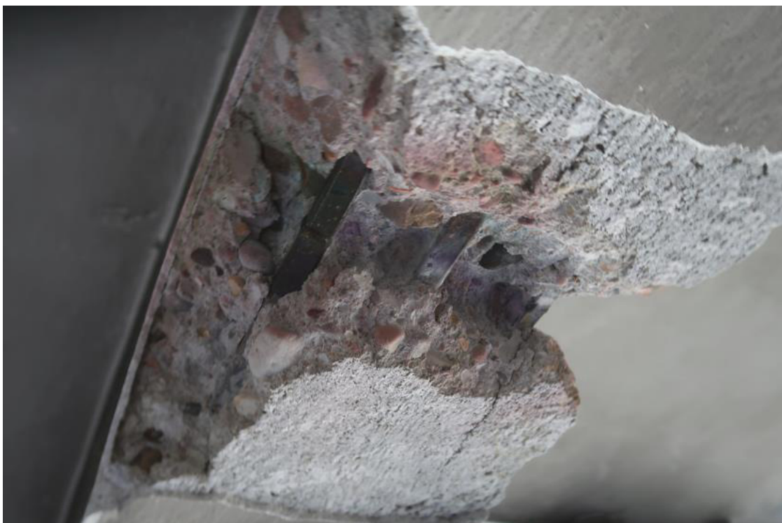
Fot. 64. Odkrywka O.30 żebra. W odkrywce stwierdzono żebro żelbetowe o przekroju 20,0x30,0cm (pomiar z tynkiem gr. 1,0cm, do spodu płyty stropowej), zbrojone podłużnie dołem prętami grzebieniowymi 3#12x12 (nr 18 wg [21]). Otulina zbrojenia wynosi 25mm. Beton jest niskiej jakości, słabo zagęszczony (z kawernami). Występuje karbonatyzacja betonu na gł. 4,0cm.
