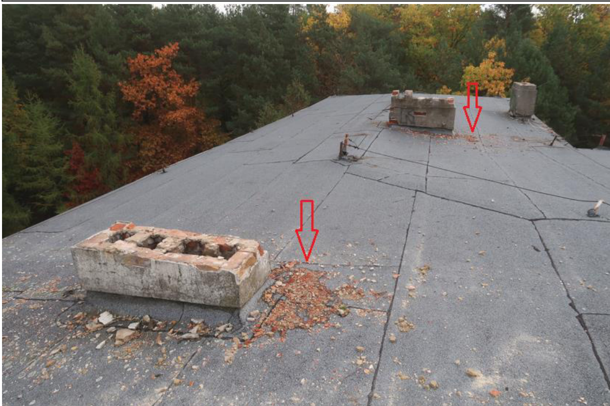
Fot. 175. Odparzony tynk na kominach zalegający na pokryciu i braki czap kominiarskich na dachu w osiach C-F/1-2 (część A budynku).
