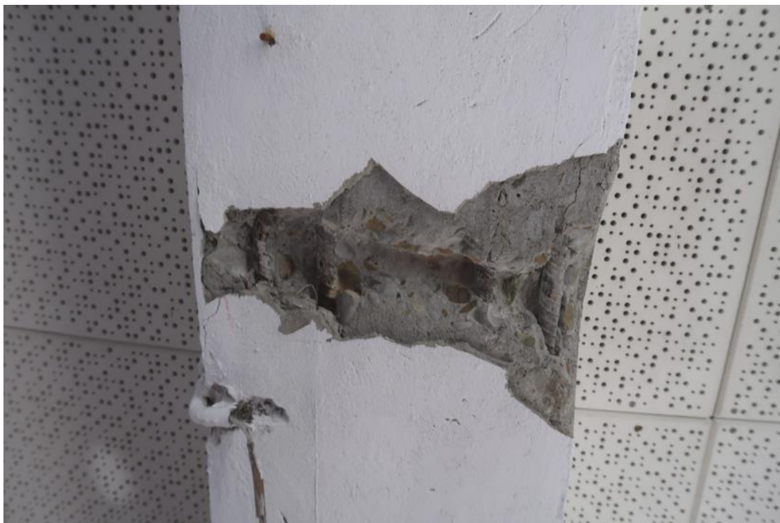
Fot. 68. Odkrywka O.43 podciagu. W odkrywce stwierdzono podciąg żelbetonowy o przekroju 35,0x40,5cm (pomiar z tynkiem gr. 1,0cm, do spodu płyty stropowej), zbrojony podłużnie dołem prętami żebrowanymi 4#18. Otulina zbrojenia wynosi 20mm. Występuje karbonatyzacja betonu.
