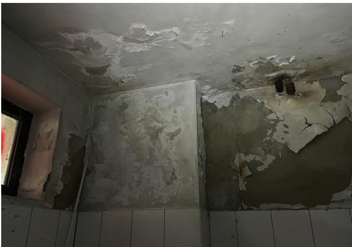
Fot. 45. Zawilgocenie oraz odparzona powłoka malarska i tynk na ścianach i na suficie w osiach E'-F'/22-23 w piwnicy, część B budynku.
