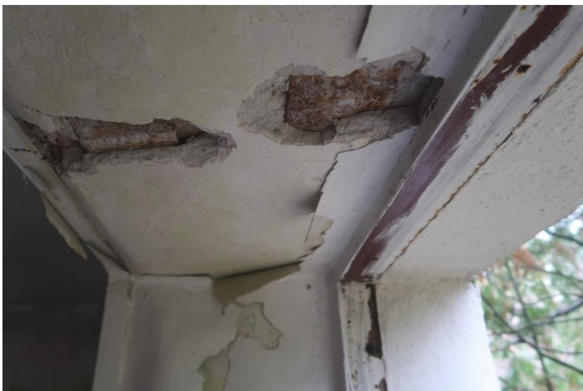
Fot. 54. Odkrywka O.72 nadproża. Stwierdzono nadproże z belek stalowych wykonanych z dwóch dwuteowników IPN200, skorodowanych powierzchniowo. Przestrzeń pomiędzy belkami wypełniona jest cegłą. Tynk c-w gr. 3,0cm.
