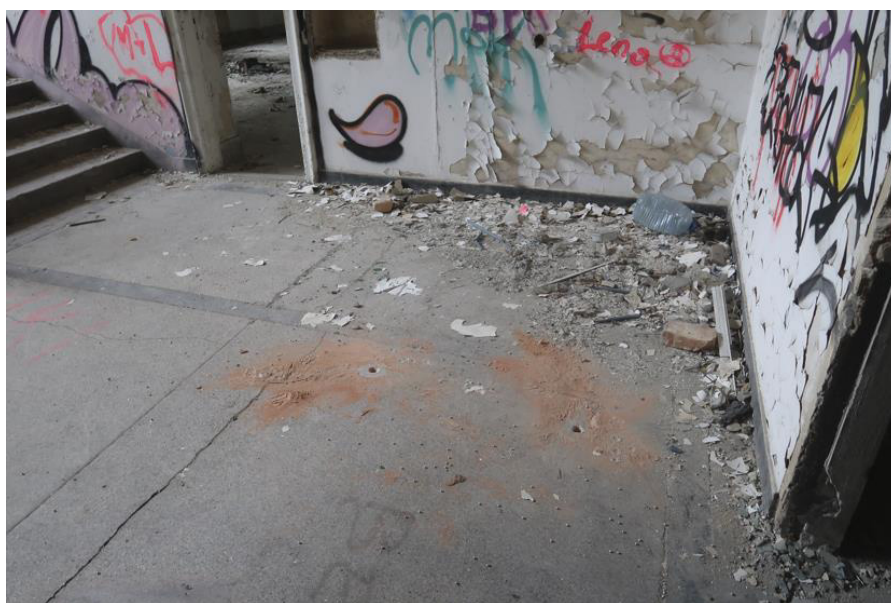
Fot. 125. Odkrywka O.7 posadzki. Stwierdzono posadzkę betonową gr. ok. 20cm z lastryko wykonaną na warstwie gruzobetonu leżącego na stropie nad piwnicą.
