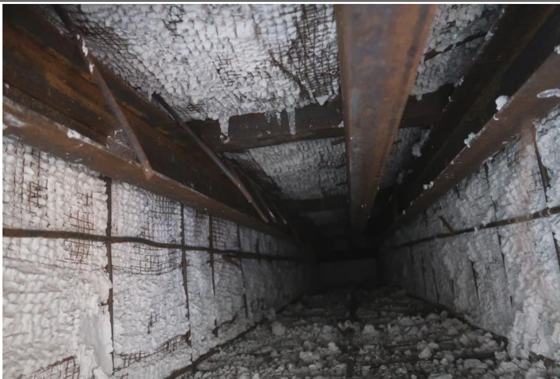
Fot. 65. Odkrywka O.38 rygla. W poziomie I piętra stwierdzono rygiel pomiędzy słupami ram żelbetowych wykonany z ceowników walcowanych, osiatkowany i otynkowany. Na ryglu zlokalizowana jest ścianka szklana.
