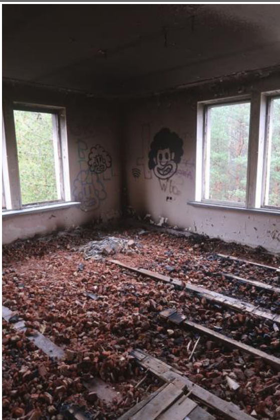
Fot. 103. Odsłonięte wierzchnie warstwy stropu po pożarze w pomieszczeniu w osiach D-F/1-2 na II piętrze (część A budynku).
