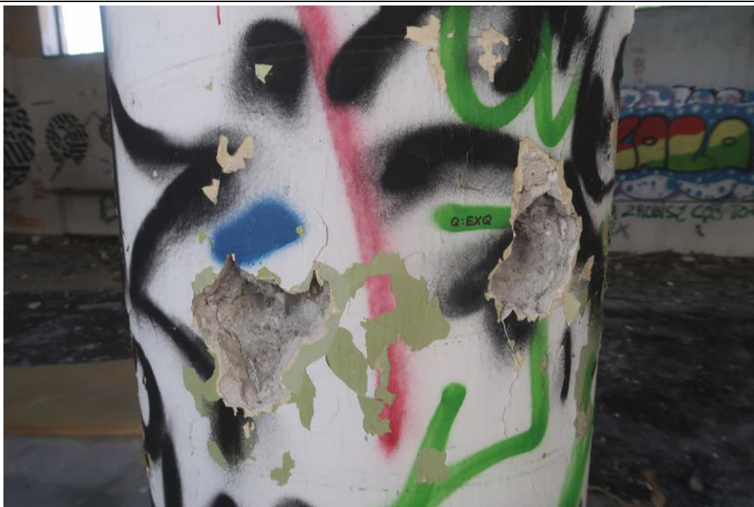
Fot. 115. Odkrywka O.33 słupa. W odkrywce stwierdzono słup żelbetowy o przekroju okrągłym \varnothing 52,0\text{cm} (pomiar z tynkiem gr. 1,0 \div 2,0\text{cm} ), zbrojony podłużnie prętami grzebieniowymi 6#20x20 (nr 30 wg [21]). Otulina zbrojenia wynosi 20 \div 30\text{mm} . Beton jest niskiej jakości. Występuje karbonatyzacja betonu na gł. 2,0\text{cm} .
