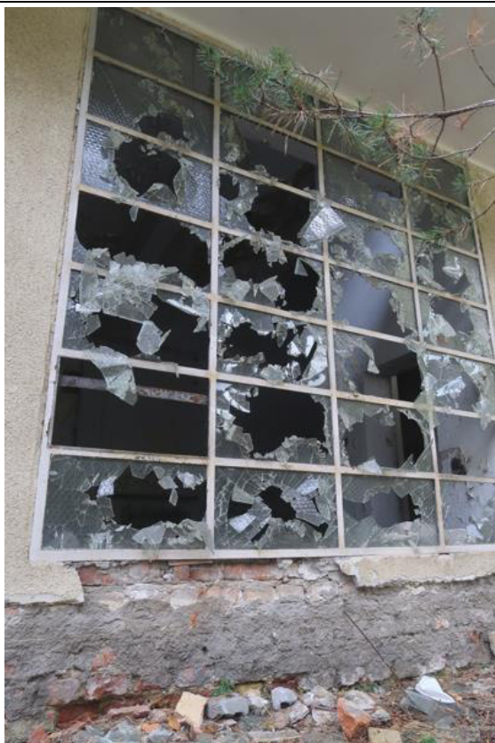
Fot. 163. Ubytki w szkleniu stalowej stolarki okiennej na wschodniej elewacji w osiach E/1-4 części A budynku.
