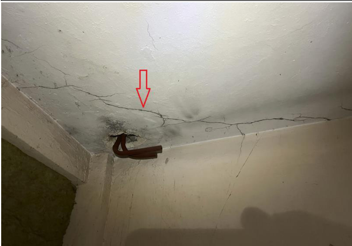
Fot. 95. Zarysowanie na suficie w narożu ścian w osiach B'/15 w piwnicy (część B budynku).
