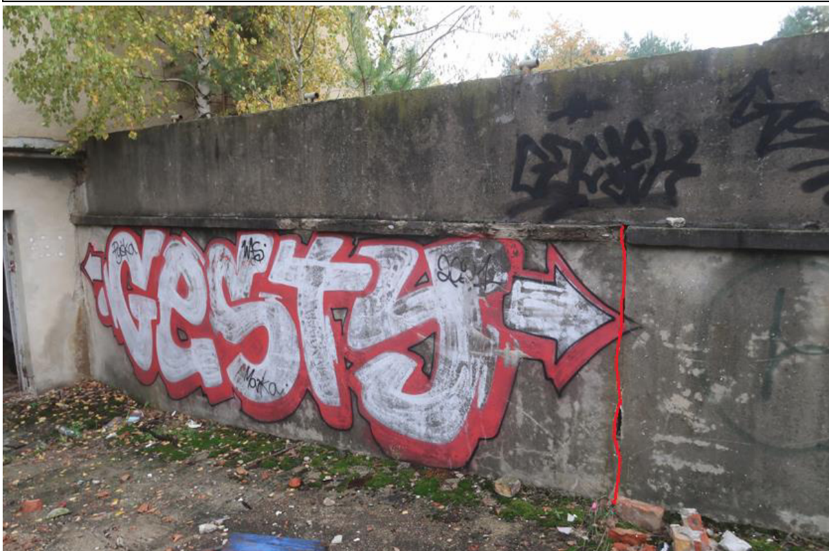
Fot. 36. Zarysowanie pionowe na murze oporowym przy południowej elewacji budynku B.
