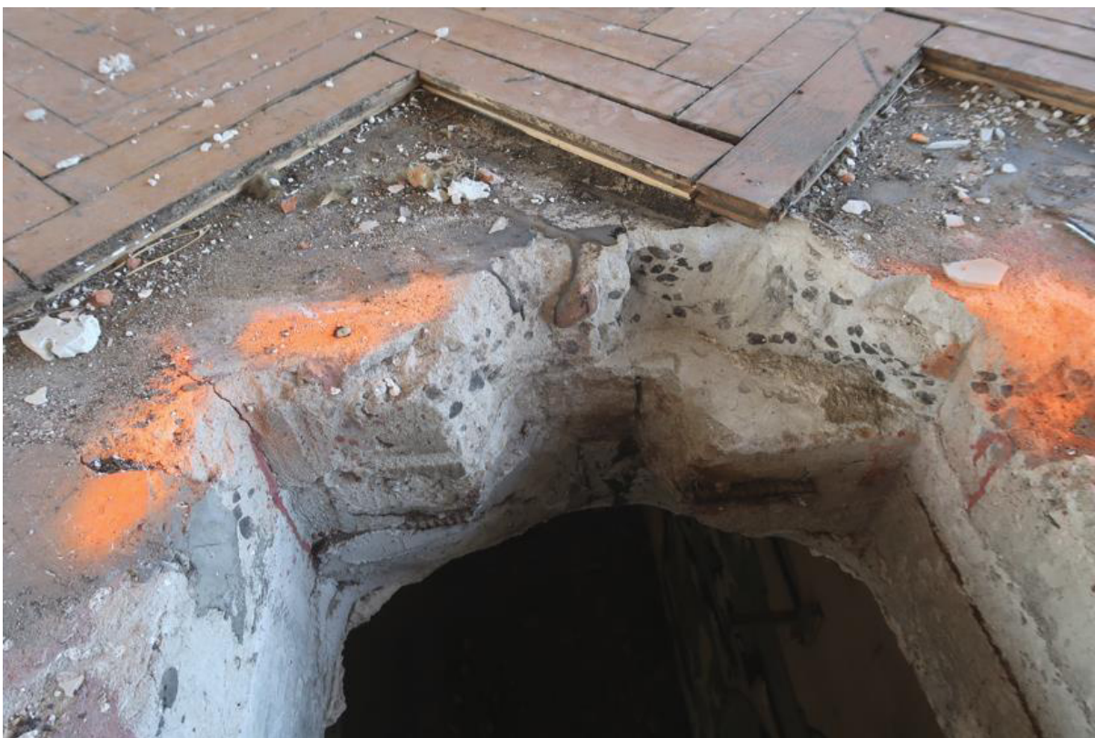
Fot. 137. Odkrywka O.44 posadzki. Stwierdzono parkiet gr.2,0cm (klejony lepikiem smołowym) i wylewkę betonową gr. 10,0cm leżącą na stropie (płyta żelbetowa gr. 17,0cm).
