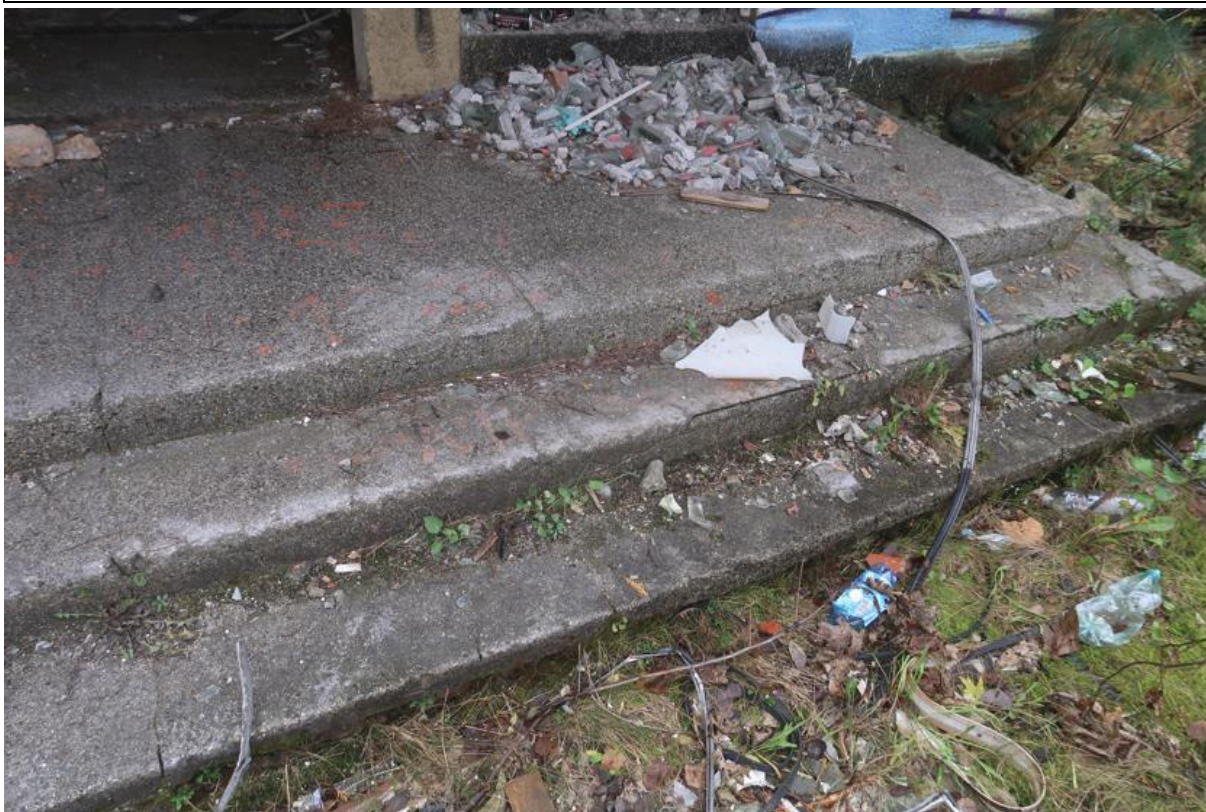
Fot. 151. Zerodowane betonowe schody terenowe przed wejściem głównym do budynku na północnej elewacji (część A).
