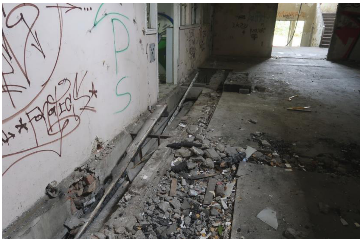
Fot. 149. Zagracony kanał techniczny w części komunikacyjnej w osiach C/5-6 na parterze (część A budynku).
