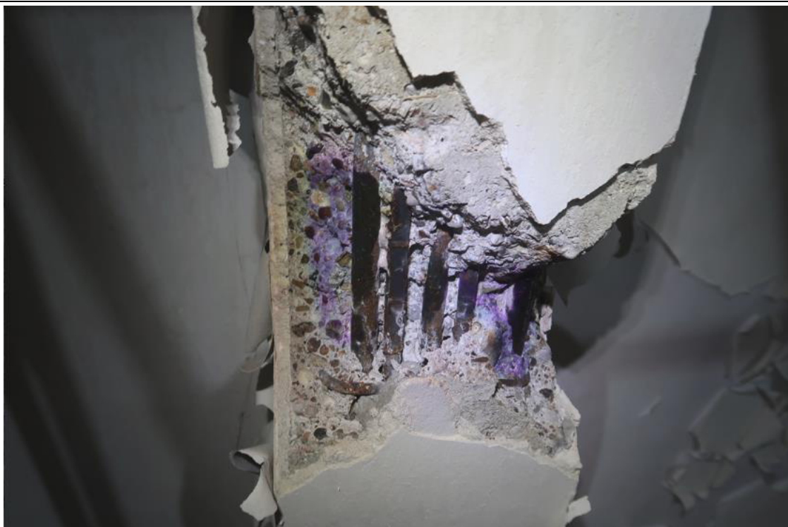
Fot. 71. Odkrywka O.47 żebra. W odkrywce stwierdzono żebro żelbetowe o przekroju 22,0x30,0cm (pomiar z tynkiem gr. 1,0cm, do spodu płyty stropowej), zbrojone podłużnie dołem prętami grzebieniowymi 2#12x12 (nr 18 wg [21]) i gładkimi 2Ø18 oraz 1Ø14. Strzemiona Ø8. Otulina zbrojenia wynosi 35mm. Beton jest niskiej jakości, słabo zagęszczony (z kawernami). Występuje karbonatyzacja betonu na gł. 3,0÷4,0cm.
