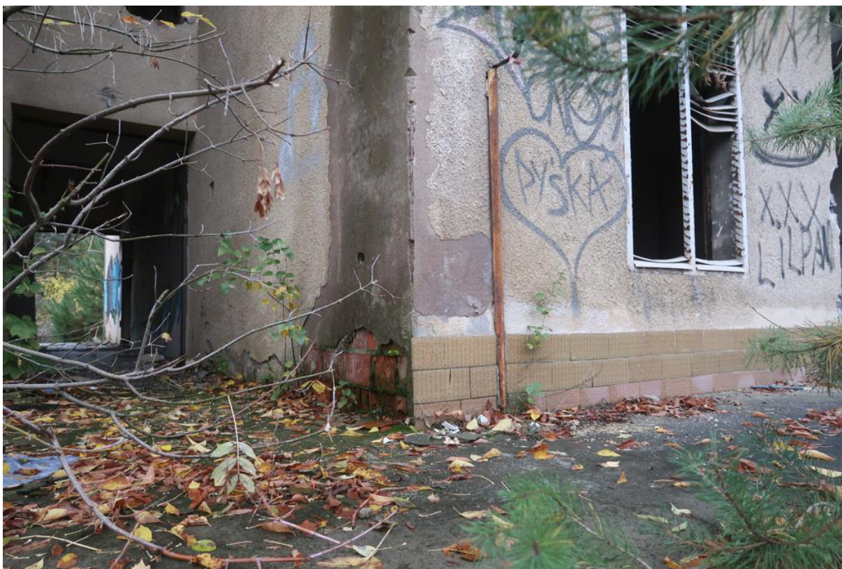
Fot. 37. Odparzony tynk i płytki cokołu w narożniku budynku B na wschodniej elewacji w osiach F'/22.
