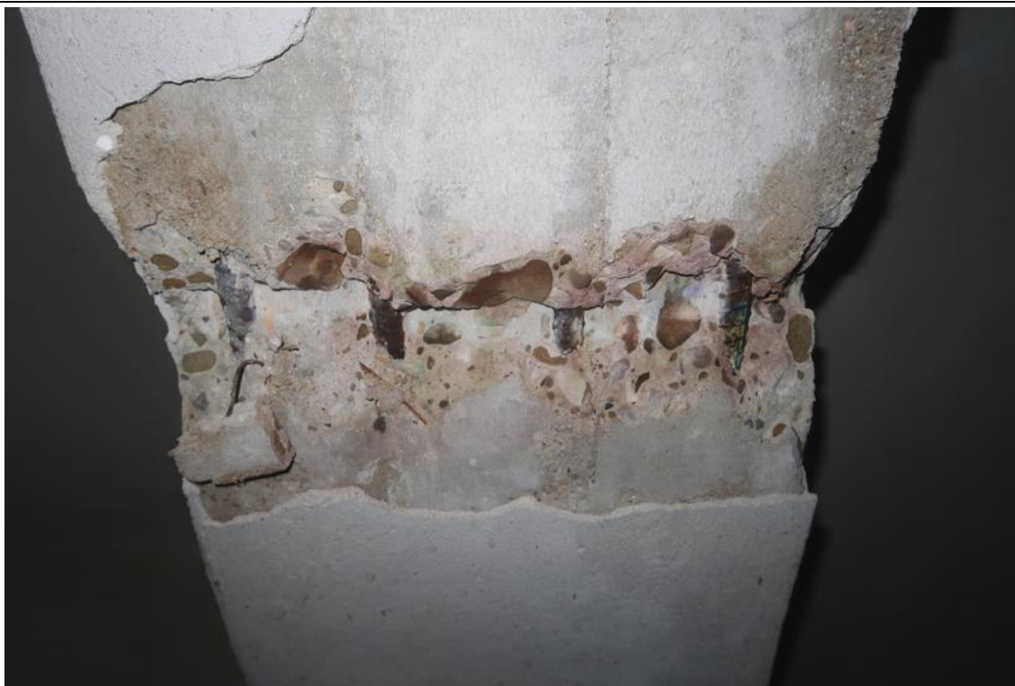
Fot. 59. Odkrywka O.20 podciagu. W odkrywce stwierdzono podciąg żelbetonowy o przekroju 41,0x54,0cm (pomiar z tynkiem gr. 1,0cm, do spodu płyty stropowej), zbrojony podłużnie dołem prętami żebrowanymi 4#20. Otulina zbrojenia wynosi 20mm. Występuje karbonatyzacja betonu.
