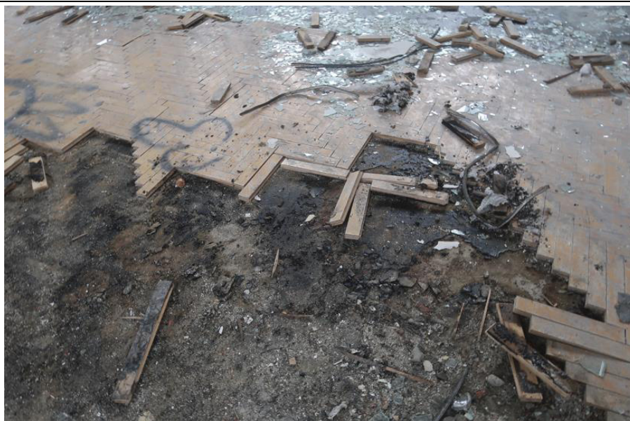
Fot. 150. Parkiet na lepiku smołowym w pomieszczeniu w osiach A-C/2-6 na parterze (część A budynku).
