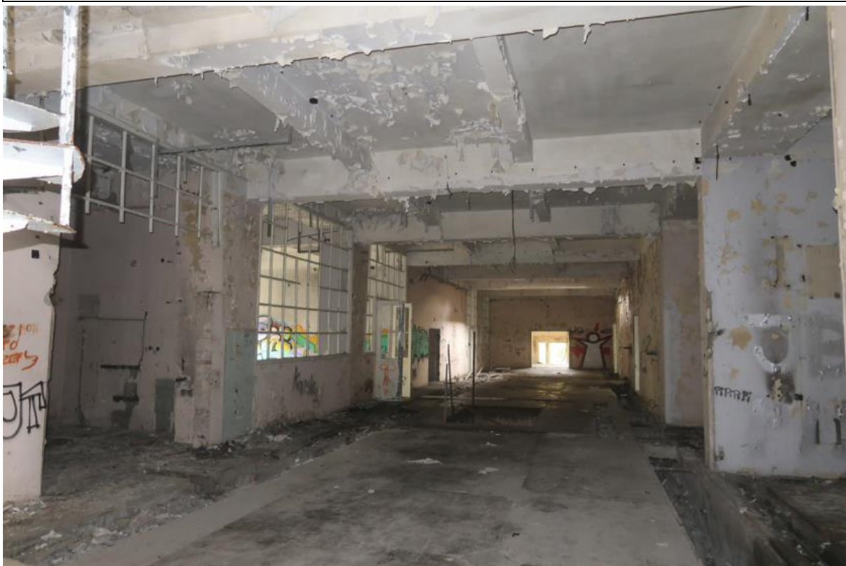
Fot. 97. Odparzona powłoka malarska na belkach i spodzie płyty stropowej w przestrzeni komunikacyjnej w osiach 3-9 części A budynku na parterze.
